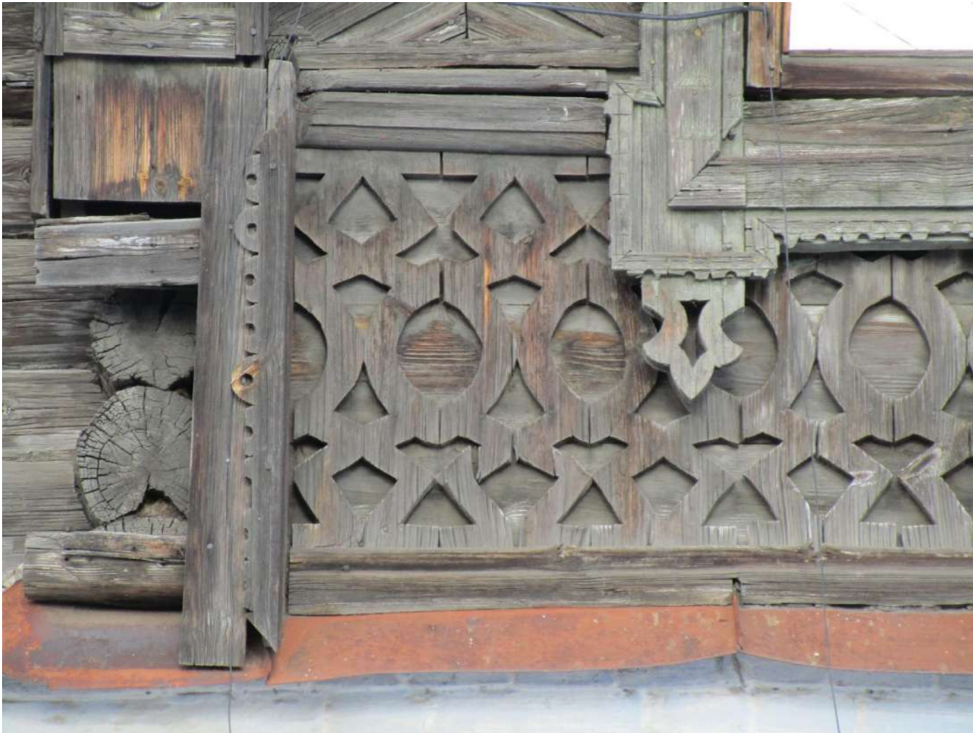
18. Южный фасад. Фрагмент. Октябрь 2023 г.
