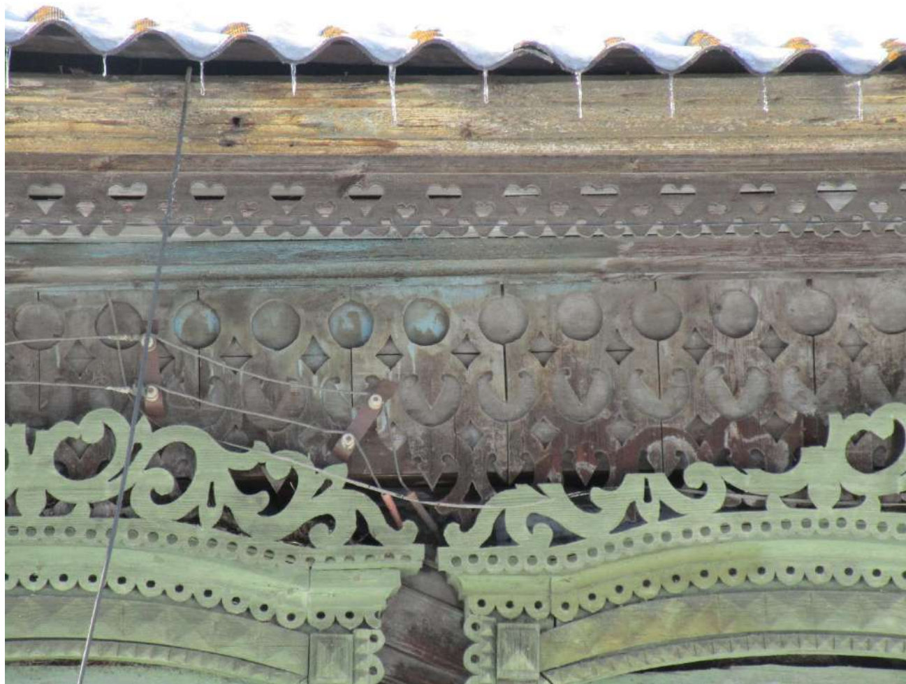
15. Фрагмент восточного фасада. Подкарнизный подзор. Подкарнизный фриз. Октябрь 2023 г.
