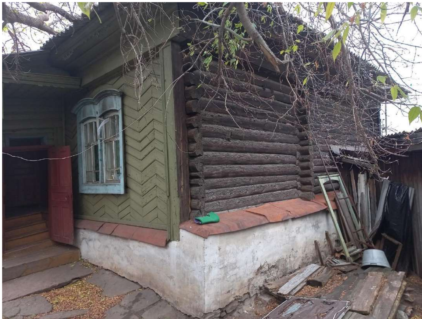
10. Западный дворовой фасад (справа). Открытые выпуски бревен сруба. Рубка «в охлоп». Октябрь 2023 г.
