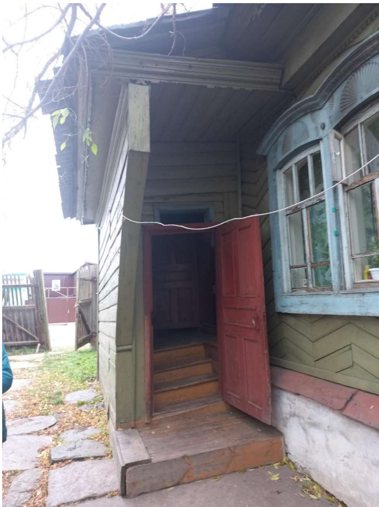
19. Входной деревянный тамбур. Профилированный карниз. Октябрь 2023 г.
