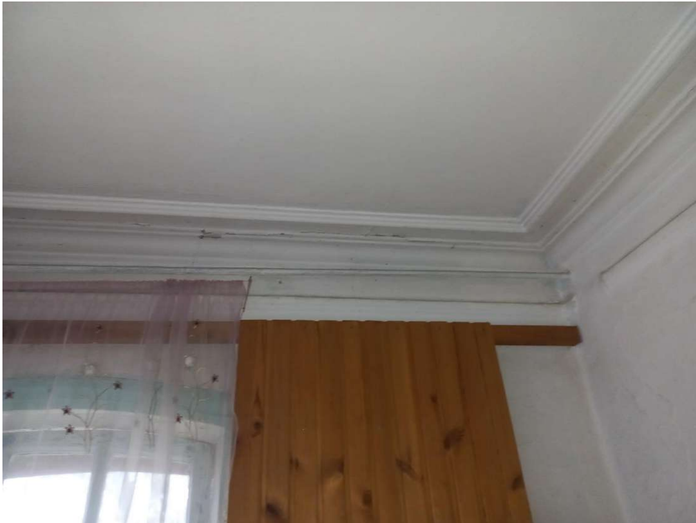
22. Интерьер. Потолочный карниз. Октябрь 2023 г.
