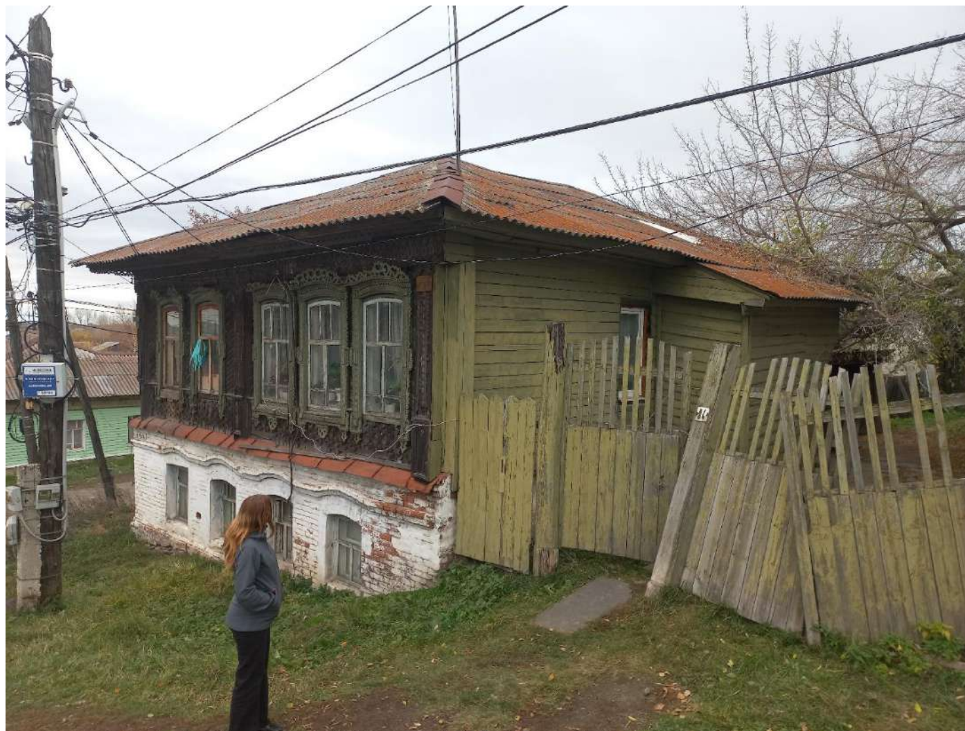
3. Вид с северо-востока. Ворота. Октябрь 2023 г.
