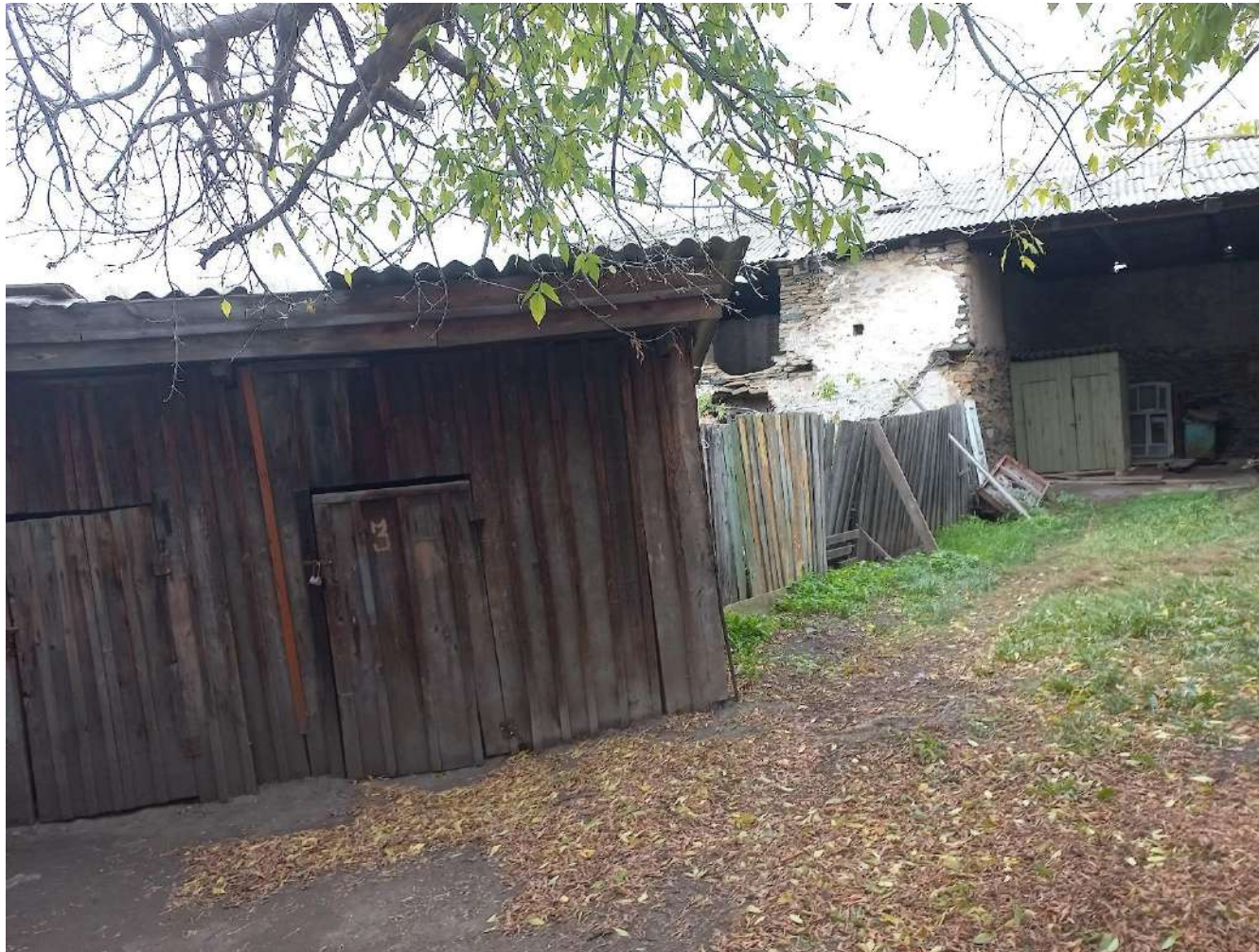
24. Территория объекта. Дворовая территория. Вид на здание каменных служб (справа). Октябрь 2023 г.
