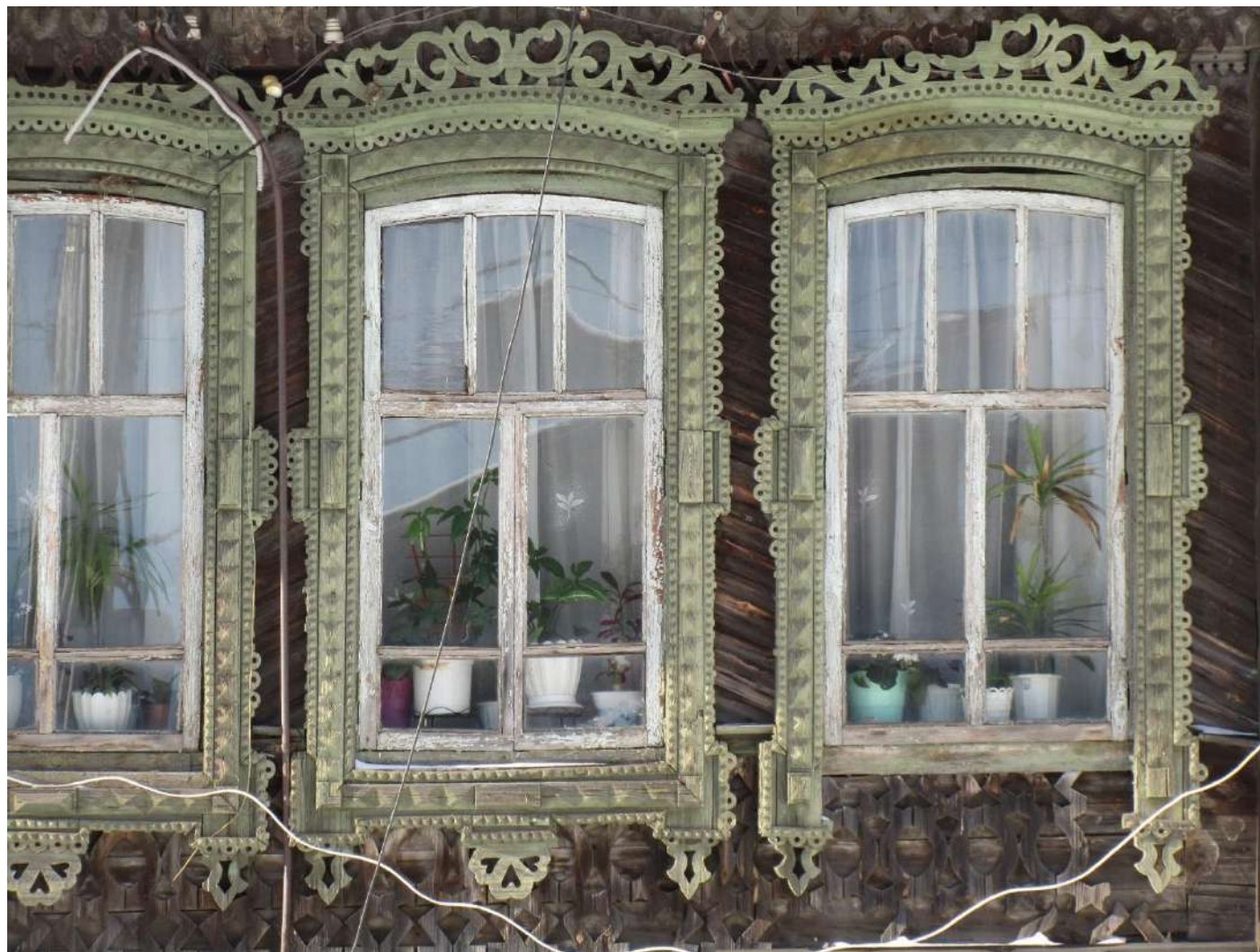
14. Фрагмент восточного фасада. Оконные наличники. Оконные переплеты. Октябрь 2023 г.
