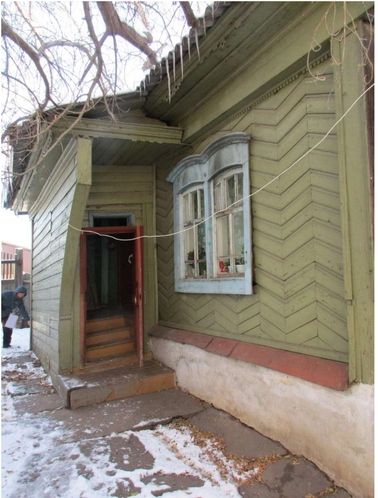
9. Дворовой северный фасад. Входной тамбур со скругленным фигурным бортиком-консолью по мотивам помочей. Наличник сдвоенного окна. Каменное мощение. Октябрь 2023 г
