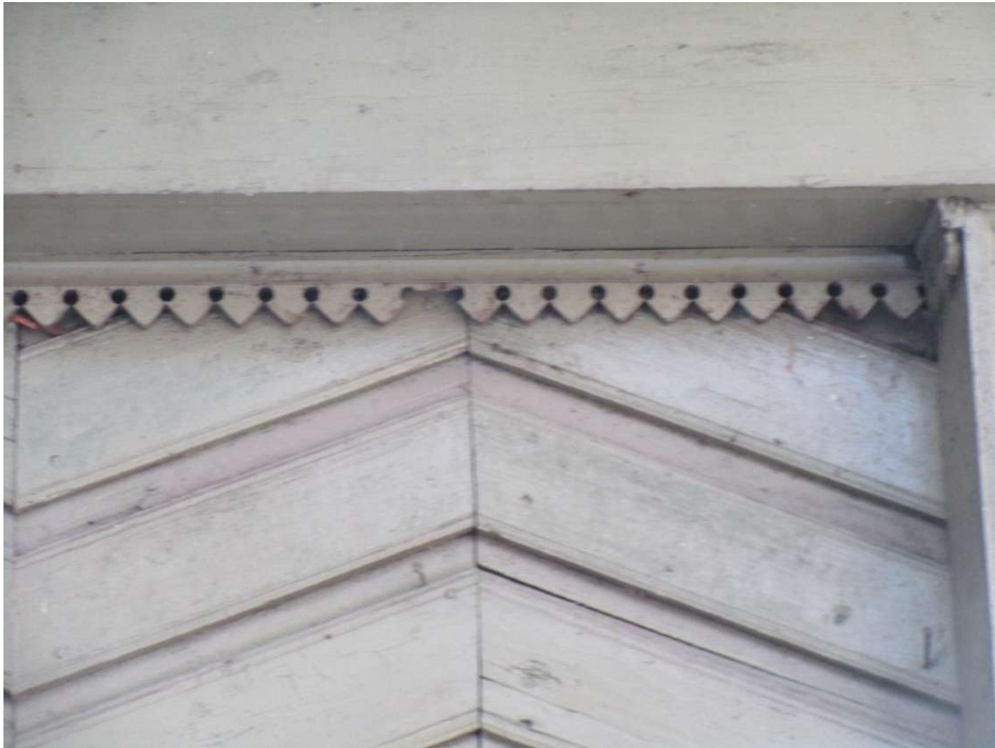
12. Фрагмент северного дворового фасада. Обшивка фасада «в елочку». Резной поясок под подшивным фризом.
