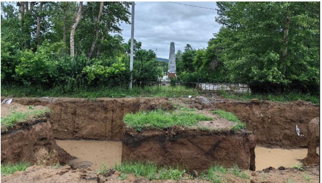
Фото 14. Видовая точка №8. Вид с востока от траншеи теплотрассы
