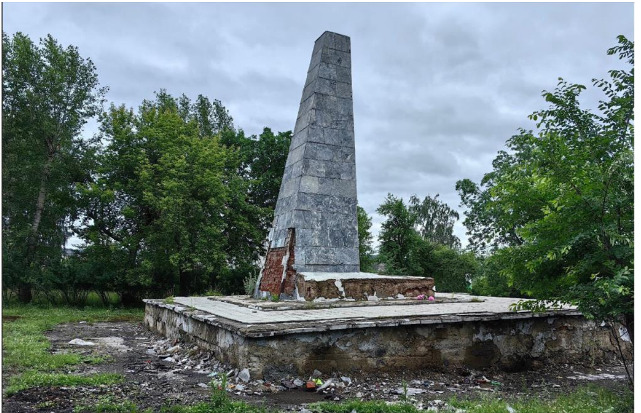
Фото 23. Видовая точка №17. Вид с севера площадки вокруг монумента
