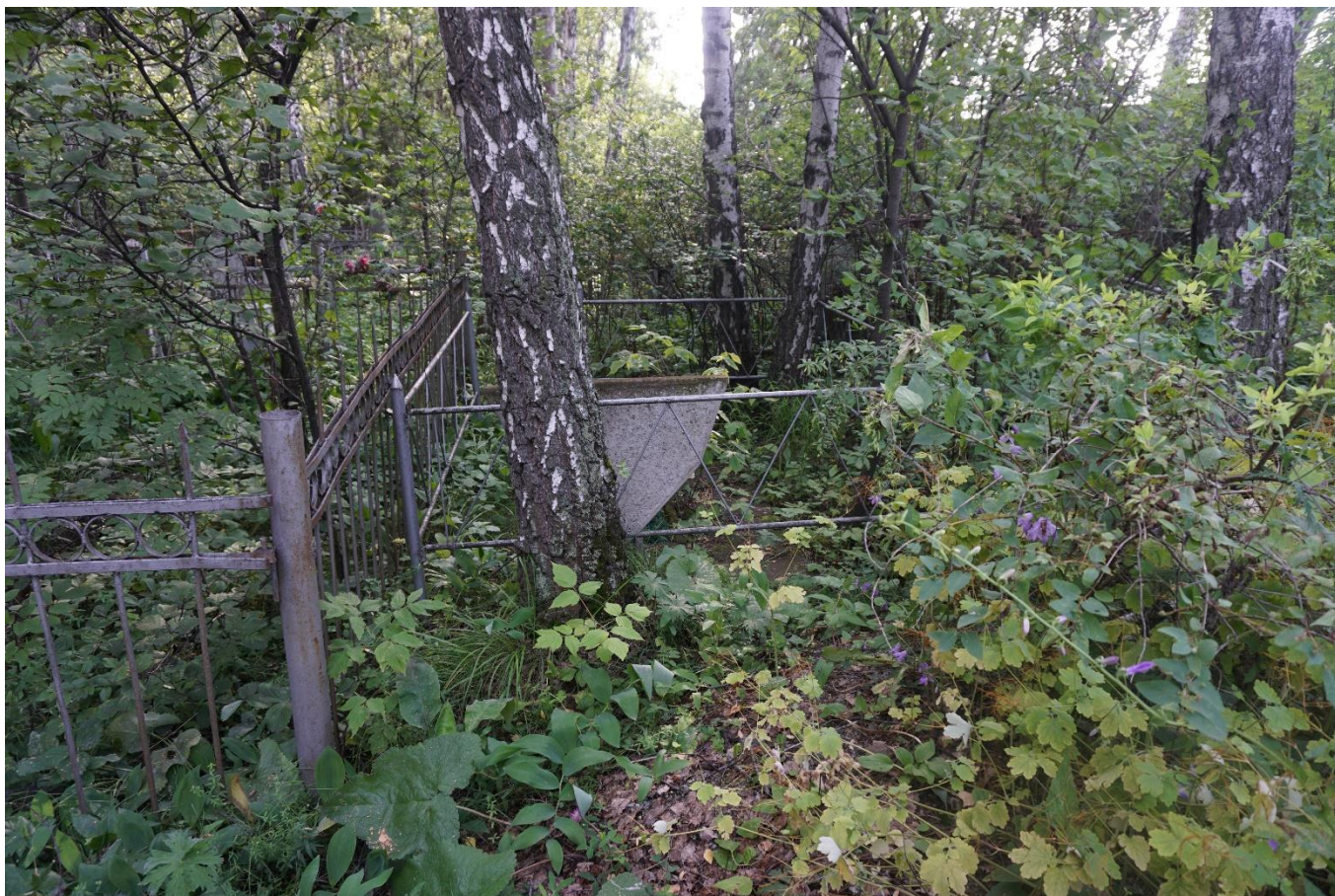
Фото 4. Вид на выявленный объект культурного наследия «Могилы водолаза М.А. Жигалова», расположенный по адресу: Челябинская область, Озерский городской округ, г. Озерск, старое городское кладбище, северный квартал.
