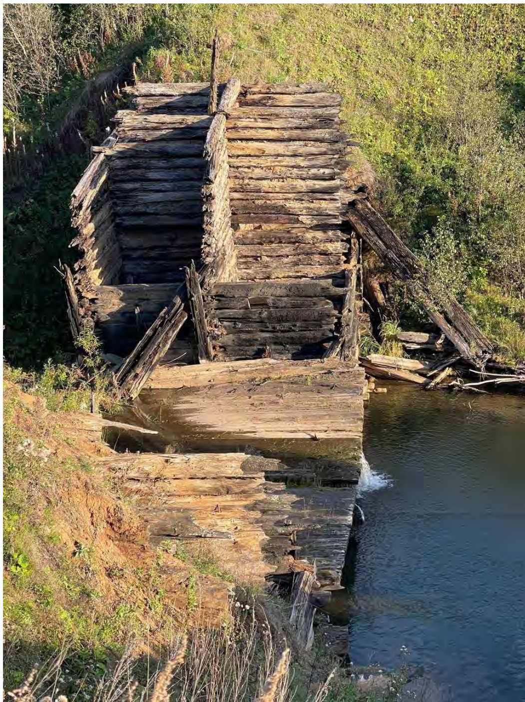
Фото.6. Вид на объект «Плотина», расположенный по адресу: Нязепетровский муниципальный район, д. Шемаха.
