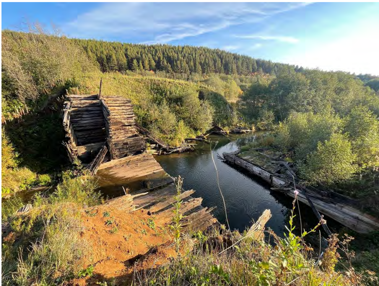
Фото.2. Вид на объект «Плотина», расположенный по адресу: Нязепетровский муниципальный район, д. Шемаха.
