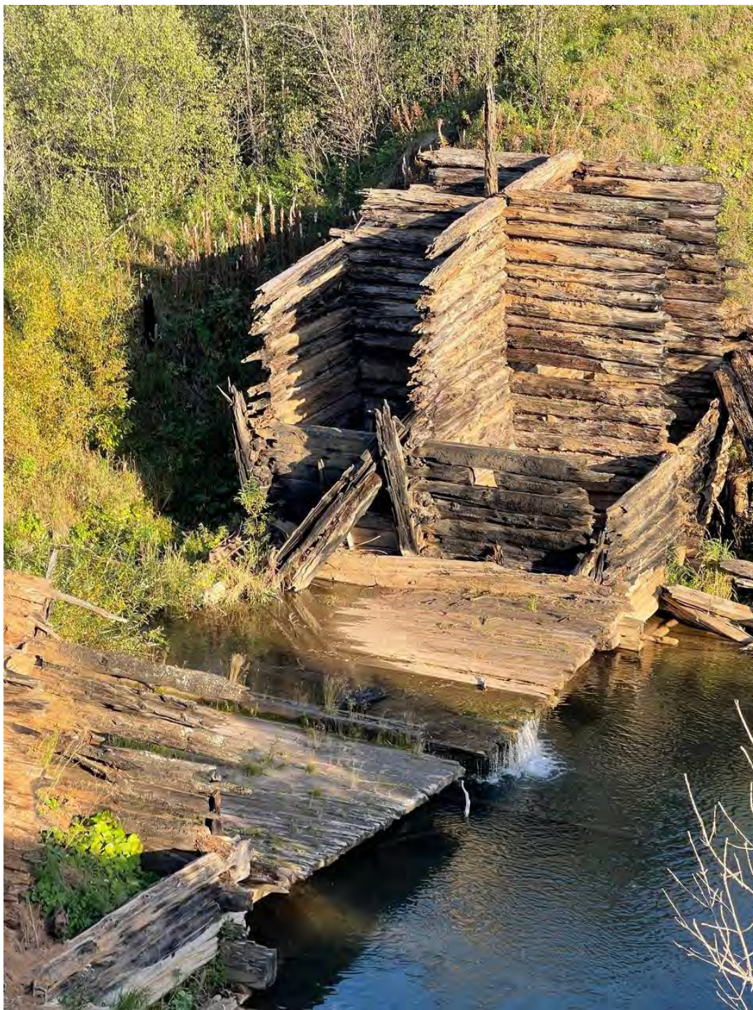
Фото.10. Вид на объект «Плотина», расположенный по адресу: Нязепетровский муниципальный район, д. Шемаха.
