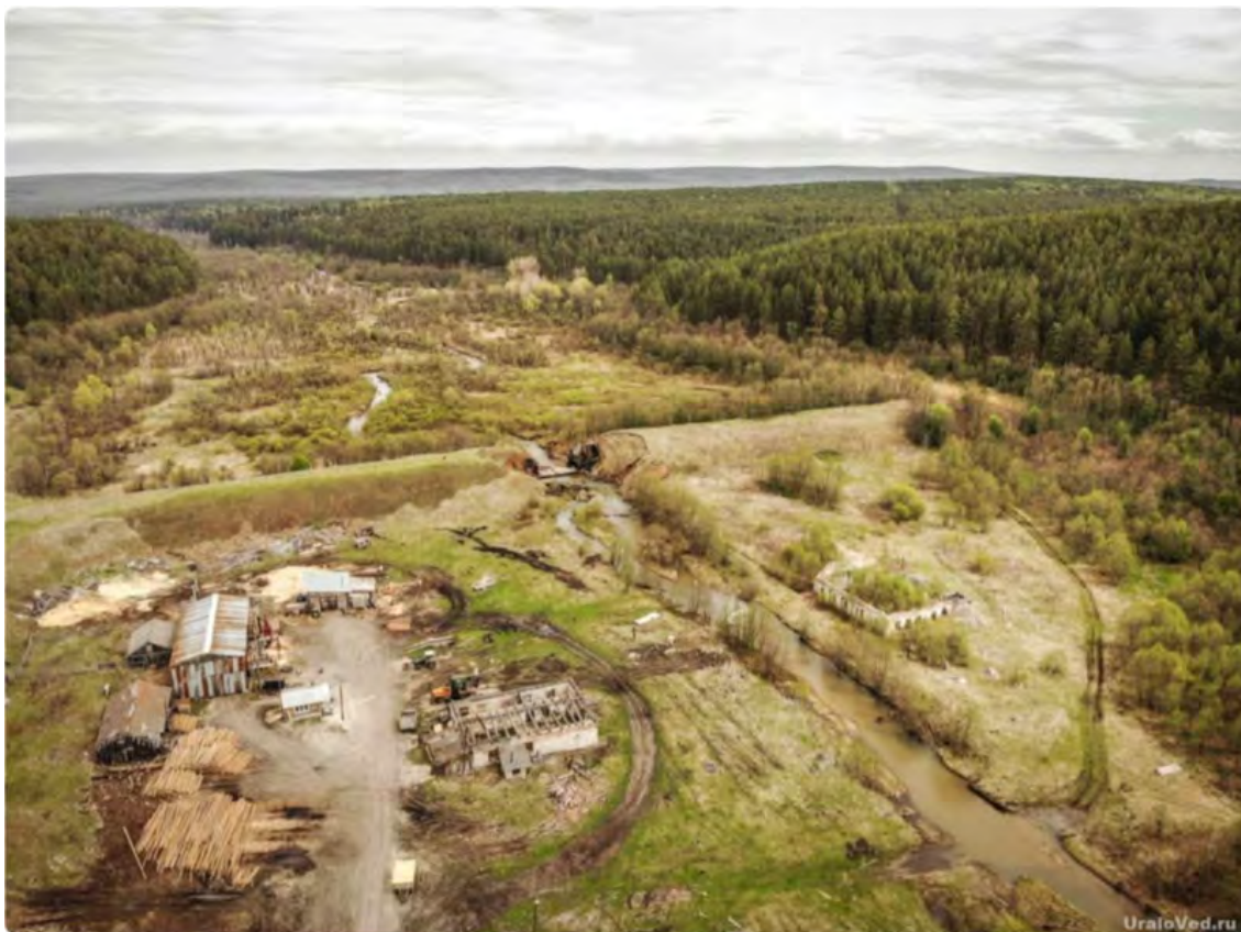
Рис.3. Фотография заводской плотины, 2018 г.
