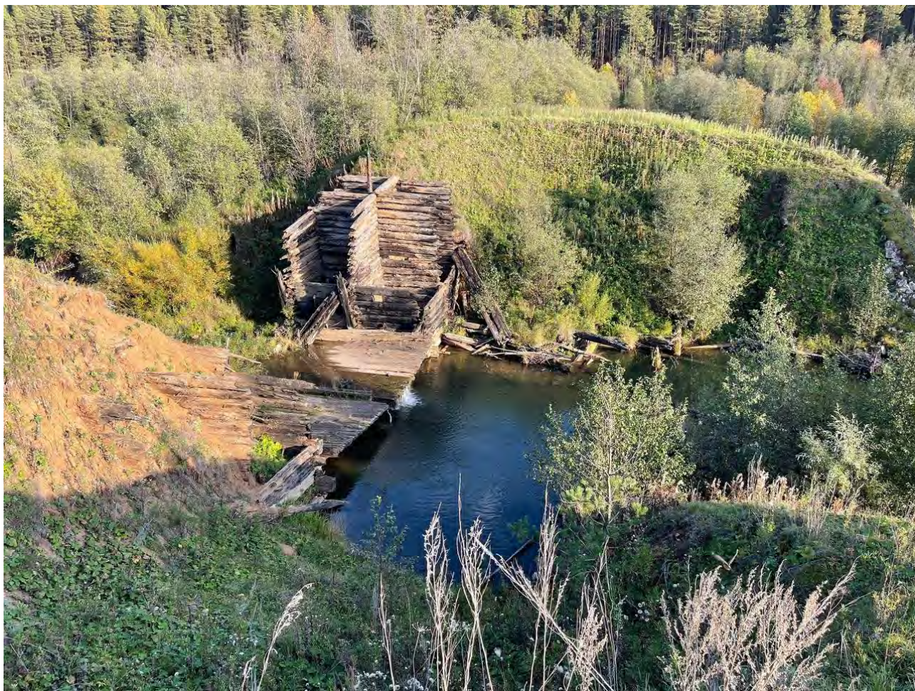
Фото.1. Вид на объект «Плотина», расположенный по адресу: Нязепетровский муниципальный район, д. Шемаха.
