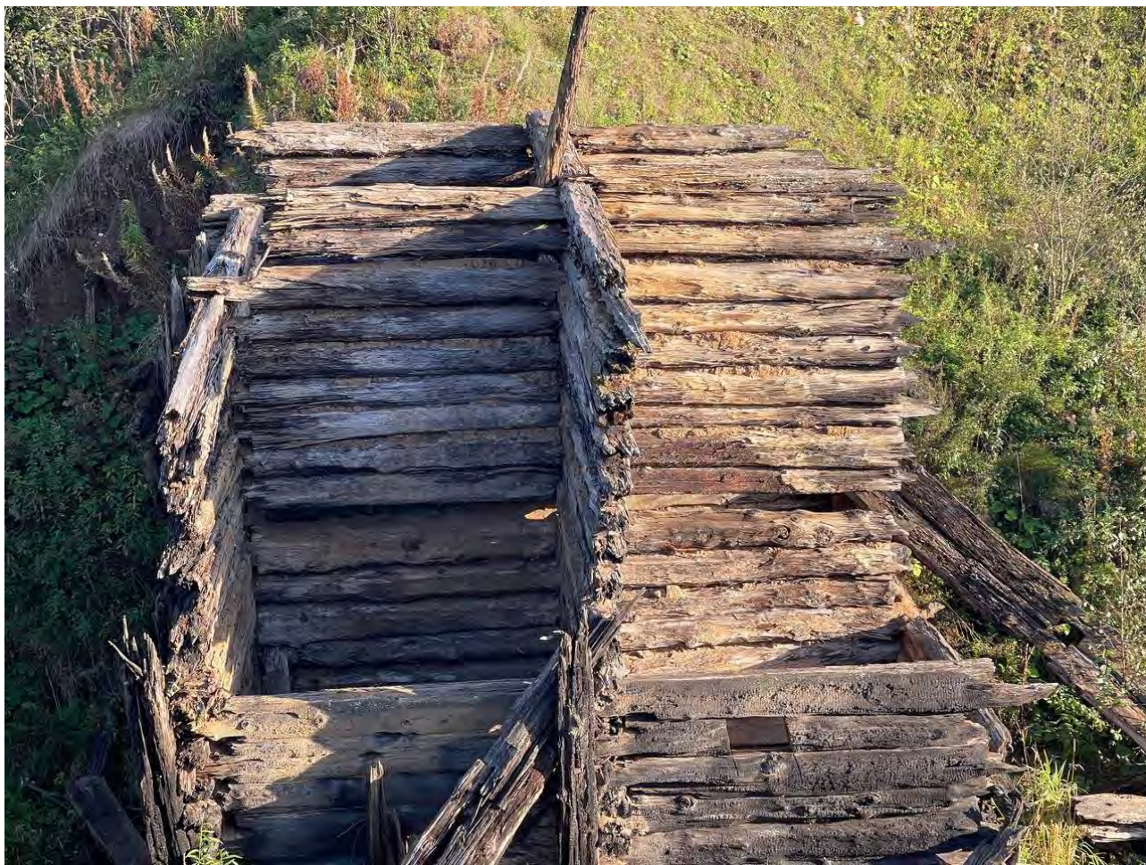
Фото.7. Вид на объект «Плотина», расположенный по адресу: Нязепетровский муниципальный район, д. Шемаха.
