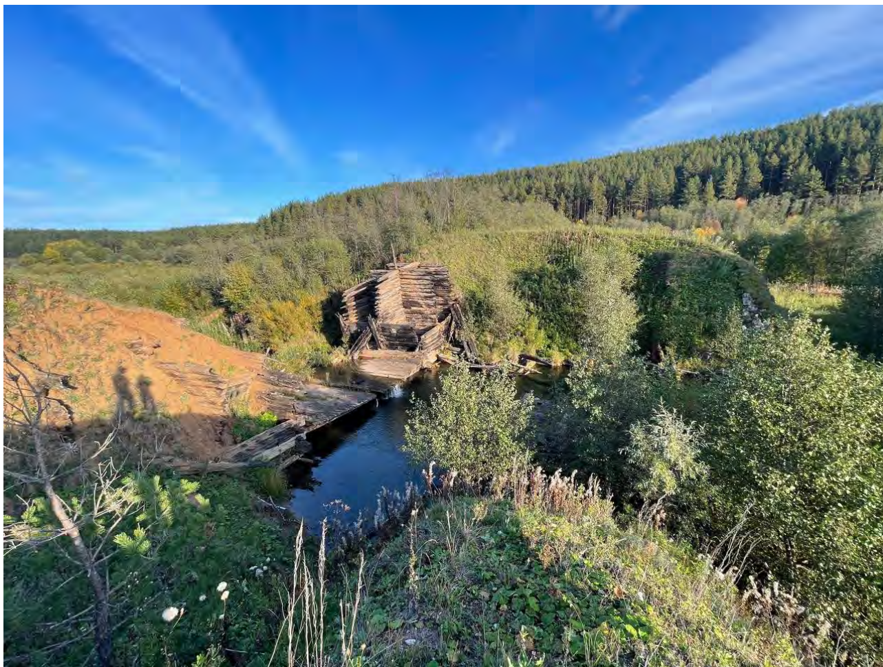
Фото.4. Вид на объект «Плотина», расположенный по адресу: Нязепетровский муниципальный район, д. Шемаха.
