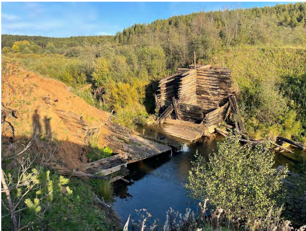
Фото.5. Вид на объект «Плотина», расположенный по адресу: Нязепетровский муниципальный район, д. Шемаха.
