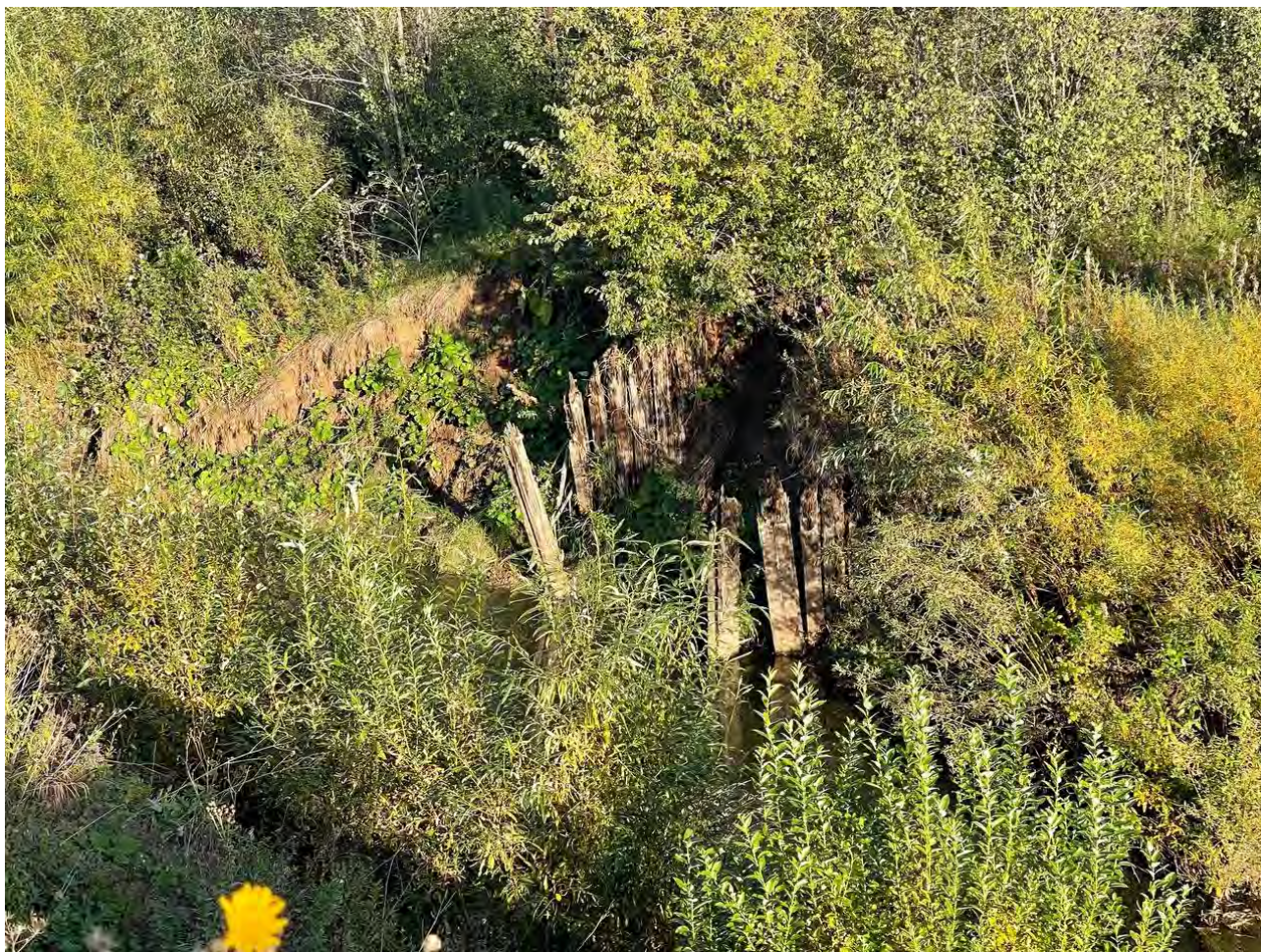
Фото.9. Вид на объект «Плотина», расположенный по адресу: Нязепетровский муниципальный район, д. Шемаха.
