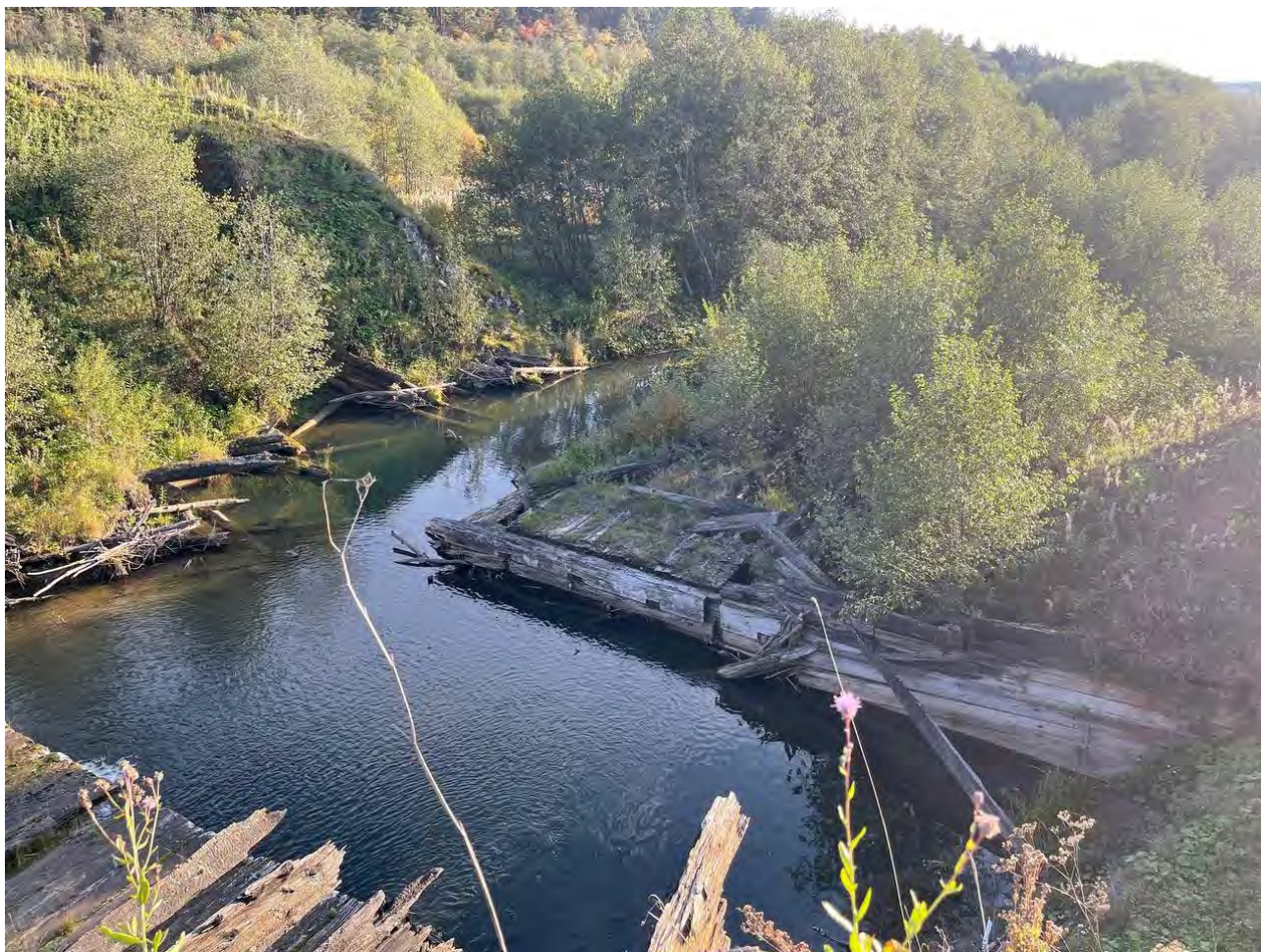
Фото.3. Вид на объект «Плотина», расположенный по адресу: Нязепетровский муниципальный район, д. Шемаха.
