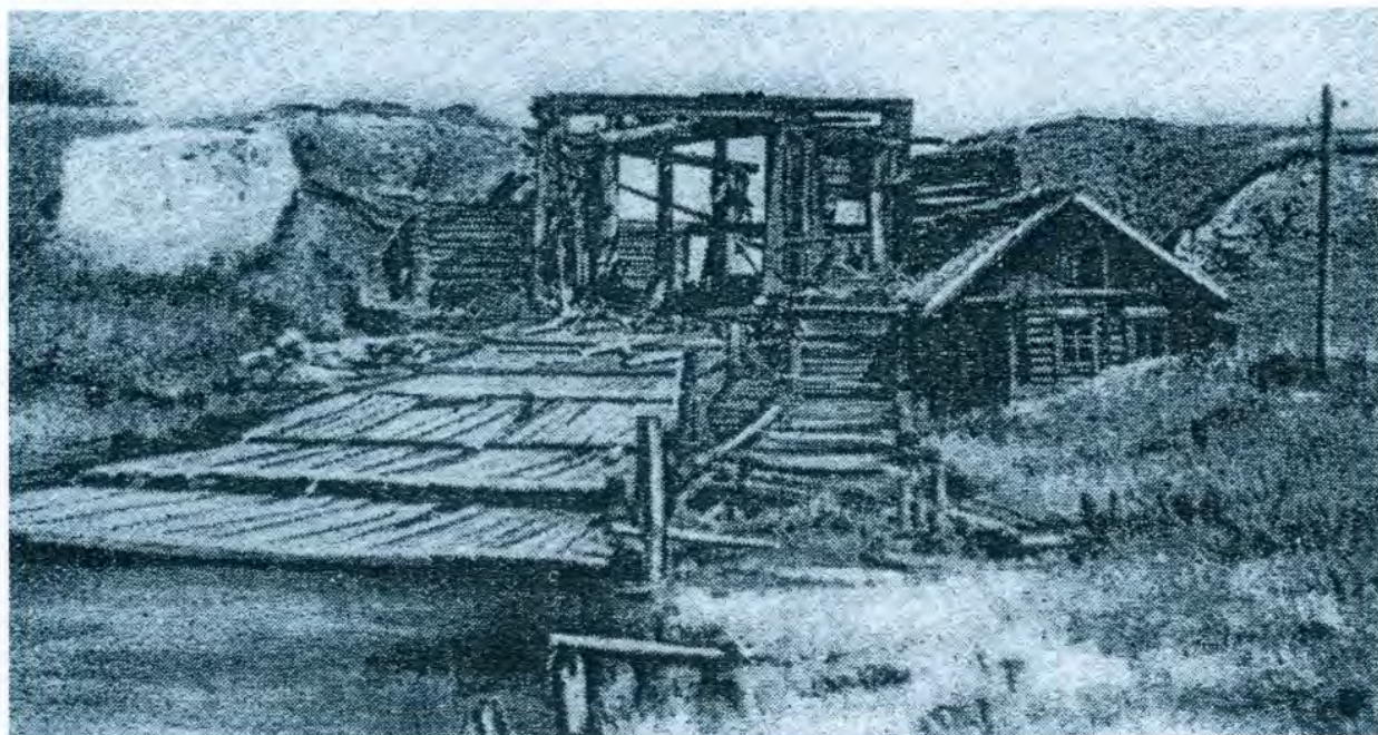
Остатки заводской плотины. 60-е годы (старое фото)
