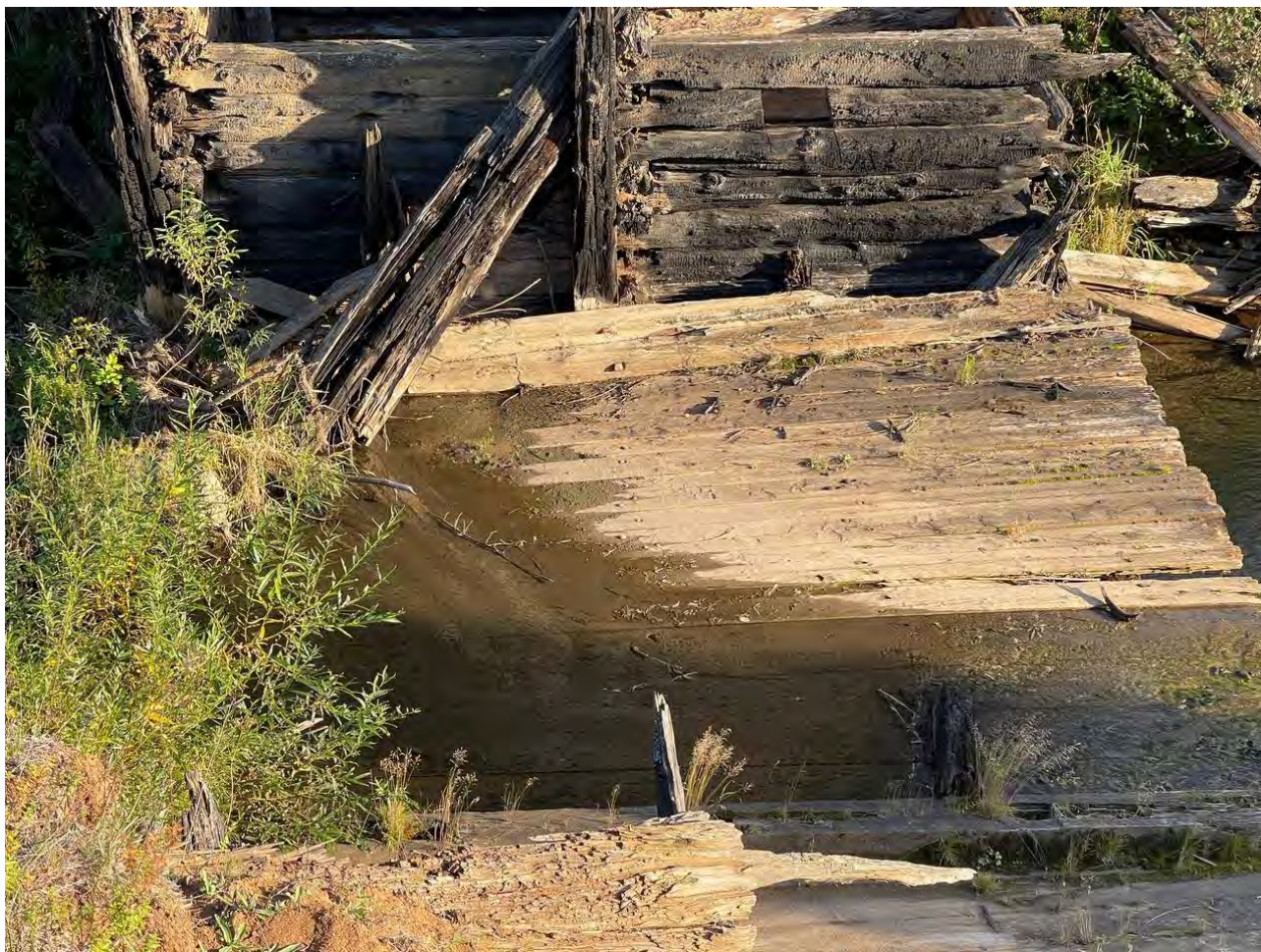
Фото.8. Вид на объект «Плотина», расположенный по адресу: Нязепетровский муниципальный район, д. Шемаха.
