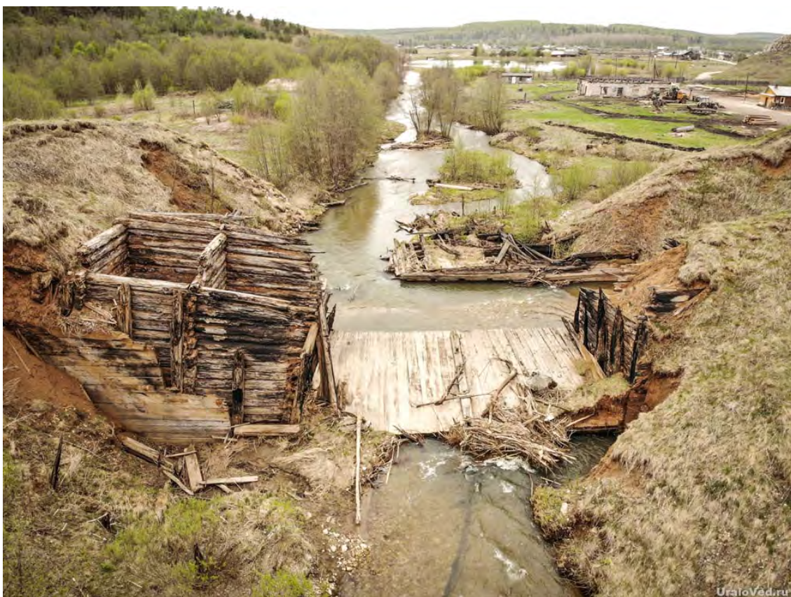
Рис.4. Фотография заводской плотины, 2018 г.
