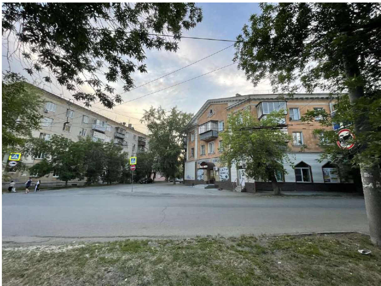
Фото 28. Градостроительная ситуация на территории исследования.
