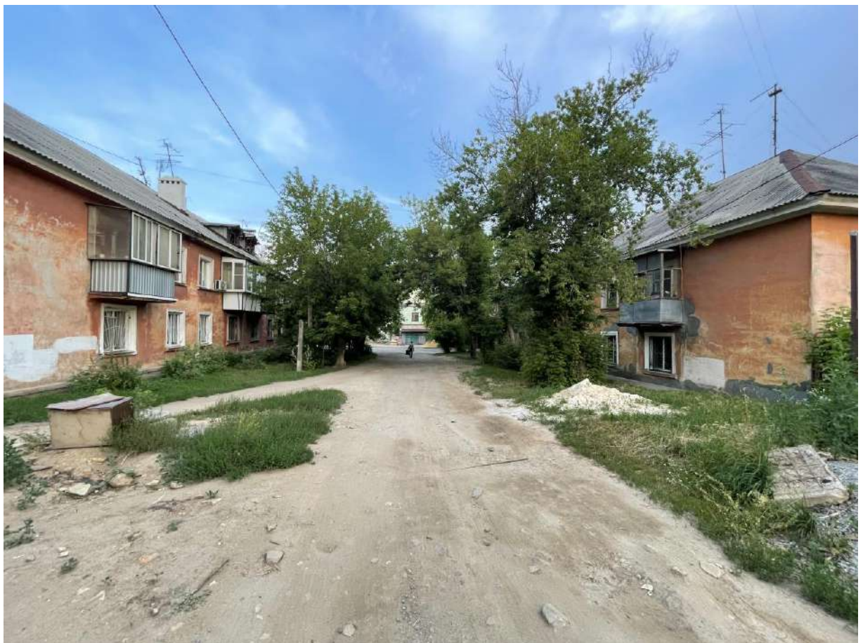
Фото 23. Градостроительная ситуация на территории исследования.
