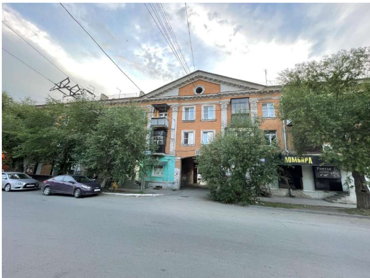
Фото 25. Градостроительная ситуация на территории исследования.
