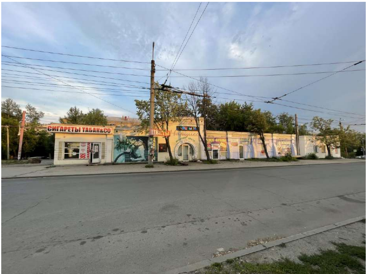
Фото 21. Градостроительная ситуация на территории исследования.
