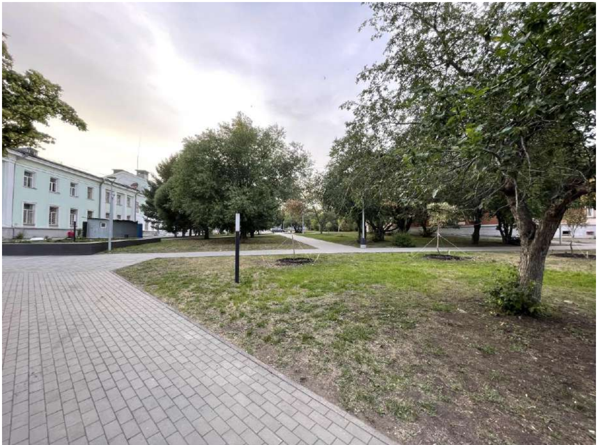
Фото 22. Градостроительная ситуация на территории исследования.
