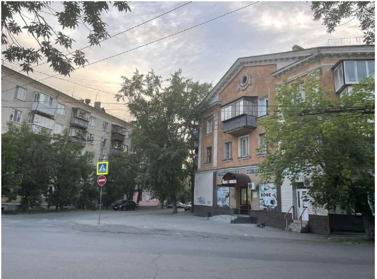
Фото 27. Градостроительная ситуация на территории исследования.
