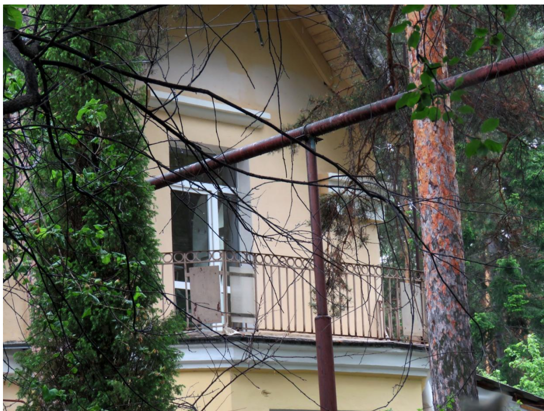
Рис. 6 а,б. Боковой, северо-западный фасад.
