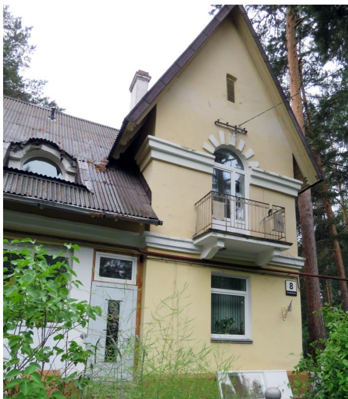
Рис. 5. Фрагмент главного фасада. Правая, северо-западная часть (кв. № 2)
