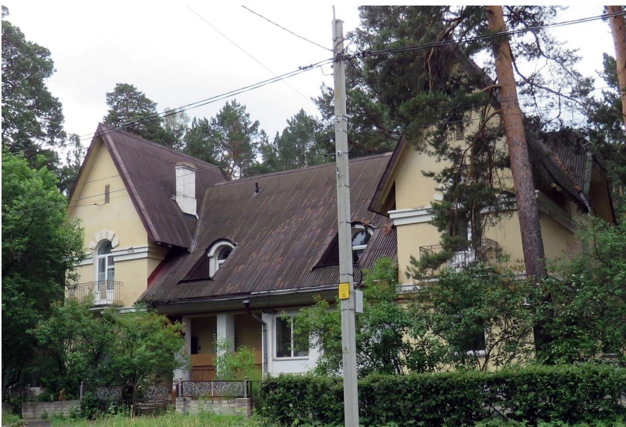
Рис. 2 а, б. Главный, северо-восточный фасад
