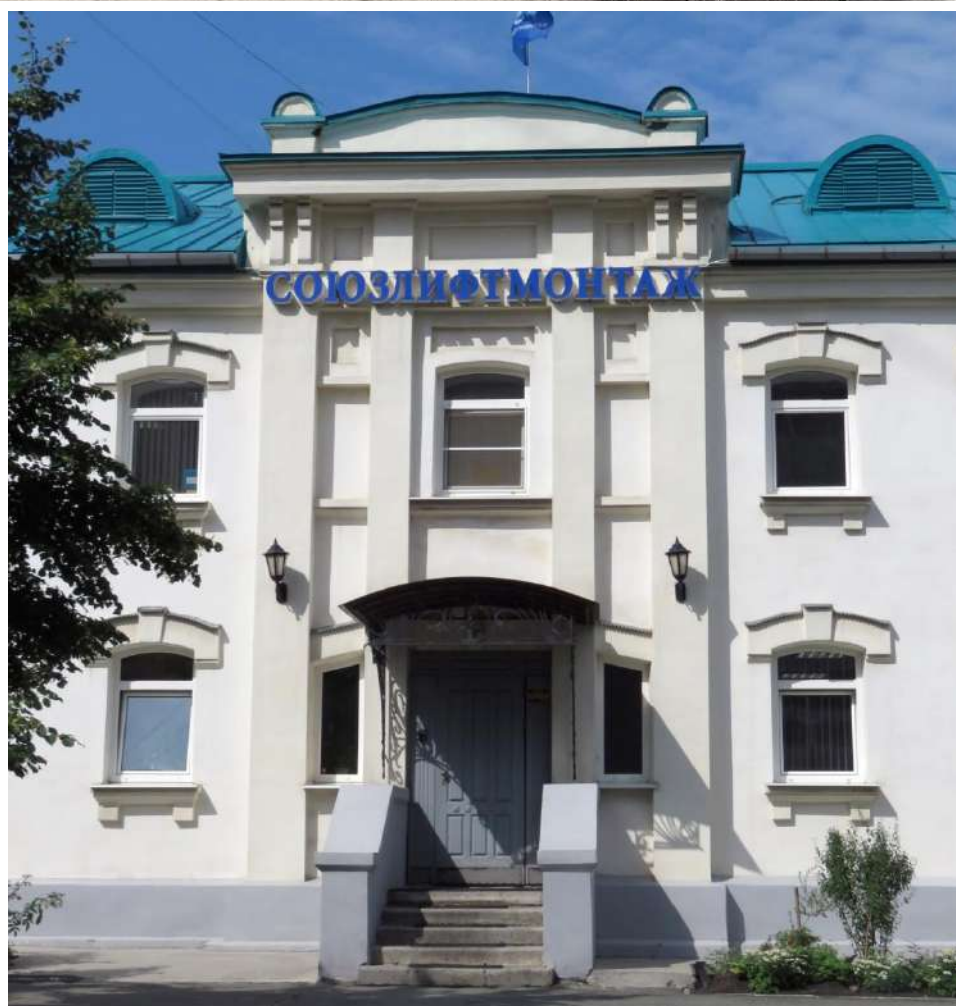
Рис. 6 а, б. Лицевой, восточный фасад (вверху). Фрагмент восточного фасада: средний ложный ризалит с современным главным входом в здание (исторический вход со стороны восточного фасада) (внизу)
