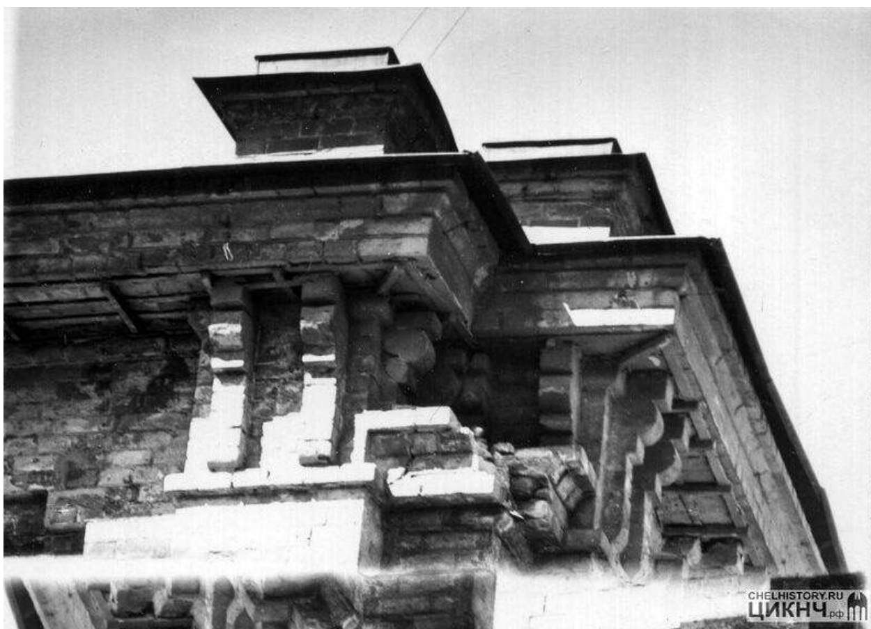
Рис. 36 а, б. Баня переселенческого пункта. Фрагменты фасадов (стык граней стен южного и восточного фасадов). Фото 1990-х гг. Источник: фонды ЦИКНЧ
