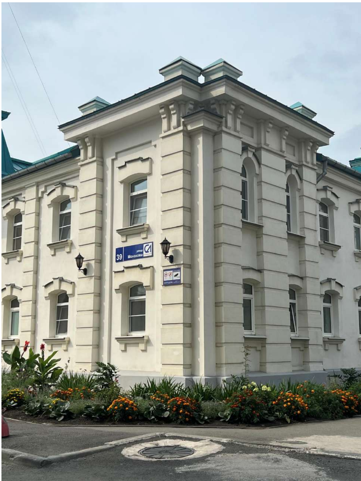
Рис. 9. Фланговые ризалиты южного и восточного фасадов. Вид с юго-востока
