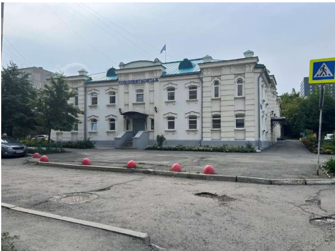
Рис. 1. Общий вид здания со стороны ул. Переселенческий пункт. Вид с востока. Лицевой, восточный фасад
