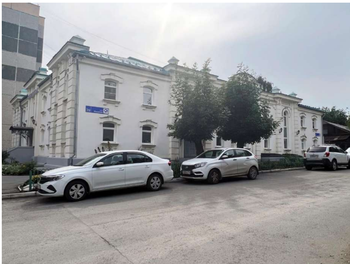
Рис. 10 а, б. Лицевой, северный фасад. Вид с северо-запада (вверху) и северо-востока (внизу)
