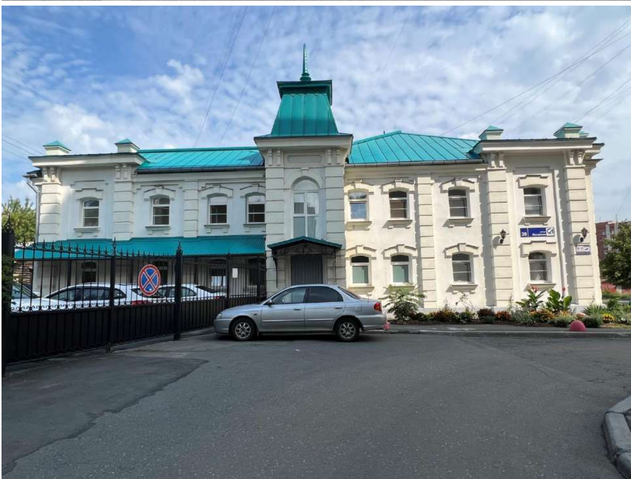
Рис. 7 а, б. Лицевой, южный фасад
