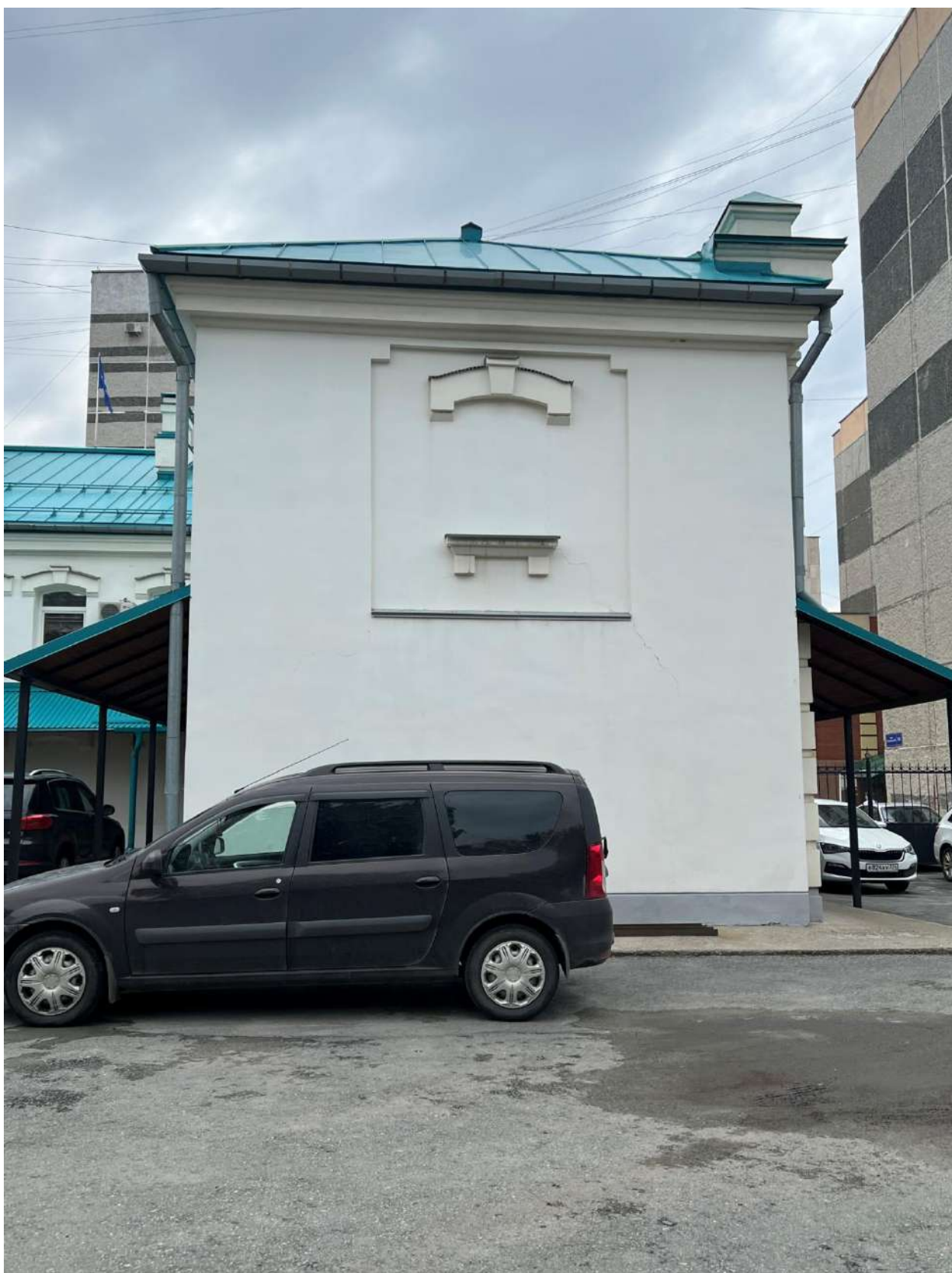
Рис. 14. Торцевой, западный фасад исторического здания
