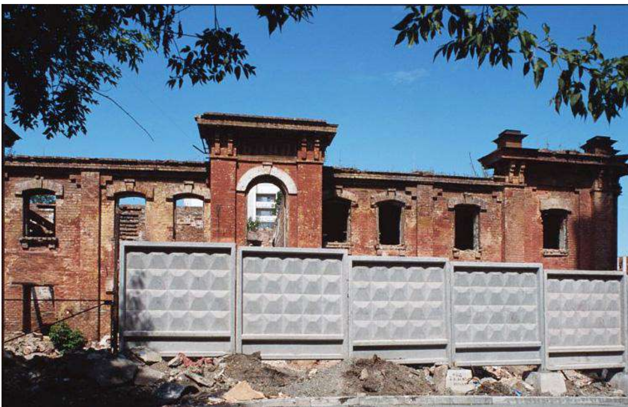
Рис. 38. Здание переселенческой бани. Южный фасад. Фото начала 2000-х гг.
