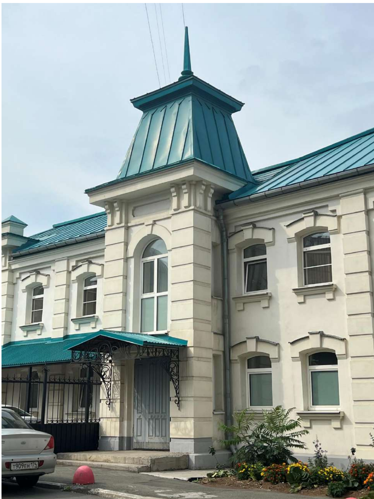
Рис. 8. Фрагмент южного фасада. Средний ризалит с шатровой кровлей. Исторический вход со стороны южного фасада
