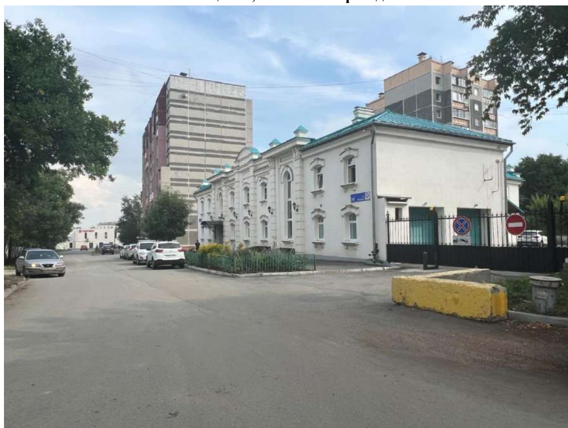
Рис. 2. Общий вид здания со стороны ул. Переселенческий пункт. Вид с северо-запада. Лицевой, северный фасад и торцевой, западный фасад
