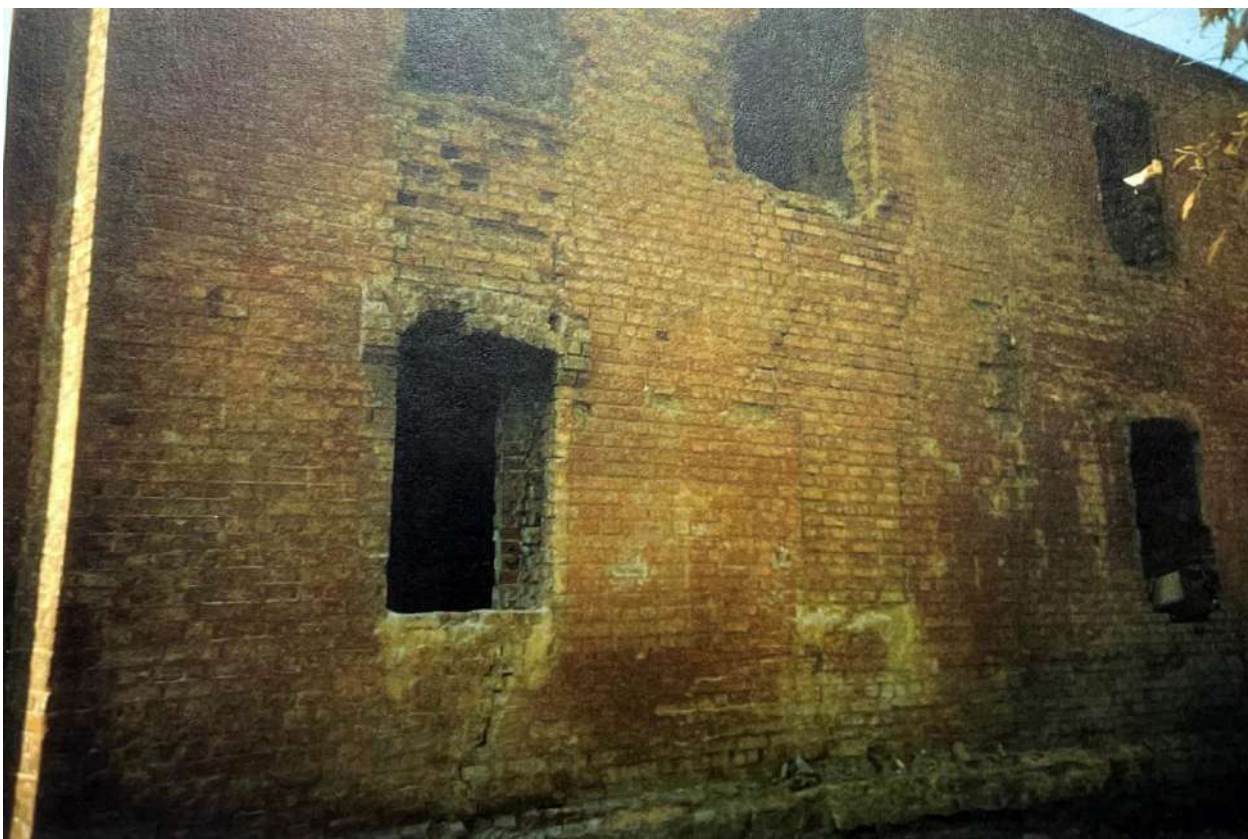
Рис. 39 д. Здание переселенческой бани. Северный фасад. Фото 2001 г. Источник: Отчет о научно-исследовательской работе «Обследование технического состояния здания бани № 16 по ул. Переселенческой, 27 в Челябинске». Челябинск: ЮУрГУ, 2001
