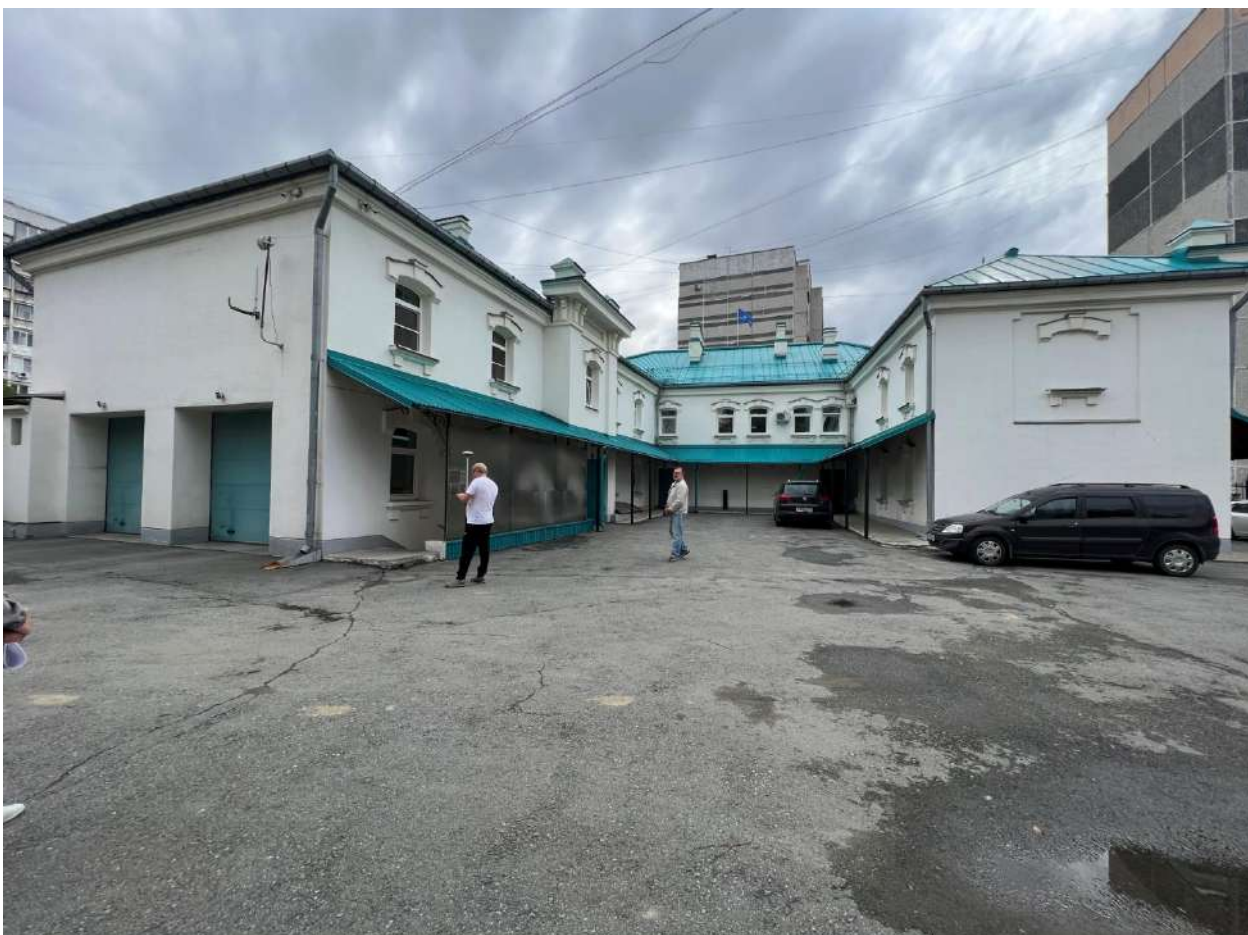
Рис. 12. Дворовые и торцевые фасады исторического (литера «А») и современного (литера «А3») объемов. Вид с запада
