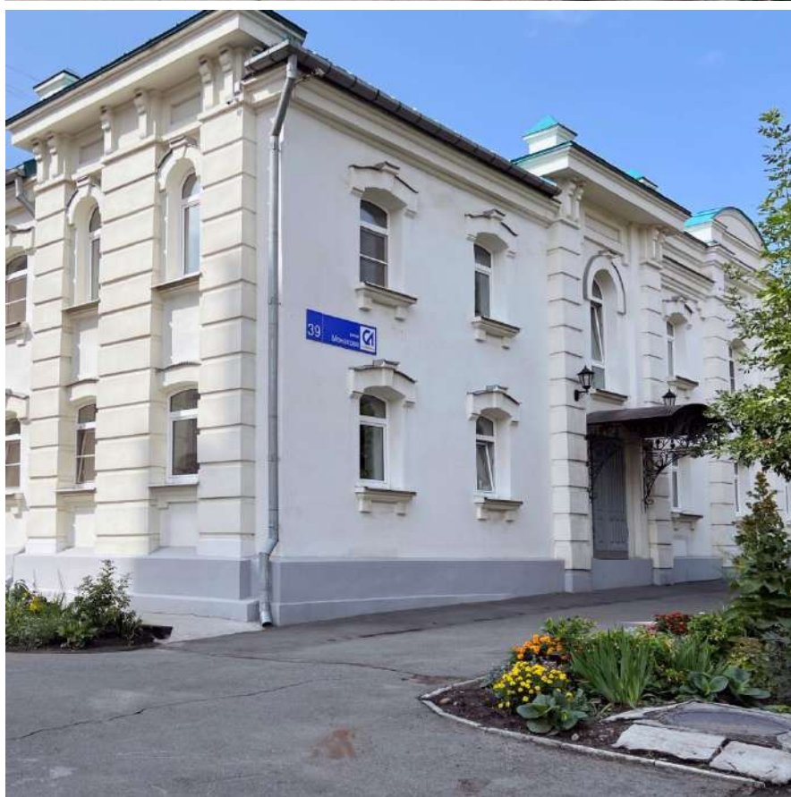
Рис. 11 а, б. Фрагменты северного фасада. Левый, восточный фланг с четырьмя оконными осями в границах северного фасада исторического объема.
