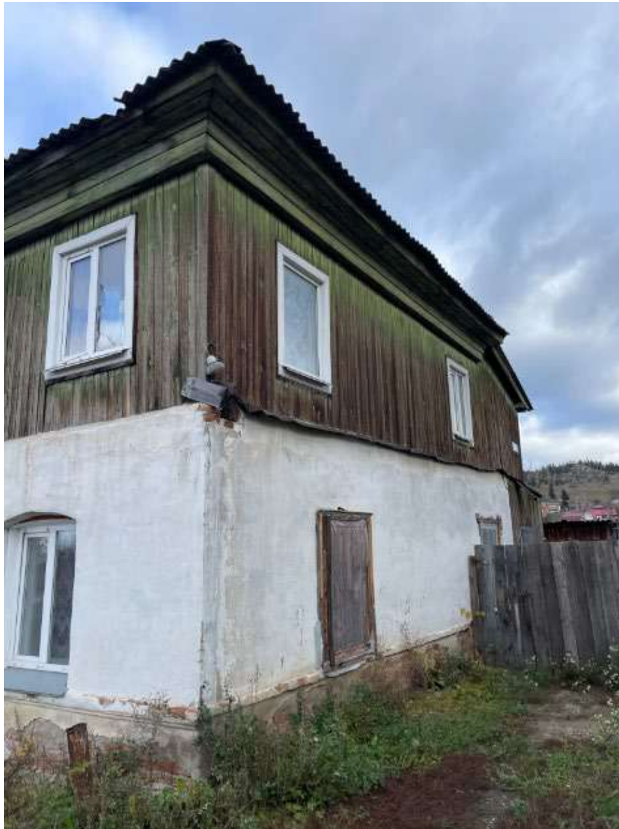
Фото 2. Выявленный объект культурного наследия «Женская школа» по адресу: Челябинская обл., г. Миасс, переулок Ремесленный, 4. Южный фасад выявленного объекта культурного наследия.
