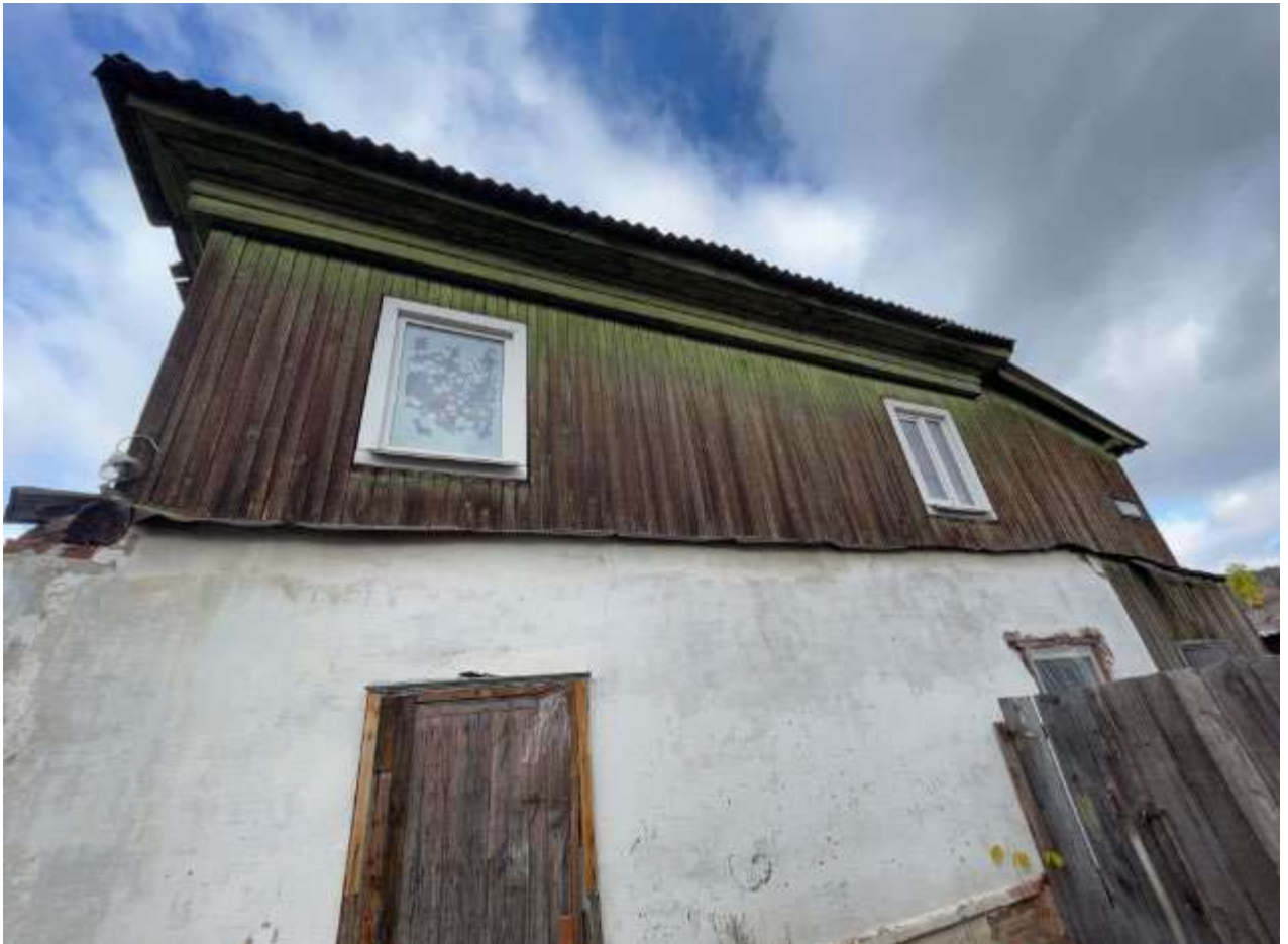
Фото 3. Выявленный объект культурного наследия «Женская школа» по адресу: Челябинская обл., г. Миасс, переулок Ремесленный, 4. Южный фасад выявленного объекта культурного наследия.
