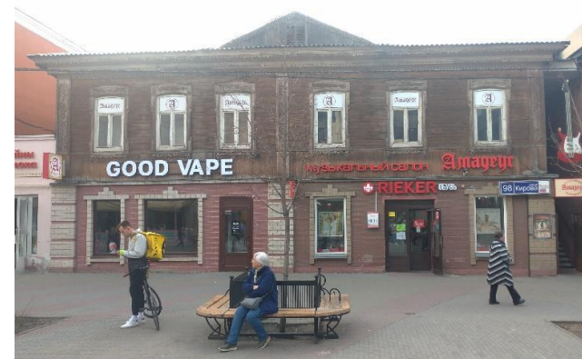
Восточный фасад здания
