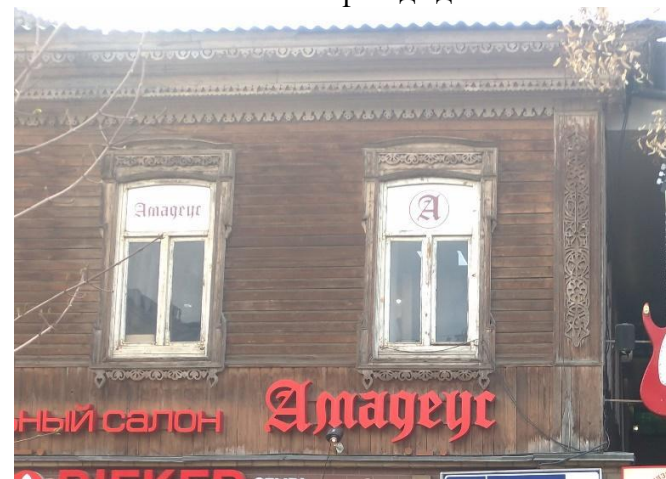
Фрагмент восточного фасада здания
