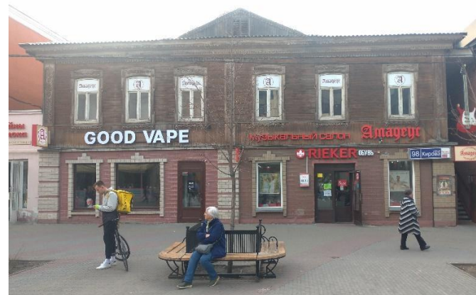
Восточный фасад здания
