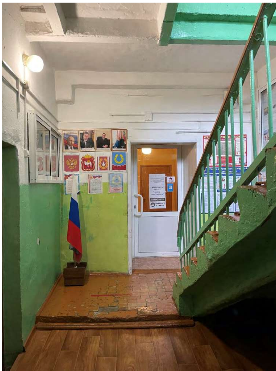
Фото.19. Выявленный объект культурного наследия «Здание, в котором в декабре 1917 г. - июне 1918 г. размещались штаб Красной гвардии и Ревком», расположенный по адресу: Катав-Ивановский муниципальный район, г. Юрюзань, ул. Советская, 14.
