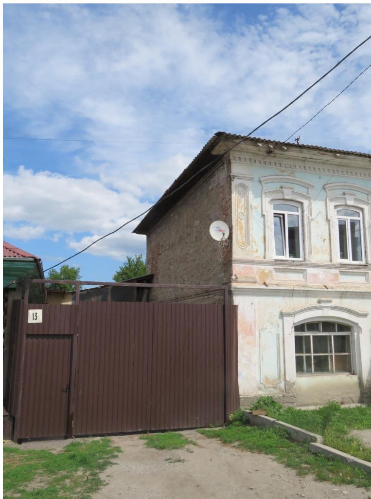
Рис. 11. Боковой, западный фасад, вид с юго-запада
