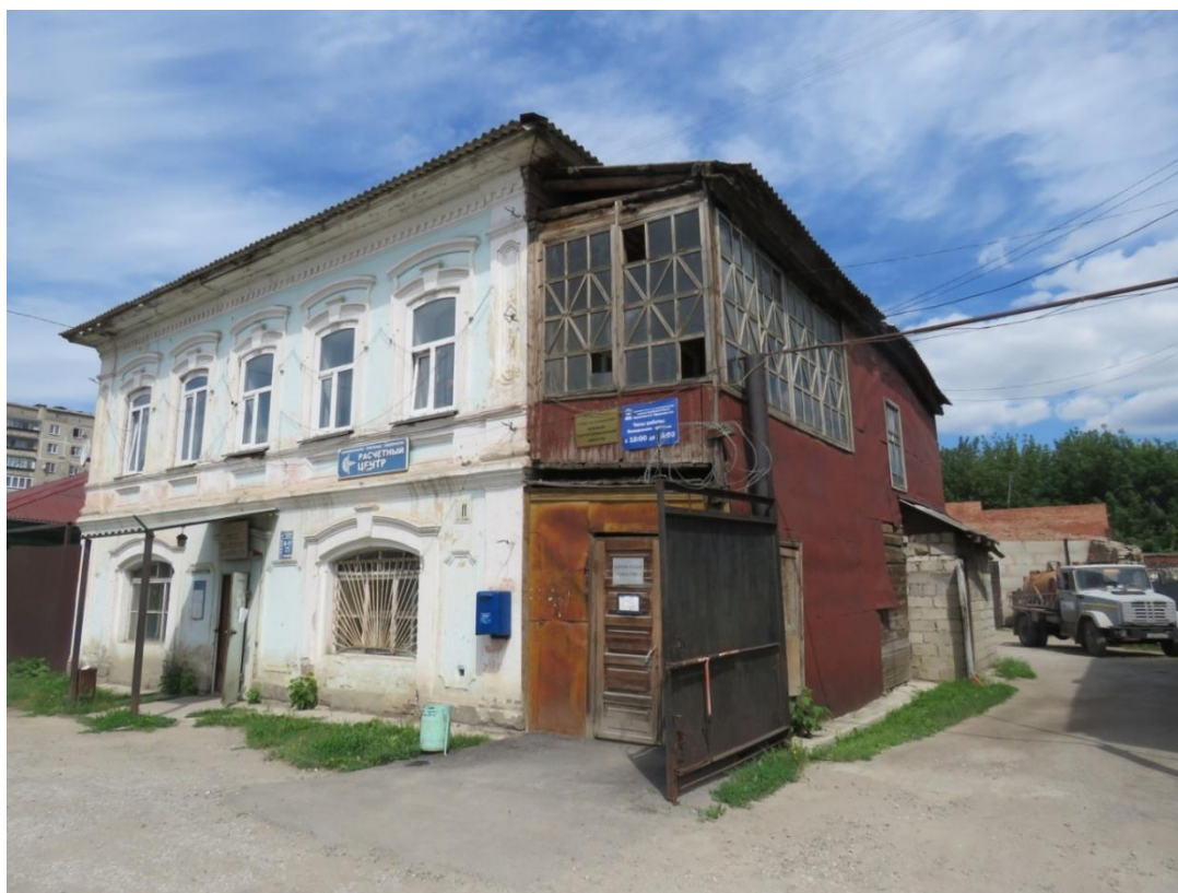
Рис. 8. Примыкающий деревянный пристрой, примыкающий к восточному фасаду каменного дома. Вид с юго-востока.
