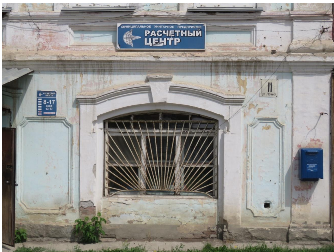
Рис. 6. Фрагмент главного фасада. Окно и декор первого этажа.
