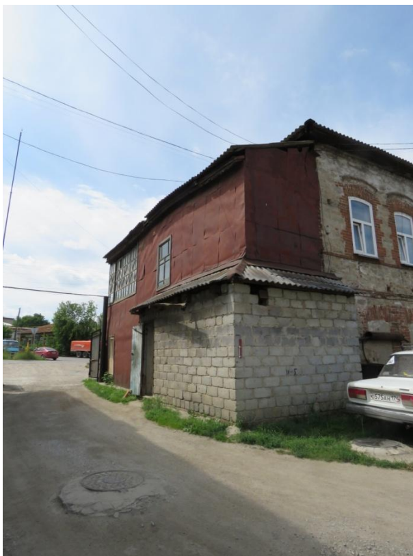
Рис. 9. Деревянный пристрой и пристрой из силикатного кирпича, примыкающие к восточному фасаду каменного дома, вид с северо-востока.
