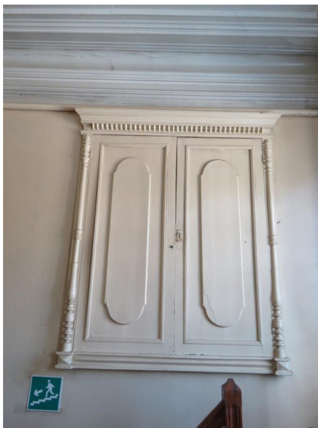
Рис. 33. Фрагмент интерьеров второго этажа. Холодильный шкаф в лестничном зале.
