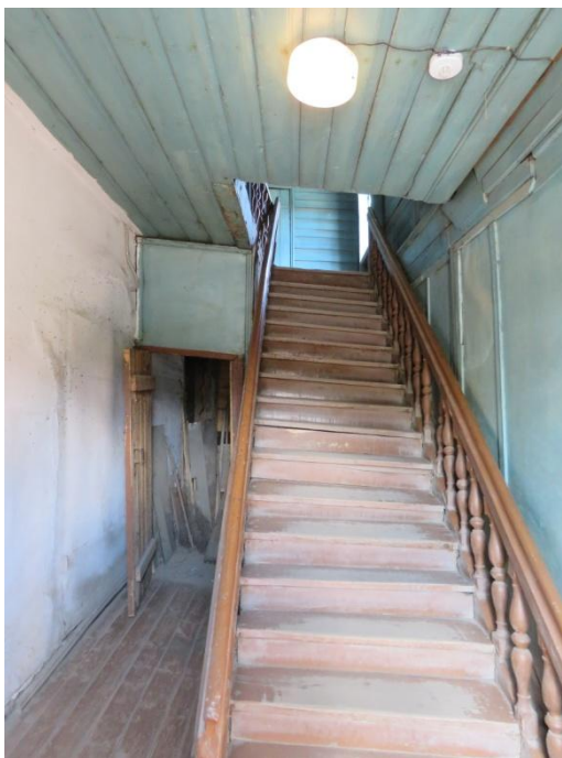
Ил. 38. Лестничный пристрой.
