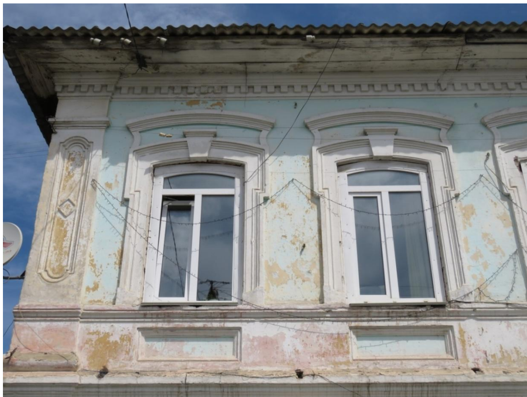
Рис. 7. Фрагмент главного фасада. Окна и декор второго этажа.
