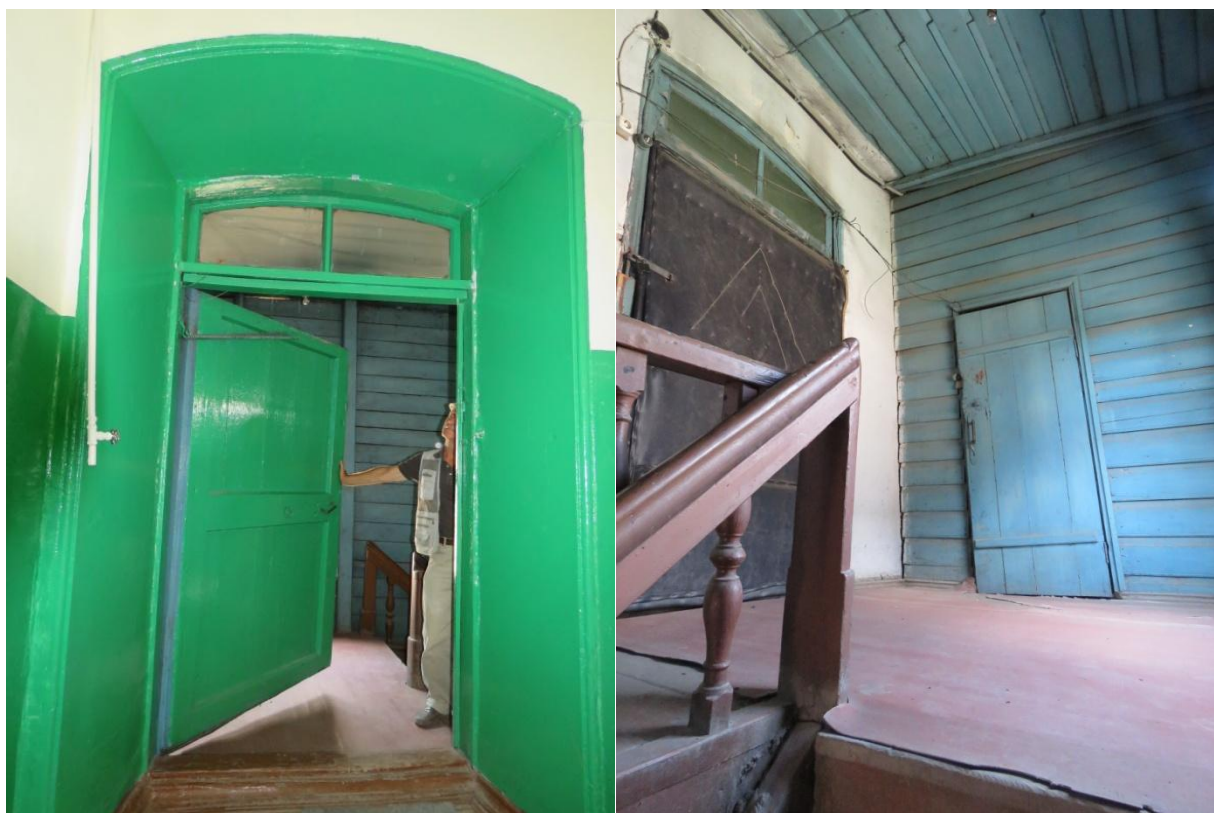
Рис. 39, 40. Исторические входные проемы второго этажа из лестничного пристроя
