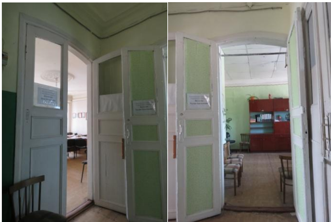
Рис. 43, 44. Дверные проемы в помещения второго этажа.
