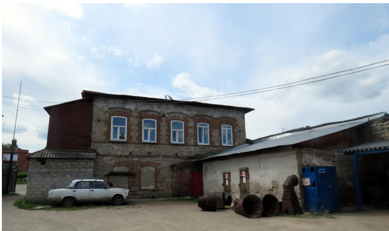
Рис. 12. Дворовый, северный, фасад, с примыкающим зданием каменного сарая (литера Б).
