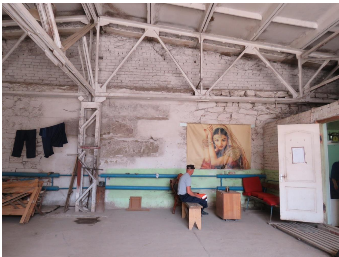
Рис. 15, 16. Фрагменты брандмауэрной стены, включенные в стены цеха, расположенного на территории усадьбы (литера В), западная и северная стена.
