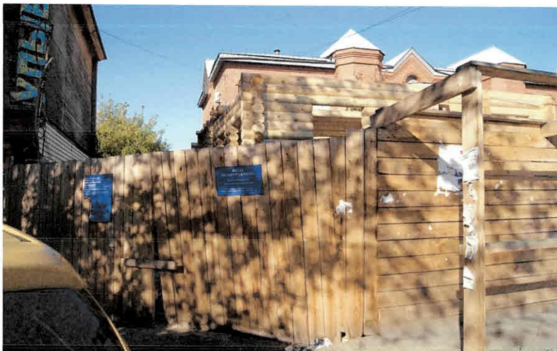
Фото 7. Вид на главный фасад строящегося объекта с юго-востока
