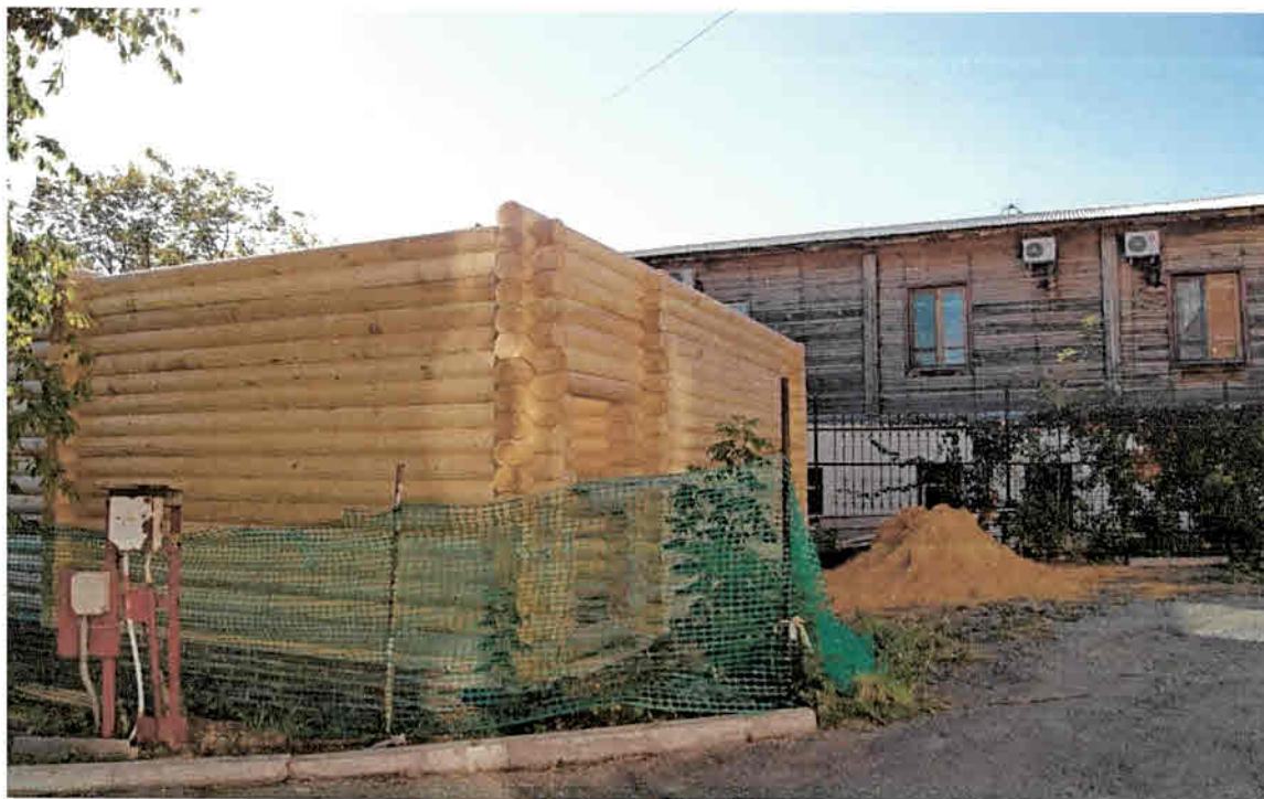
Фото 5. Вид на строящийся объект с северо-западной стороны
