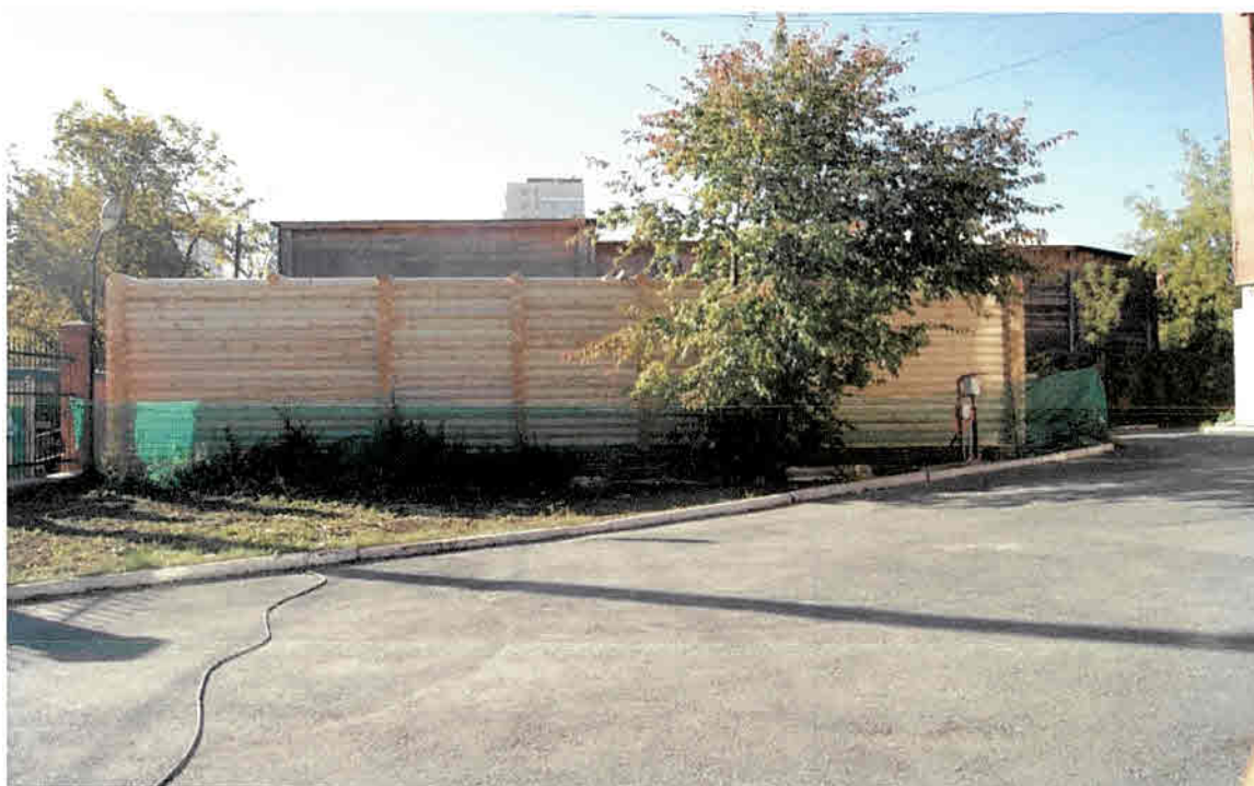
Фото 6. Вид на северный фасад строящегося объекта
