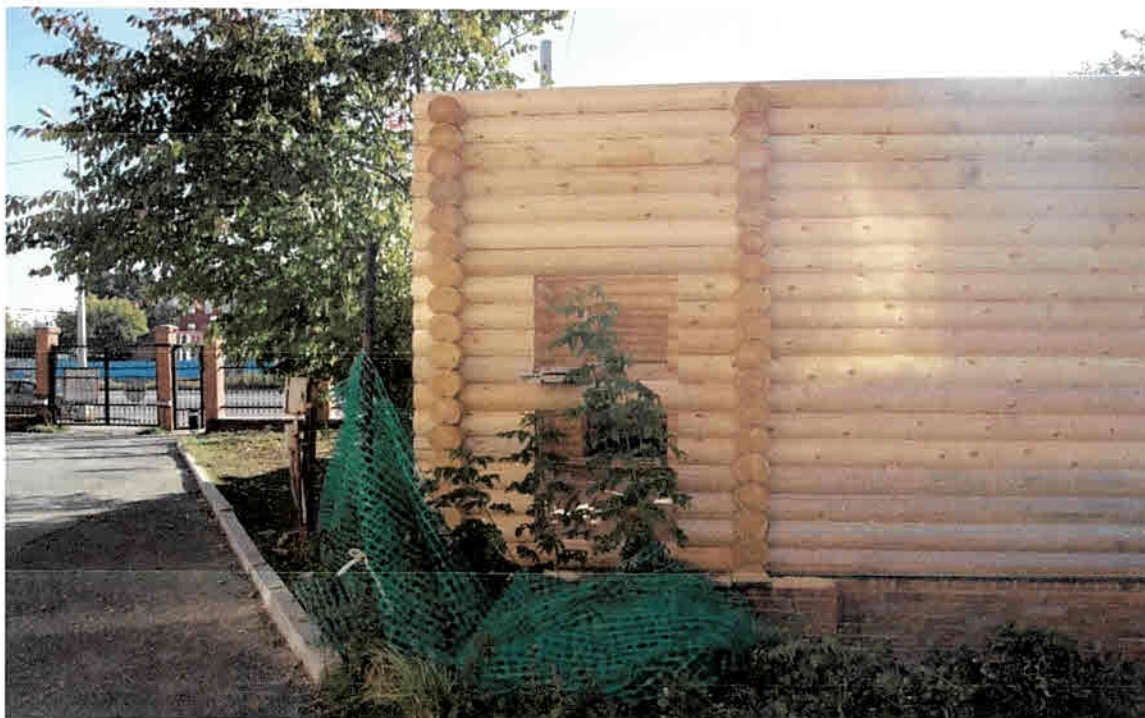
Фото 4. Фрагмент фасада строящегося объекта с западной стороны
