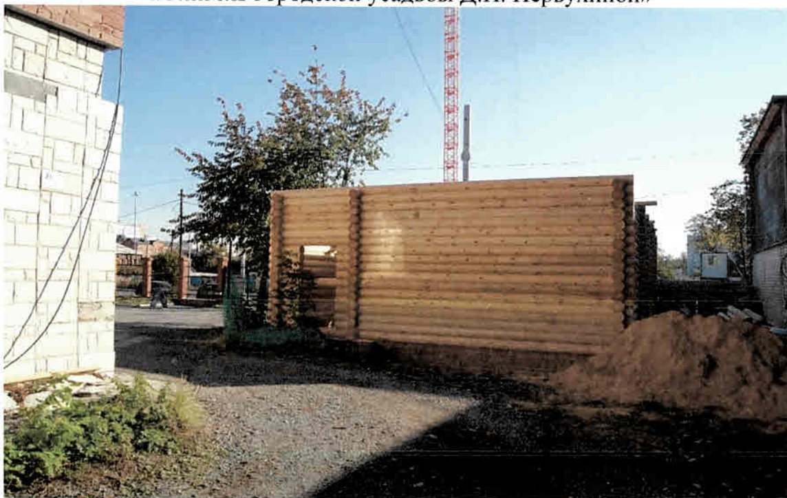
Фото 1. Вид на строящийся объект с западной стороны
