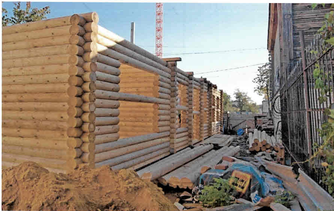
Фото 3. Вид на строящийся объект с юго-западной стороны
