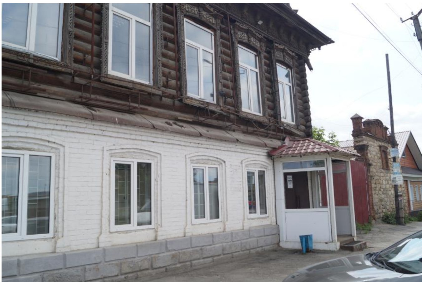
Фото 3. Вид на выявленный объект культурного наследия «Дом торговцев Юркиных», расположенный по адресу: Челябинская область, Миасский городской округ, г. Миасс, ул. Пушкина, 26.
