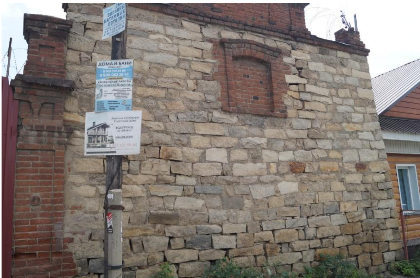
Фото 6. Вид на выявленный объект культурного наследия «Дом торговцев Юркиных», расположенный по адресу: Челябинская область, Миасский городской округ, г. Миасс, ул. Пушкина, 26.
