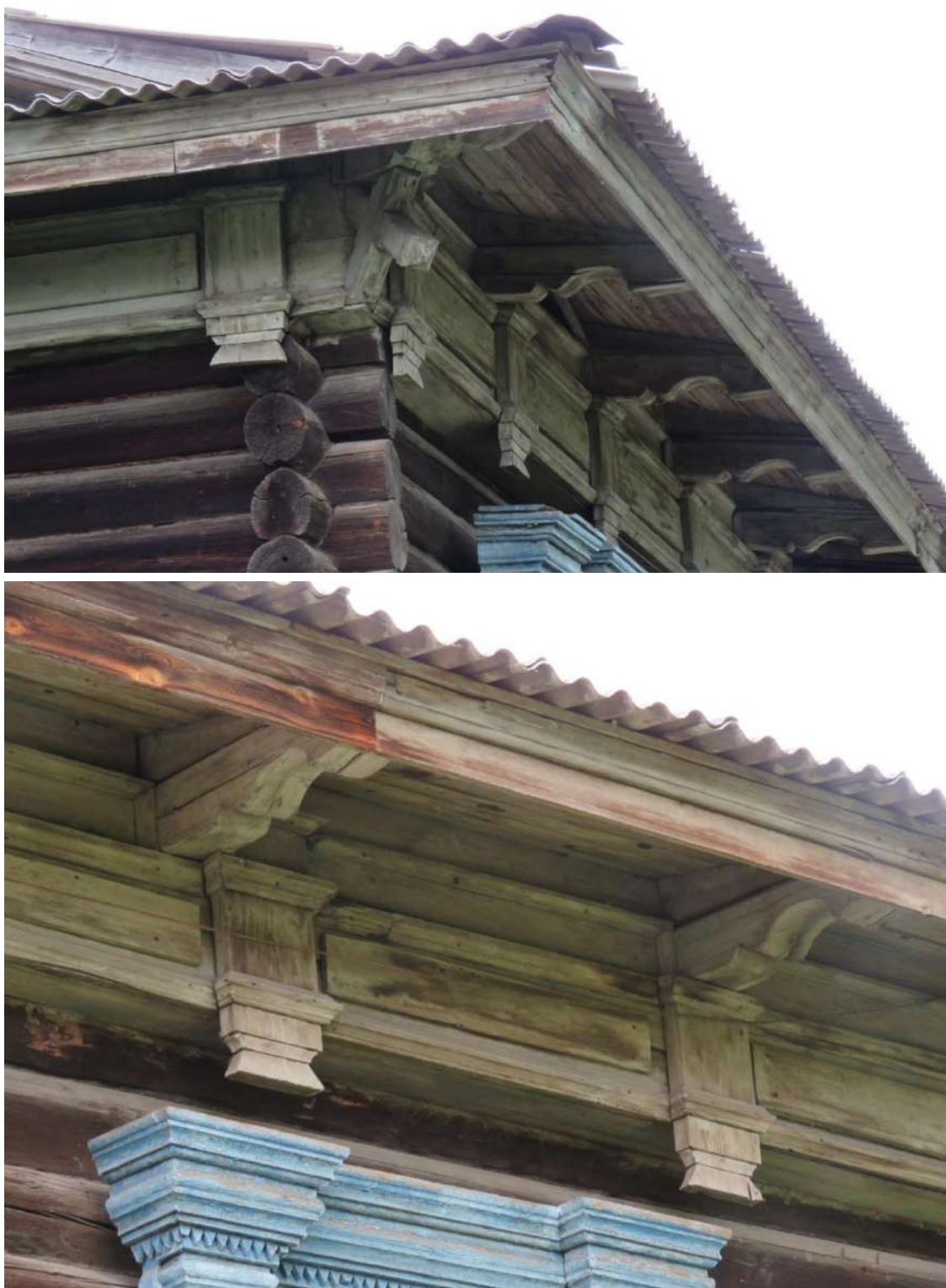
Рис. 12 а, б. Решение фриза и карниза
