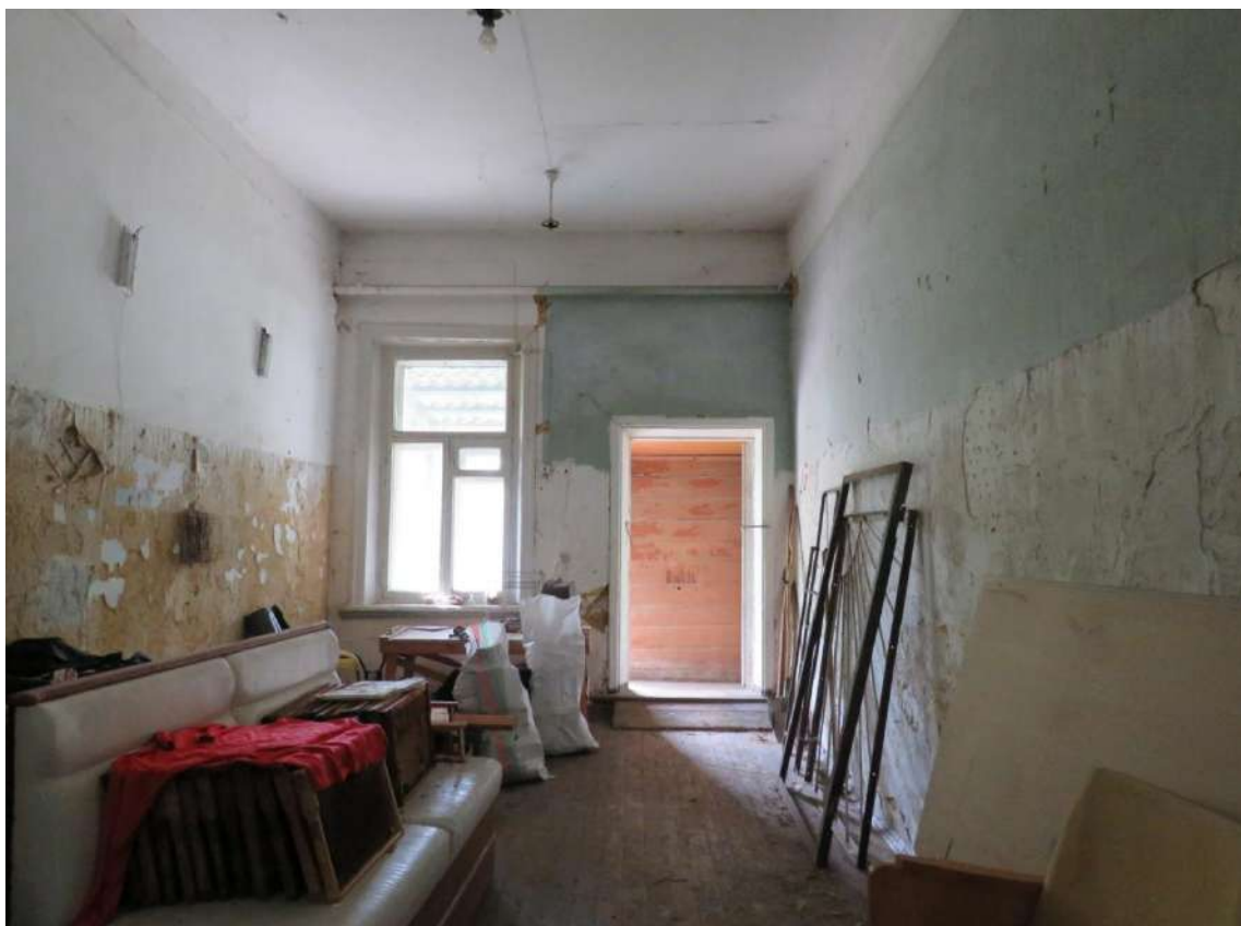
Рис. 14. Фрагменты интерьера. Помещение у входа через дощатый тамбур со стороны южного фасада
