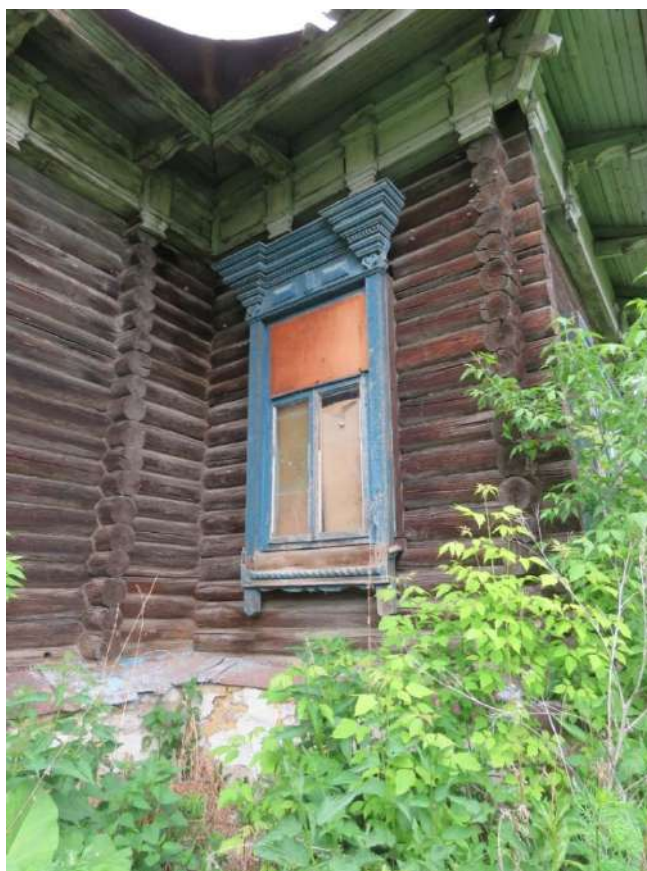
Рис. 4. Восточная стена бревенчатого тамбура, Вид с юго-востока
