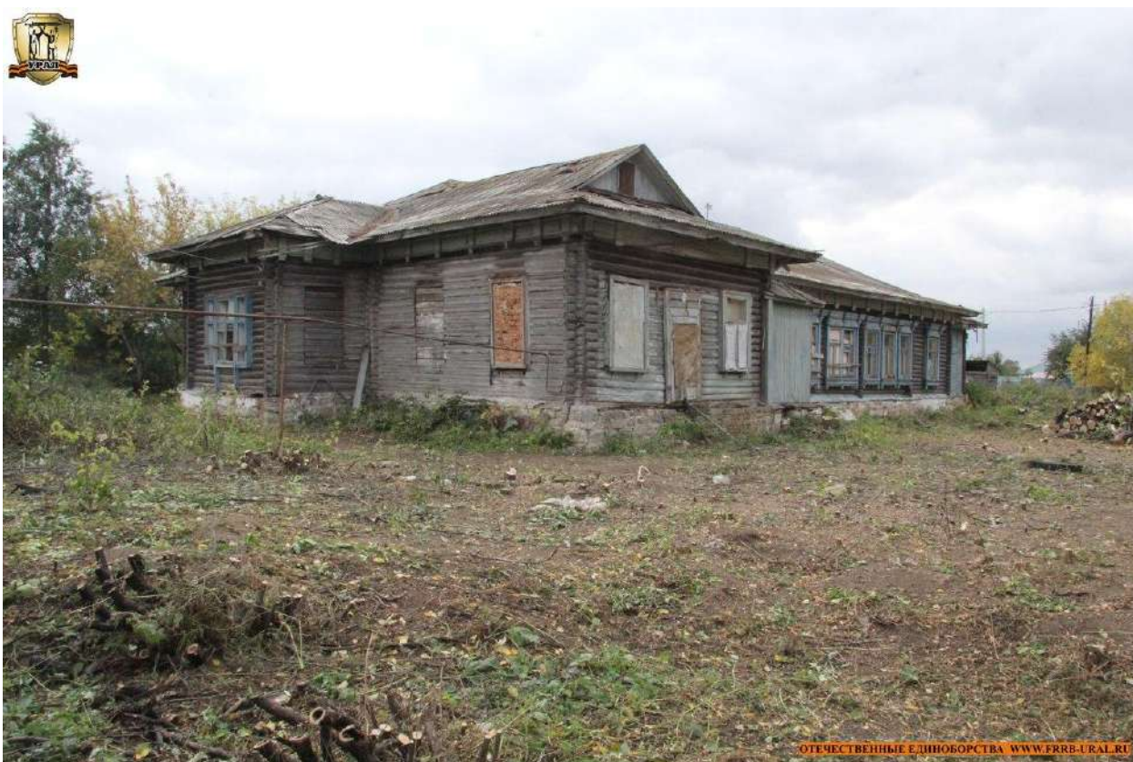
Рис. 18 а, б. Здание школы в 2017 г. Фото ОД «Казачий дозор»
