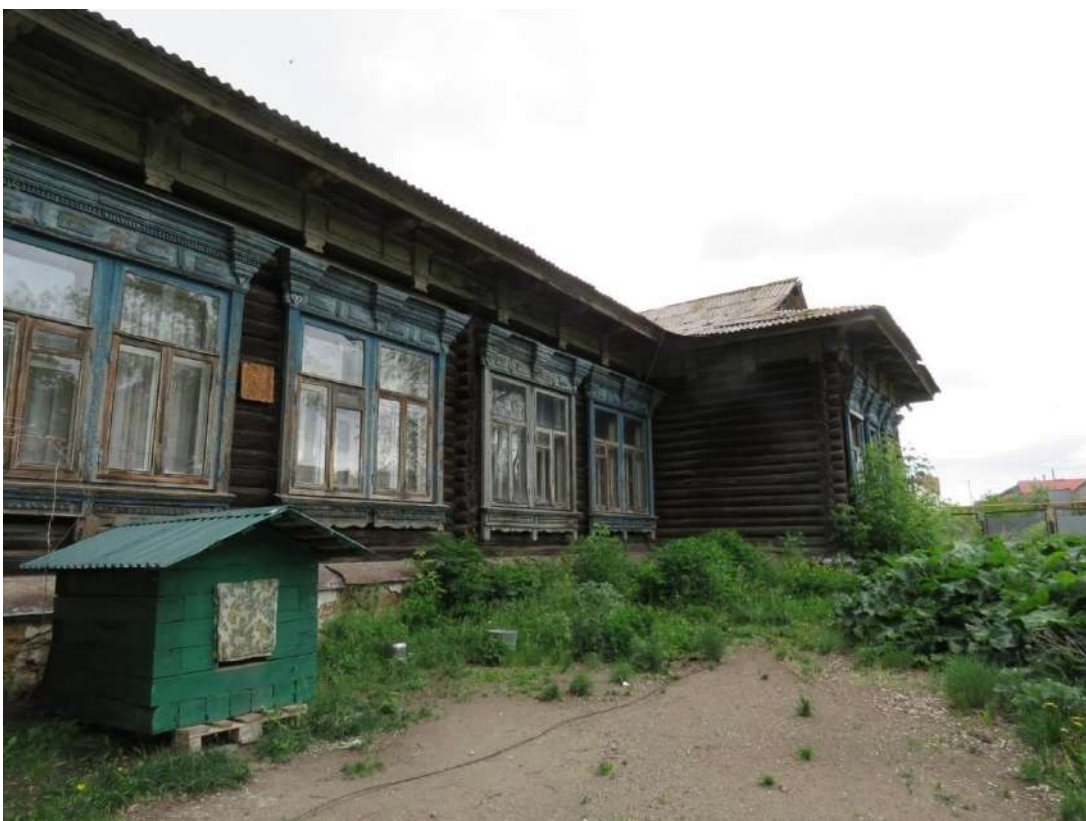
Рис. 1 а, б. Фрагменты южного фасада. Вид с юго-запада
