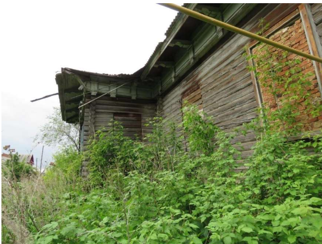
Рис. 6. Восточный поперечный корпус с объемом бревенчатого тамбура. Вид с северо-востока
