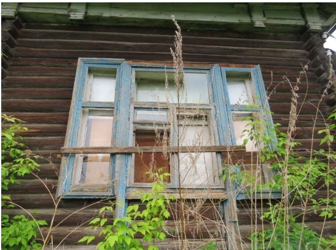
Рис. 5. Оконный проем на месте дверного в восточном входном бревенчатом тамбуре. Вид с востока
