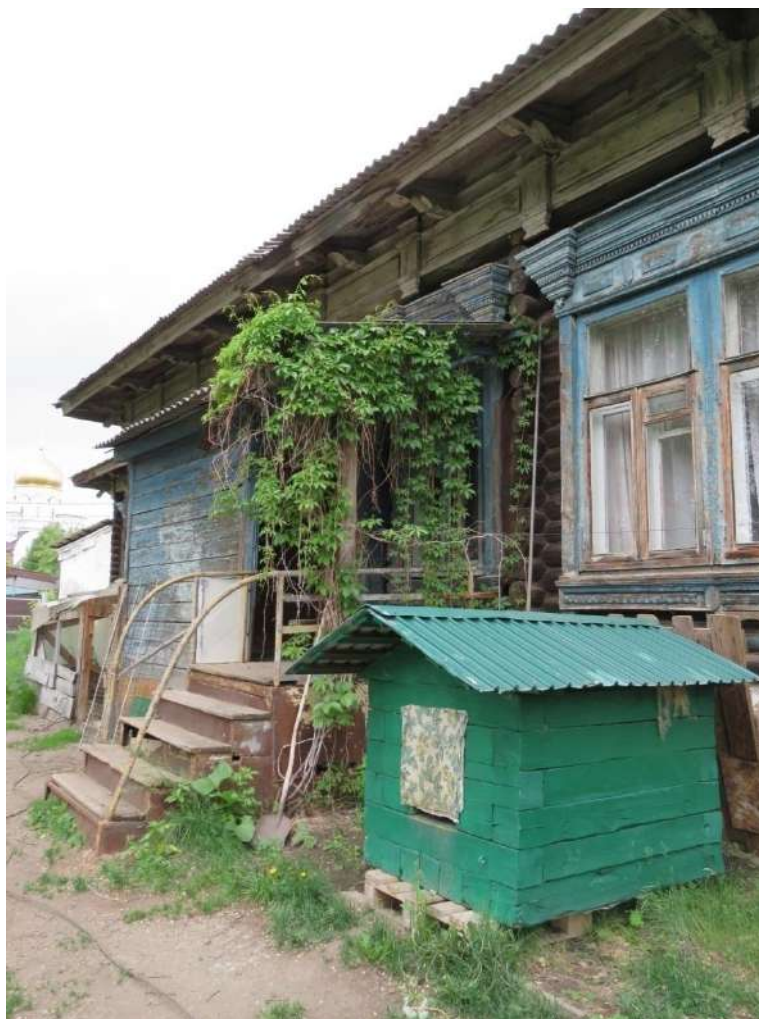
Рис. 2 а, б. Фрагменты южного фасада. Вход с крыльцом и дощатым пристроем
