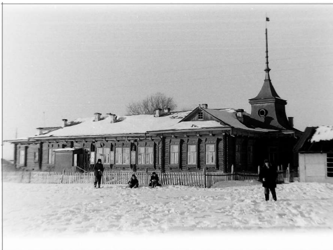
Рис. 17 а, б. Здание школы в 1960-е гг. Источник: музей филиала МОУ СОШ № 147 Центрального района г. Челябинска в Сосновке
