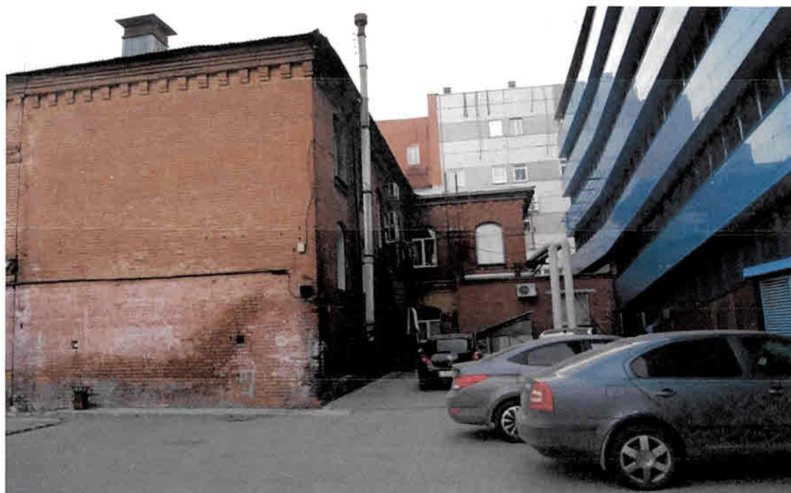
Фото 6. Фрагмент западного фасада здания
