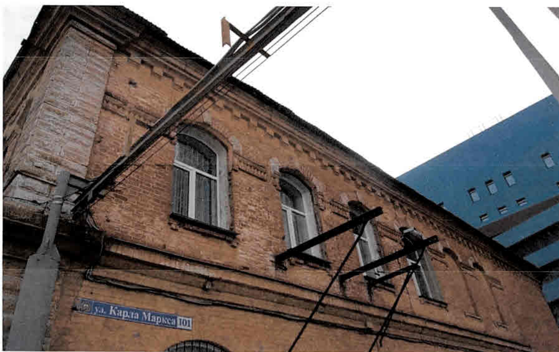
Фото 4. Фрагмент западного фасада. Вид на окна второго этажа
