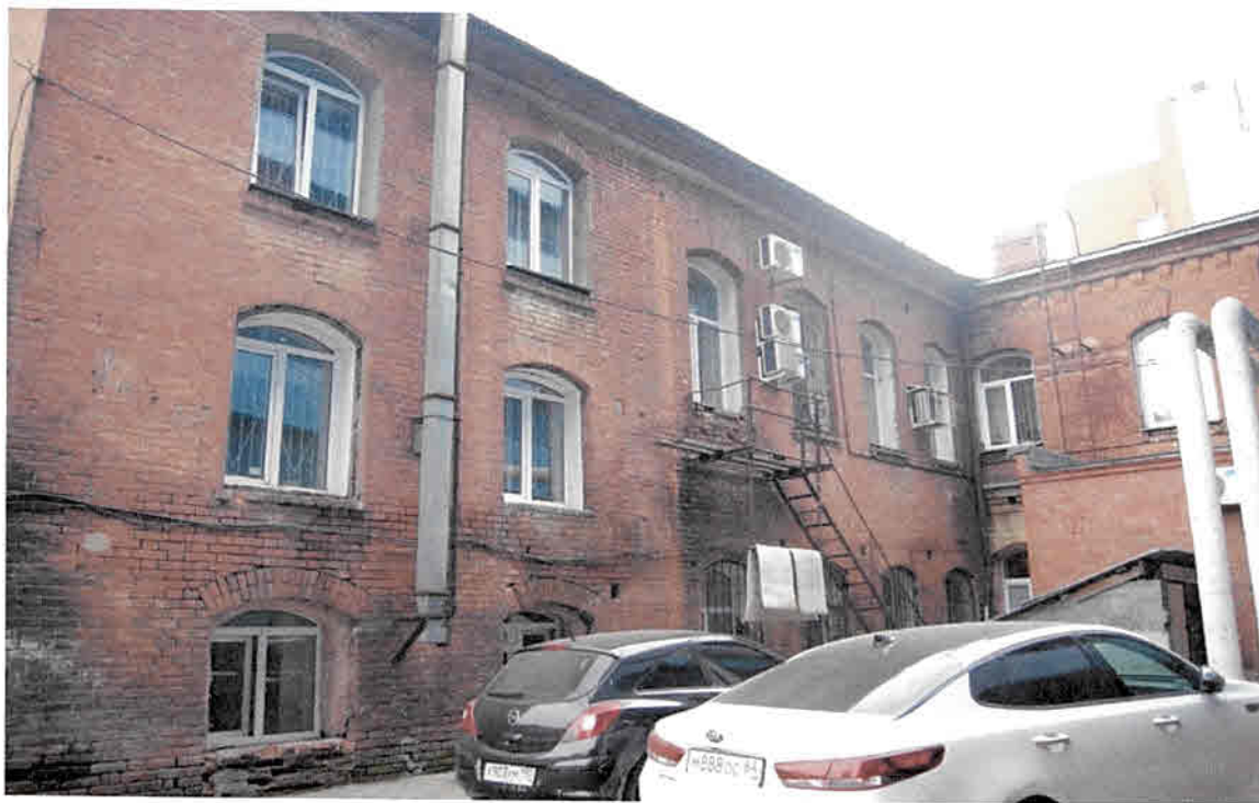
Фото 7. Вид на южный фасад здания с юго-запада
