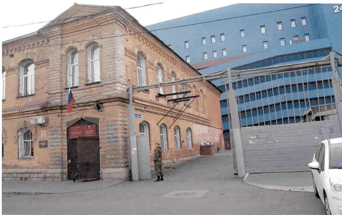
Фото 3. Вид на западный фасад с северо-западной стороны
