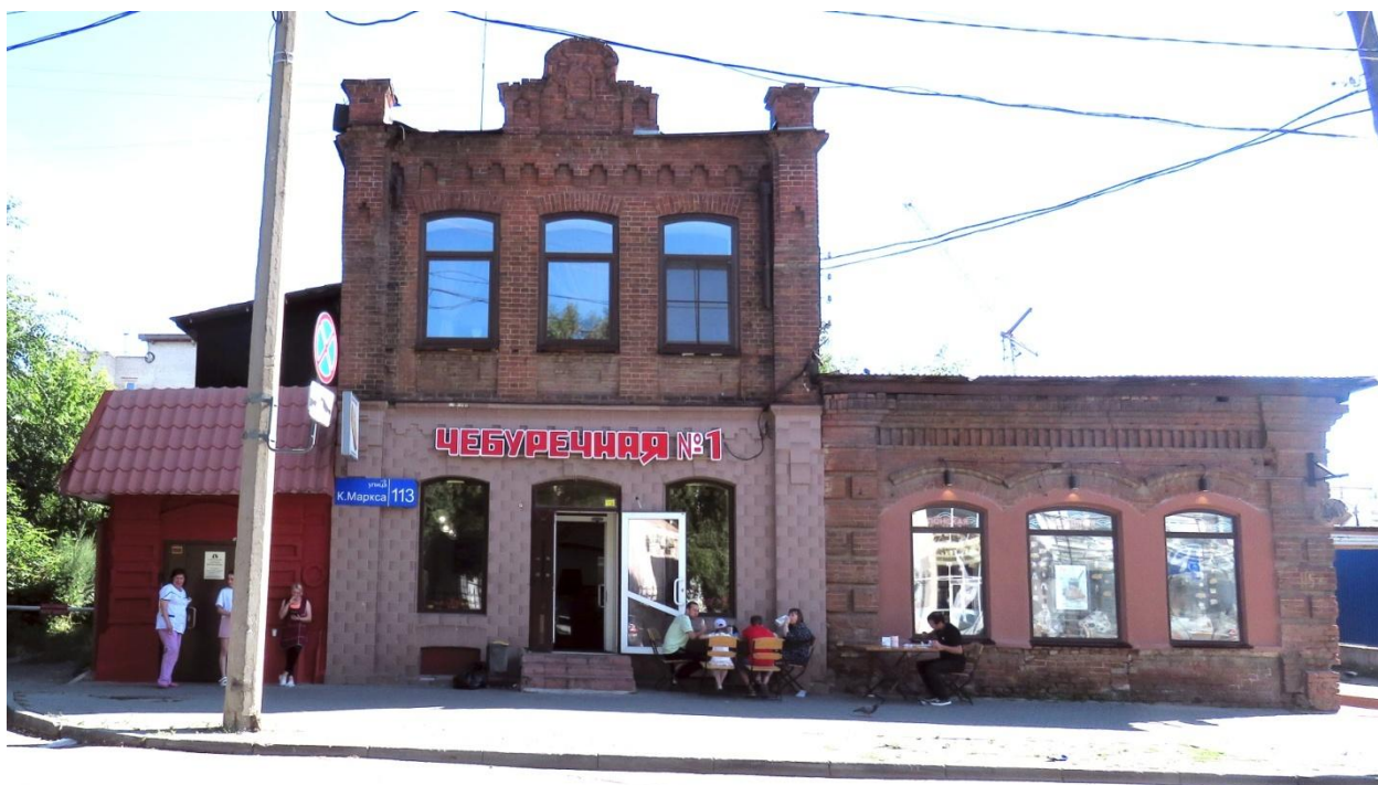
Рис. 1. Главный северный фасад выявленного ОКН, и примыкающего к нему с востока здания двухэтажного каменного магазина купца Е.Г. Назарова
