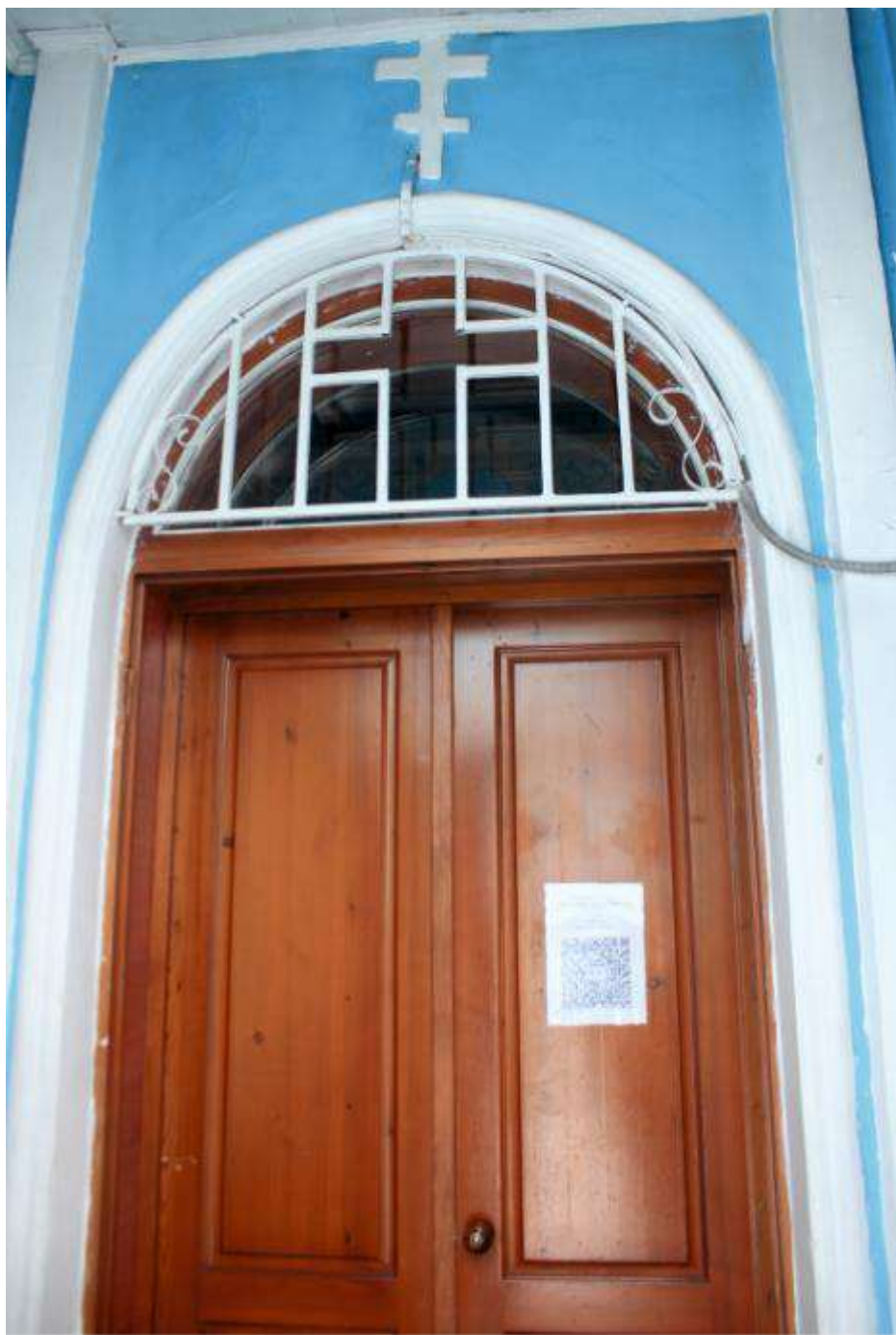
Фото 55. Выявленный объект культурного наследия «Храм Михаила Архангела», расположенный по адресу: г. Магнитогорск, ул. Коммунаров, 30. Интерьер выявленного объекта культурного наследия.
