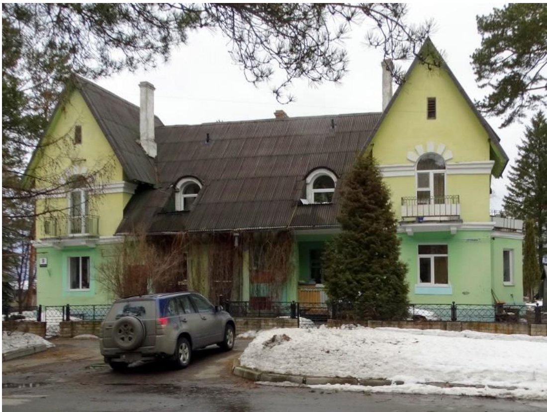
Рис. 21. Коттедж по ул. Гречишникова, 9. Главный, южный фасад. Фото Ю.В. Латышева, 2020. Источник: https://arhistrzh.livejournal.com/295436.html
