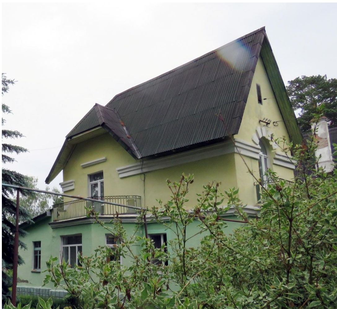
Рис. 6. Боковой, западный фасад
