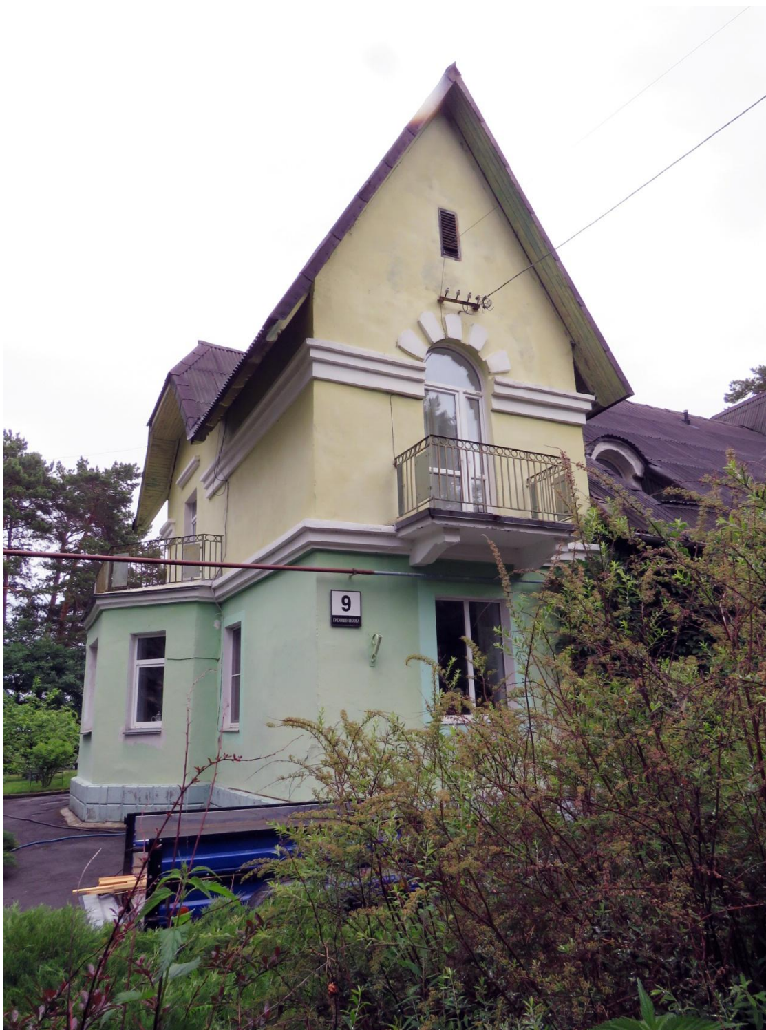
Рис. 5. Левый, западный фланговый объем со стороны лицевого (южного) и бокового (западного) фасадов
