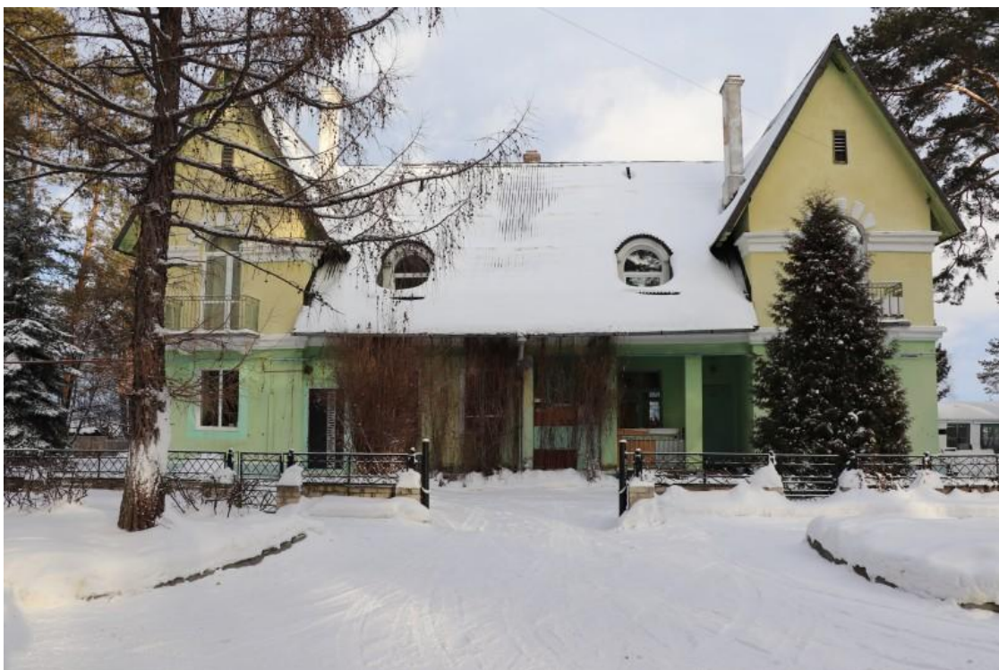
Рис. 22. Коттедж по ул. Гречишникова, 9. Главный, южный фасад. Фото: Государственный комитет охраны объектов культурного наследия Челябинской области, 2020. Источник: https://arhistrzh.livejournal.com/295436.html
