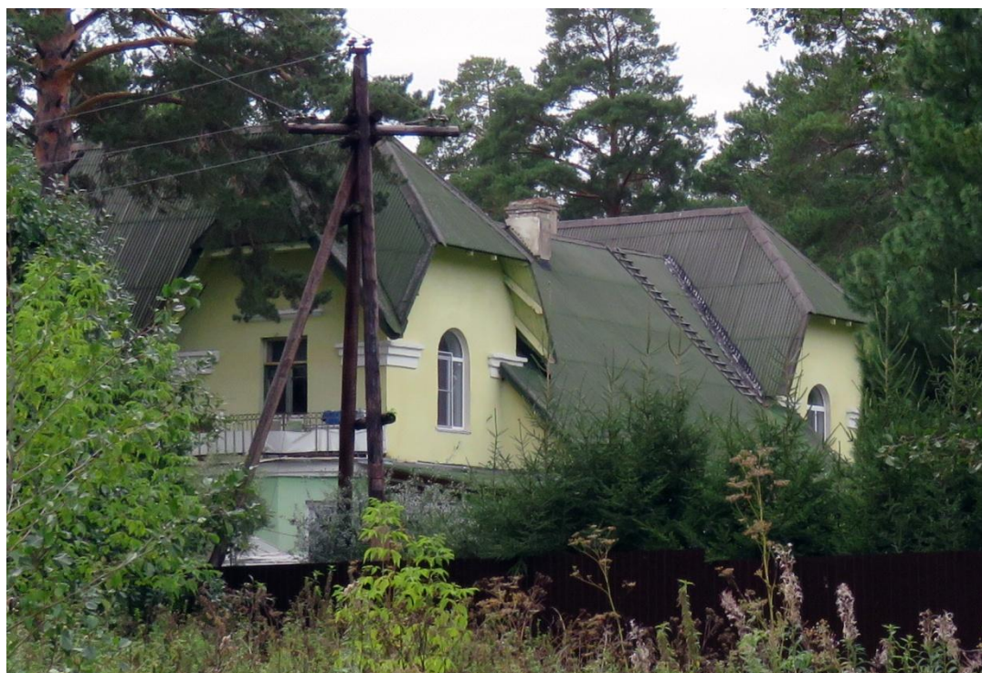
Рис. 7. Дворовый, северный фасад
