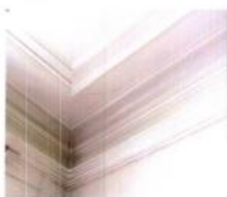
Фото 42. Декоративные элементы потолка: профилированные тяги из архитектурных обломов
