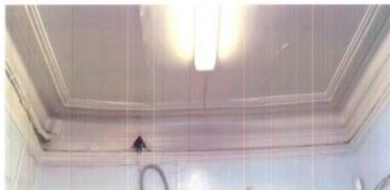
Фото №52. Декоративные элементы потолка: профилированные тяги из архитектурных обломов
