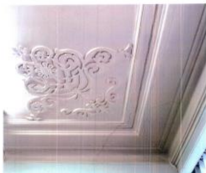
Фото №37. Декоративные элементы потолка: профилированные тяги из архитектурных обломов, орнаментальная порезка растительного рисунка
