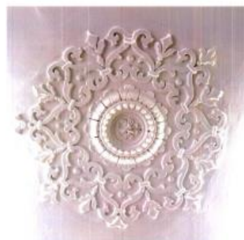
Фото №40. Фрагментарная утрата деталей орнаментальной композиции розетки
