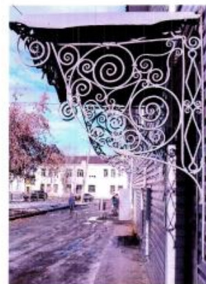
Фото №7. Козырек главного входа в здание. Металлический каркас с заполнением ажурным рисунком ручной кузнечной ковкой из металлического прута квадратного сечения
