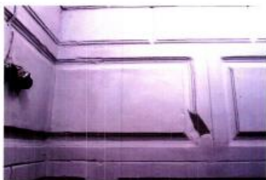
Фото №11. Штукатурная отделка стен помещения, с разделкой рустов представляющая собой имитацию каменной различной формы, которые отделены друг от друга швами-рустами, профилированными из архитектурных облозов
