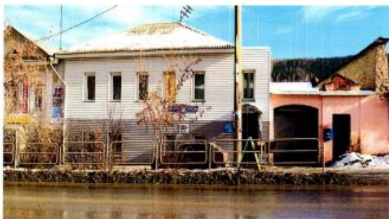
Фото №1. Вид на главный фасад здания с точки съемки №1
