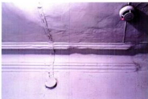
Фото №15. Трещины в штукатурном слое потолка. Профилированные тэги имеют сколы. Нечеткие грани архитектурных обломов потолочных тэгов
