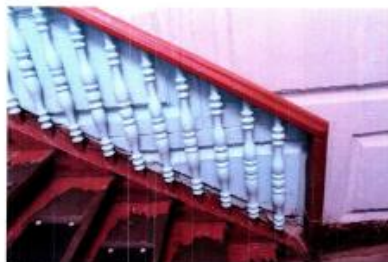
Фото №12. Ограждение лестницы. Ограждение деревянное оформленное балюстрадами
