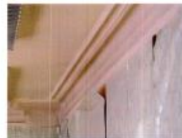
Фото №47. Декоративные элементы потолка: профилированные тяги из архитектурных обломов
