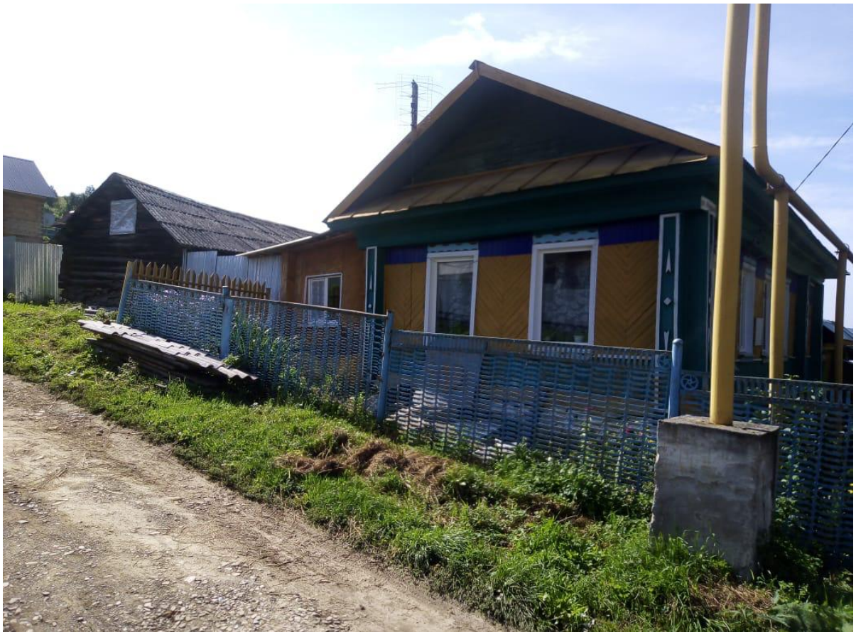
Фото 5. Вид памятника в застройке с восточной стороны. 07.07.2020г.
