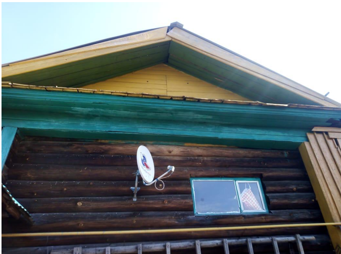
Фото 7. Фрагмент западного дворового фасада памятника. Бревенчатая часть стены без обшивки. 07.07.2020г.
