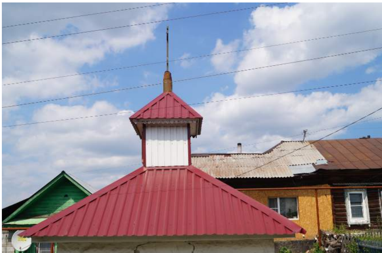
Фото 3. Вид на выявленный объект культурного наследия «Часовня надкладезная», расположенный по адресу: Челябинская область, Миасский городской округ, г. Миасс, ул. Мельничная.
