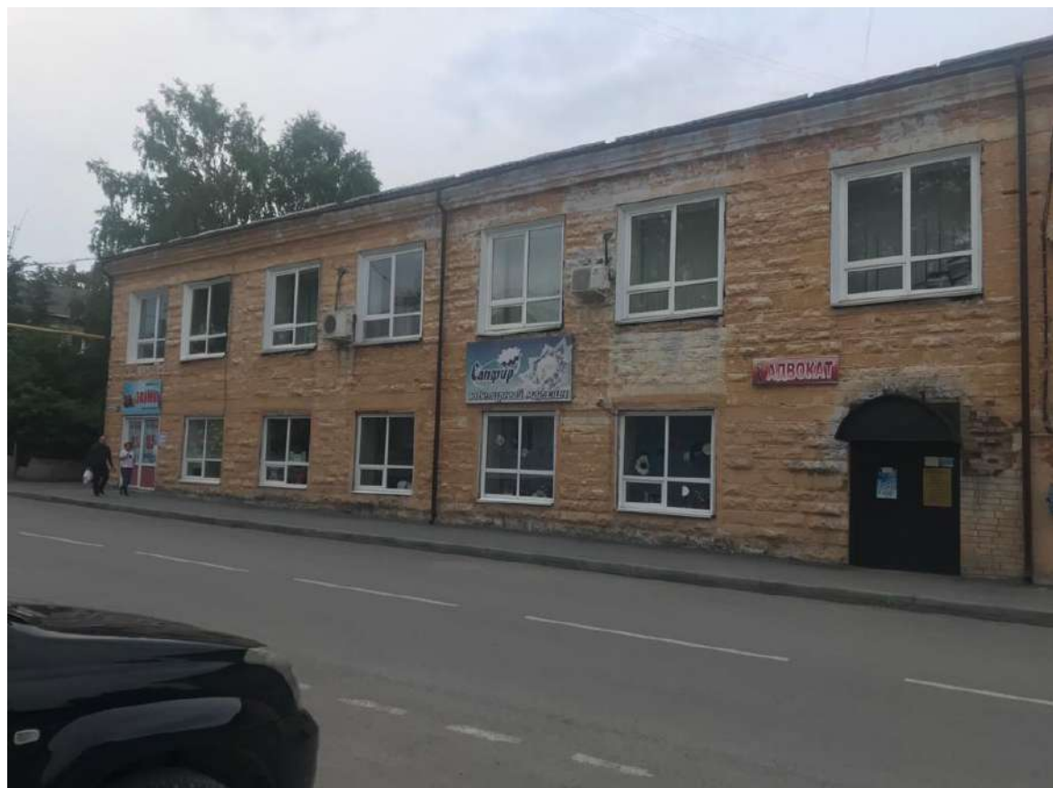
Фото 5. Вид памятника с западной стороны. Поздняя пристройка. 06.07.2020г.
