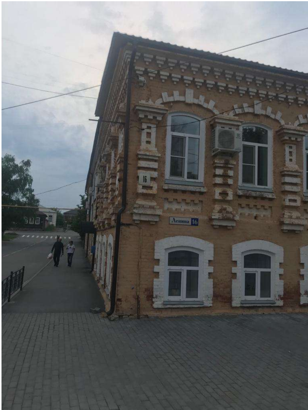
Фото 2. Фрагмент южного фасада. Венчающий карниз, декорированный городчатым поясом. Окна 2-го этажа заключенные в единую орнаментальную рамку. 06.07.2020г
