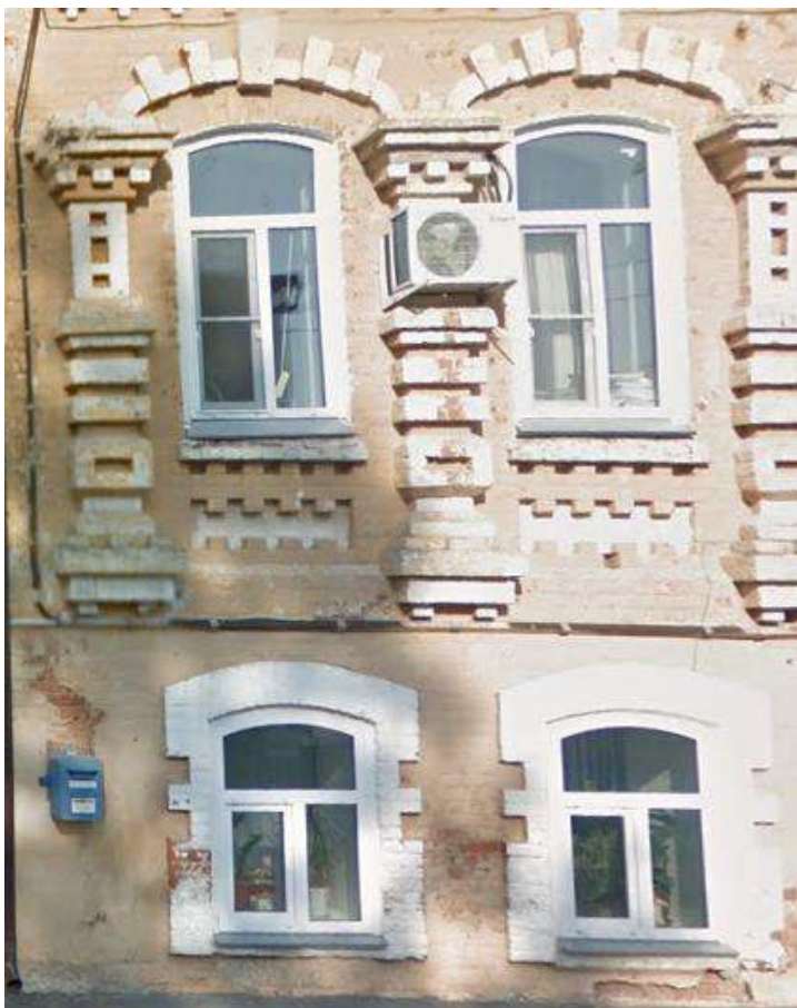
Фото 6. Обрамление и расстекловка оконных проемов. 06.07.2020г.
