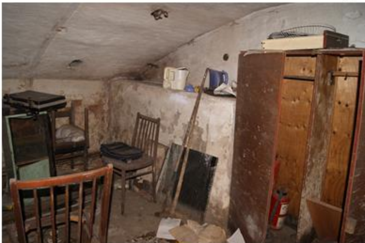
Подвал. Кирпичный цилиндрический свод
