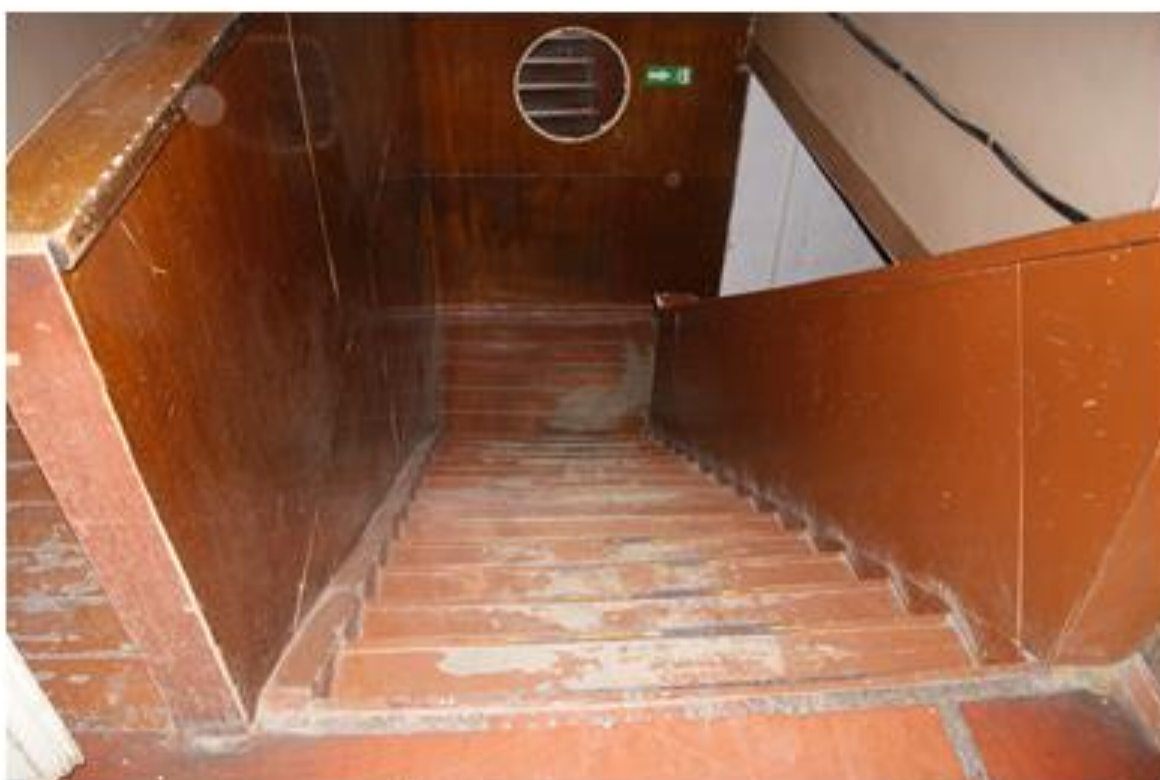
Лестница со второго этажа
