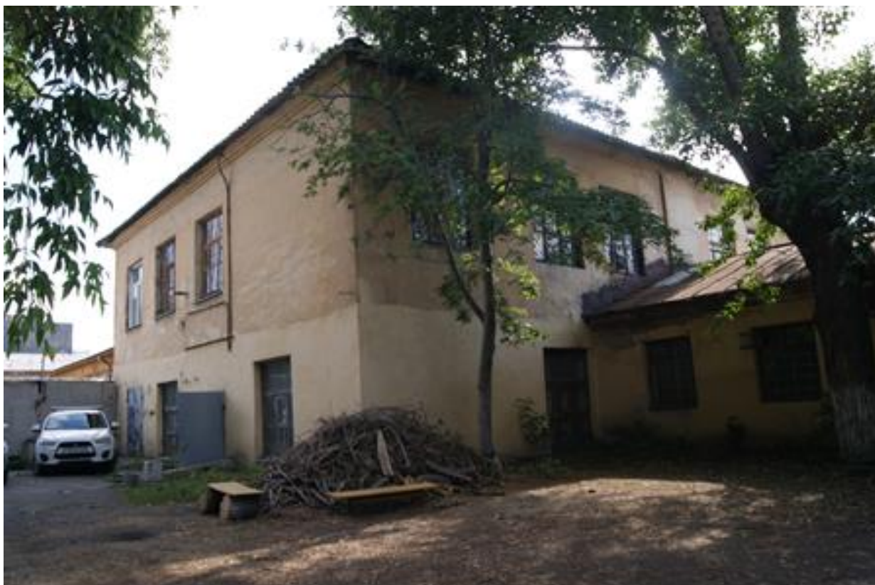
Вид на восточный фасад здания
