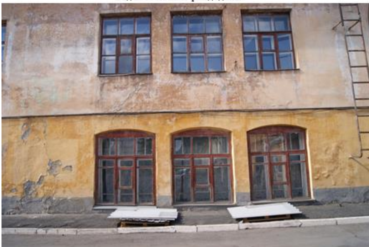
Фрагмент южного фасада
