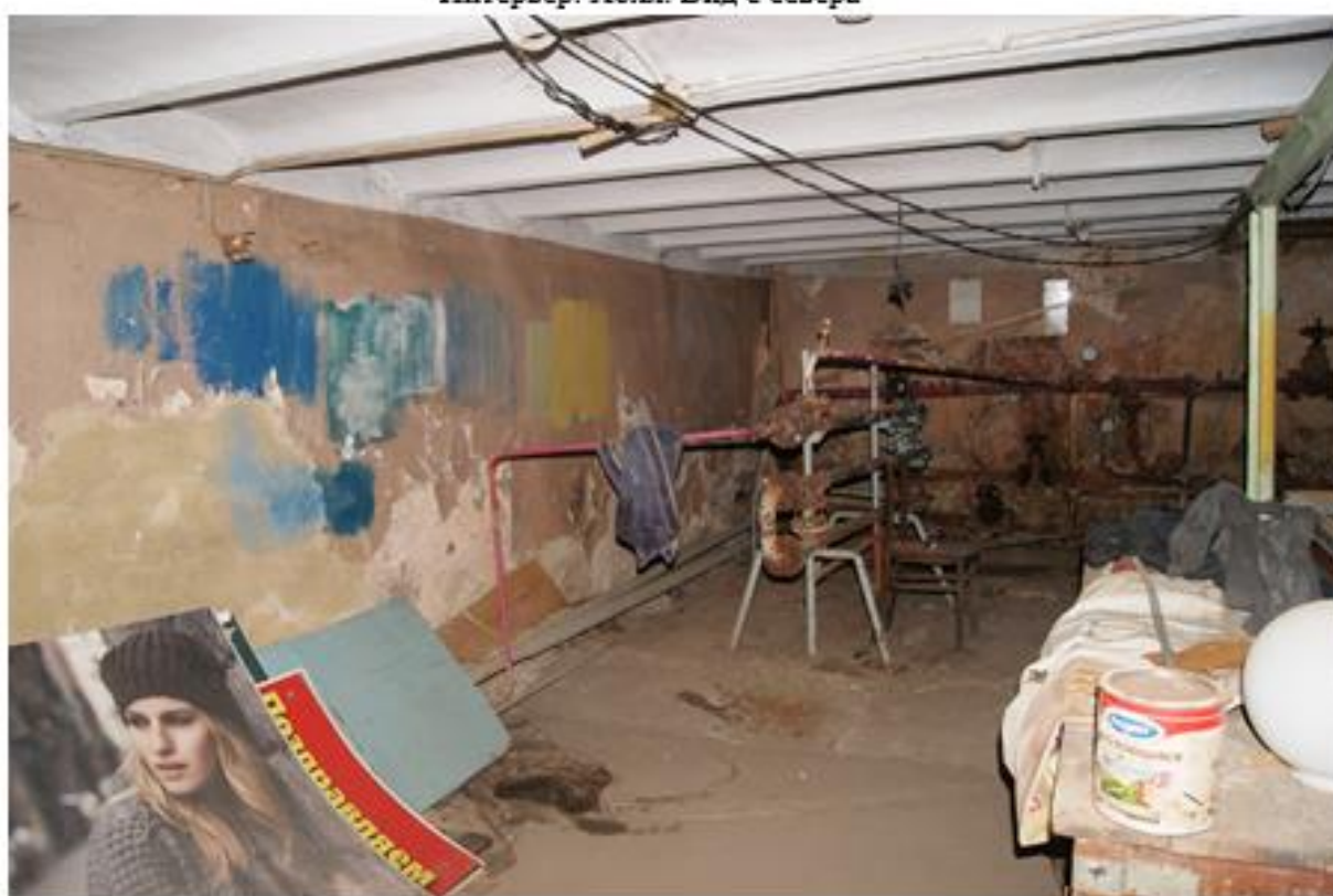
Интерьер. Подвал. Своды Монье
