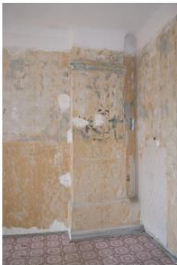
Помещение второго этажа. Печь
