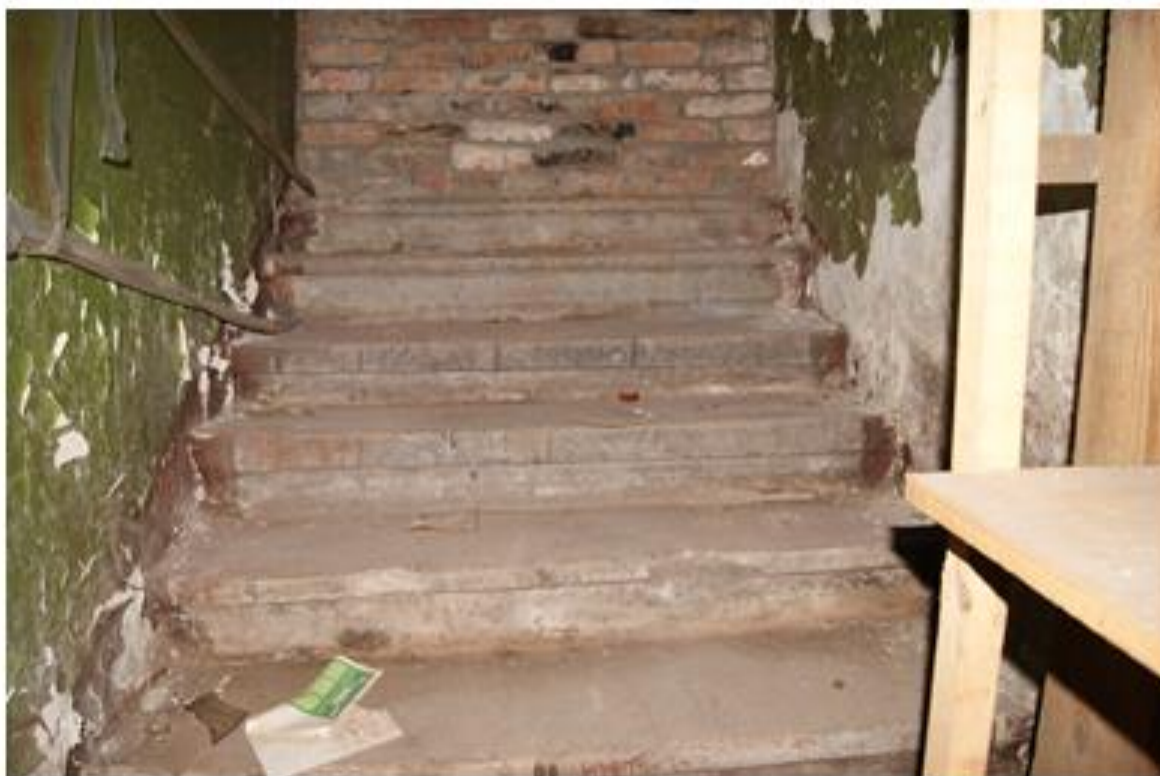
Лестница в подвале с заложённым проёмом
