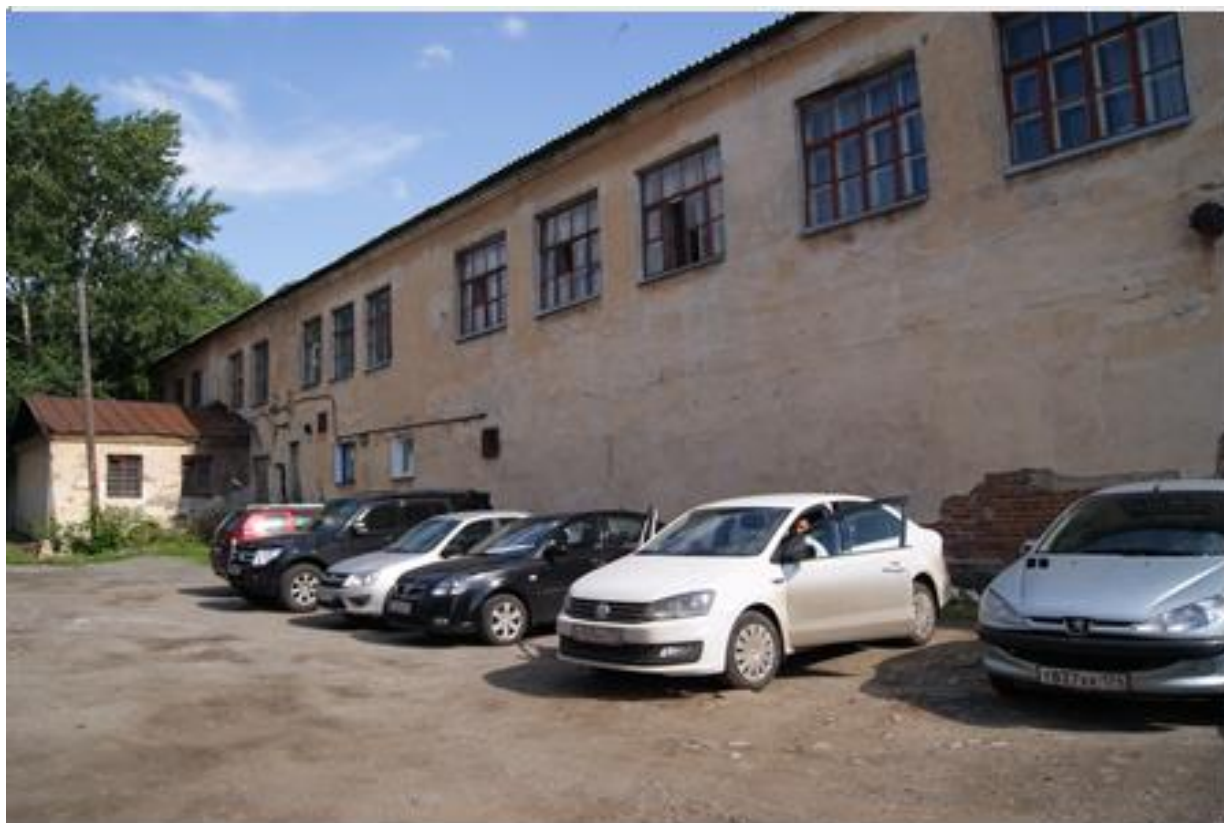
Вид с северо-запада на северный фасад
