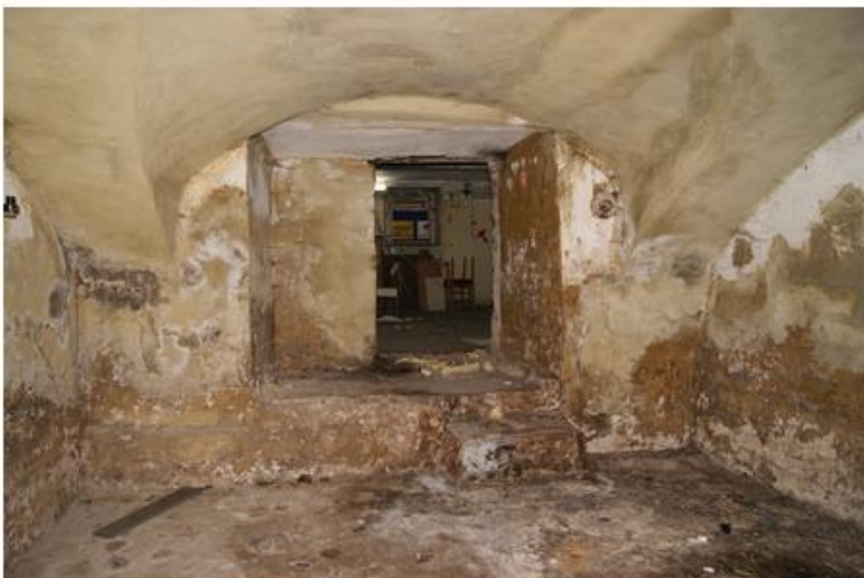
Интерьер. Подвал. Кирпичные своды
