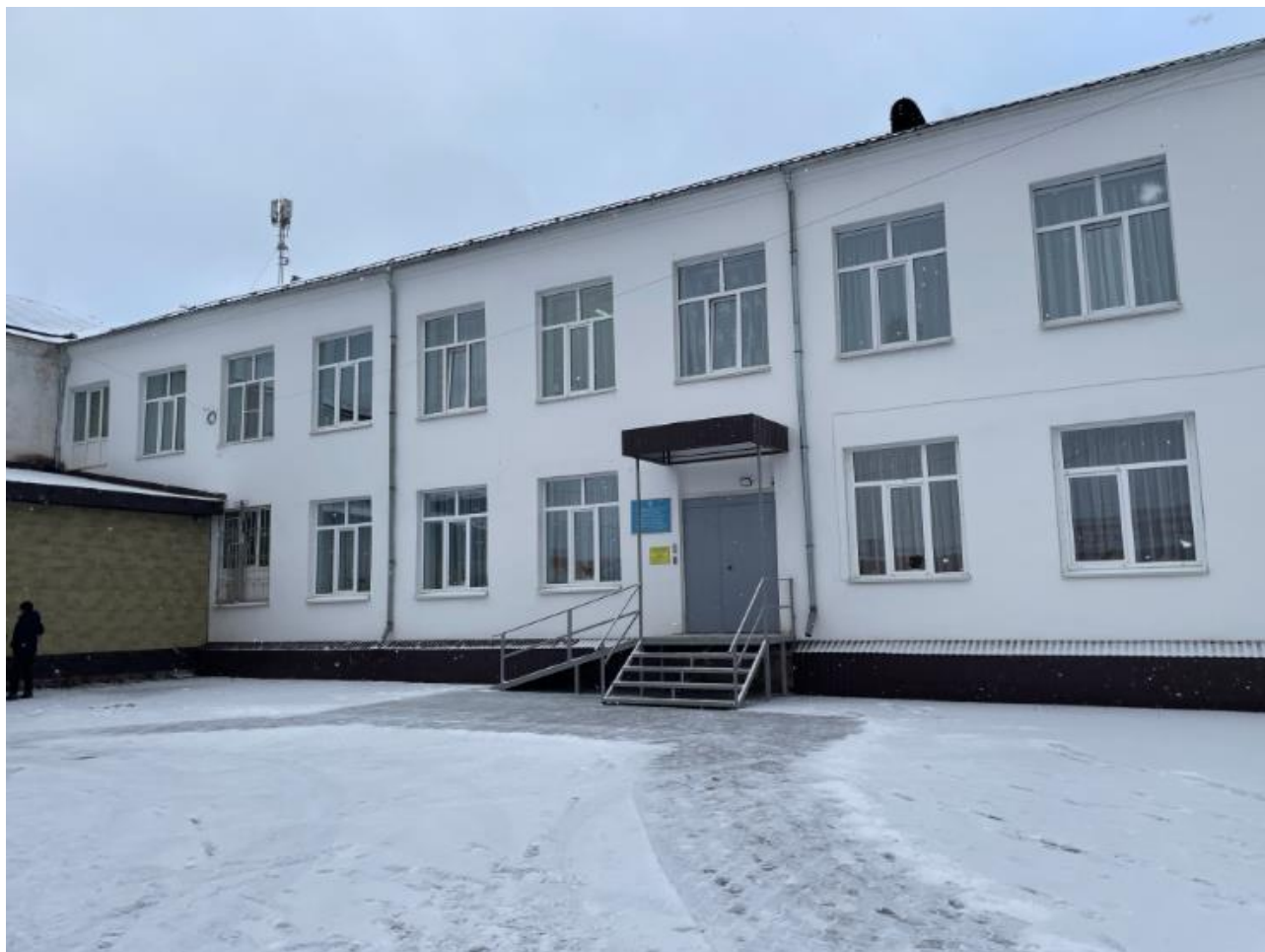
Фото 13. Выявленный объект культурного наследия «Здание школы № 1, где располагался эвакогоспиталь» по адресу: Челябинская обл., г. Юрюзань, ул. Советская, 96. Общий вид выявленного объекта культурного наследия.
