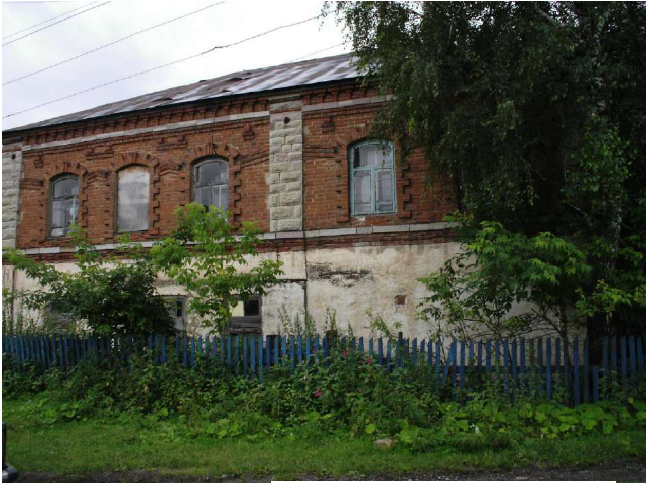
Фотография Объекта из архива МУК «Краеведческий музей Катав-Ивановского муниципального района». Начало XXI века. Северный фасад по ул. Костина.
