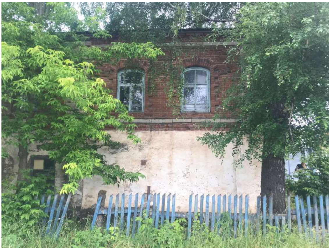
Фото 2. Фрагмент северного фасада, выходящего на ул. Костина. 08.07.2020г.
