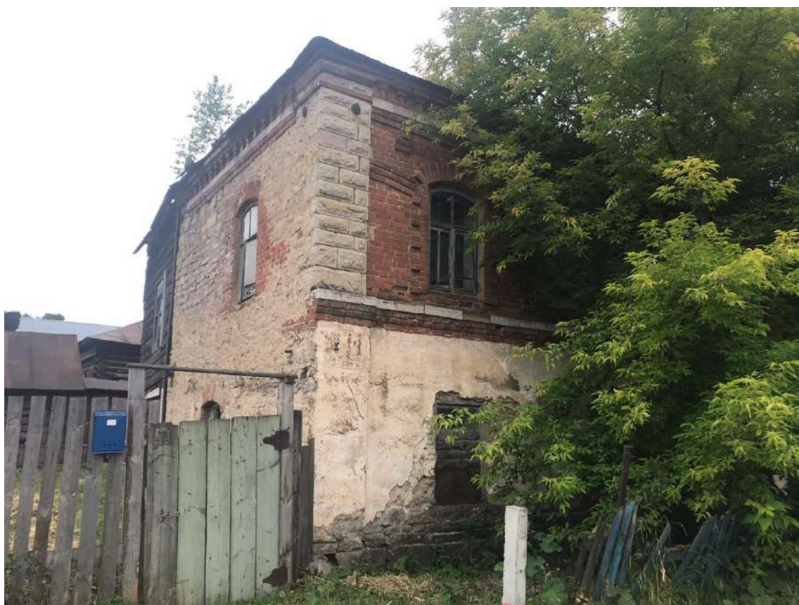
Фото 3. Северный и восточный фасады памятника. 08.07.2020г.
