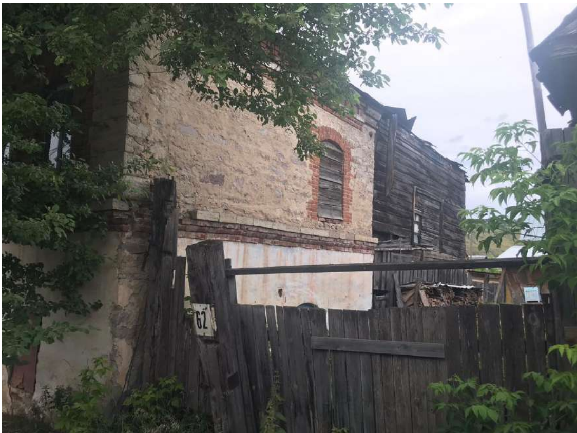
Фото 5. Южный фасад Объекта. Дворовая территория. В деревянном пристрое размещается лестница. 08.07.2020г.
