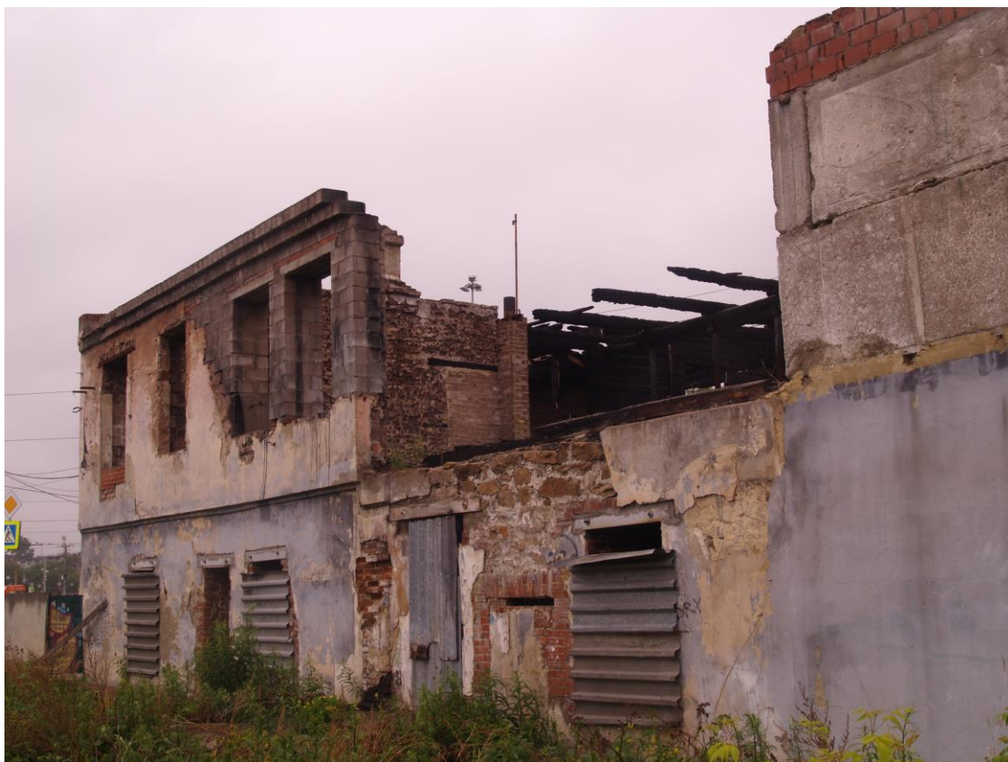
Фото 4. Объект культурного наследия. Общий вид с СЗ.
