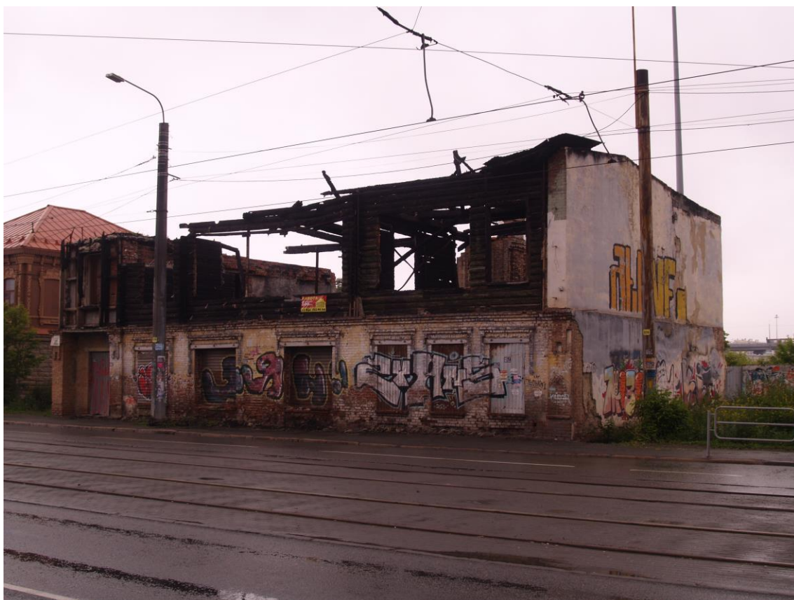
Фото 6. Видовое раскрытие объекта культурного наследия с ЮВ. Шаг 1.
