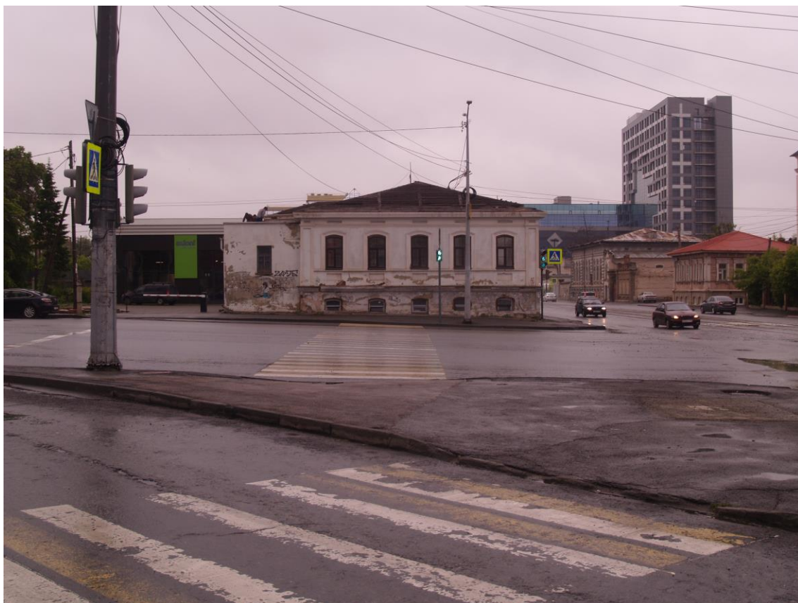
Фото 26. Градостроительная ситуация на территории исследования.
