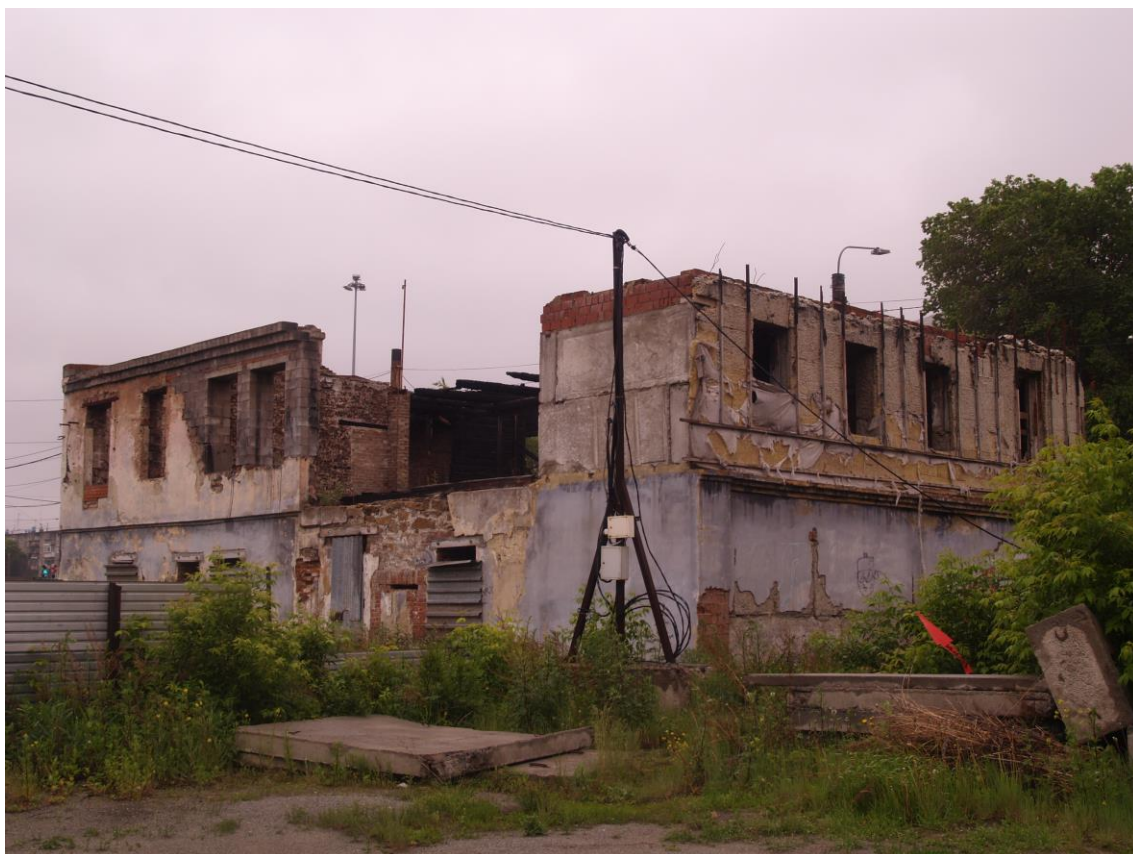
Фото 5. Объект культурного наследия. Общий вид с СЗ.
