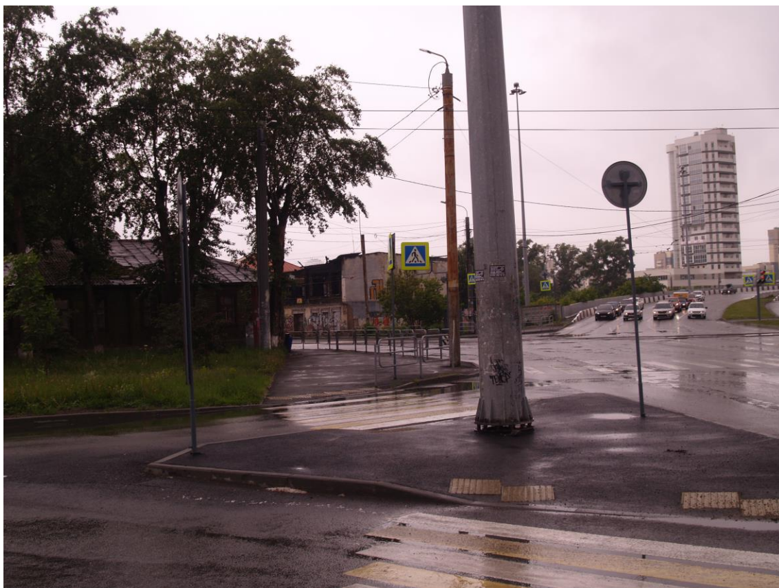
Фото 9. Видовое раскрытие объекта культурного наследия с ЮВ. Шаг 4.
