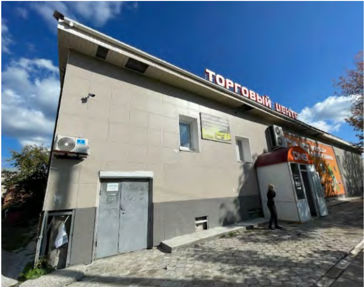
Фото 17. Выявленный объект культурного наследия «Дом купца Прохорова Н.Г.» по адресу: Челябинская обл., г. Верхний Уфалей, ул. Ленина, 157. Фрагмент западного фасада выявленного объекта культурного наследия.
