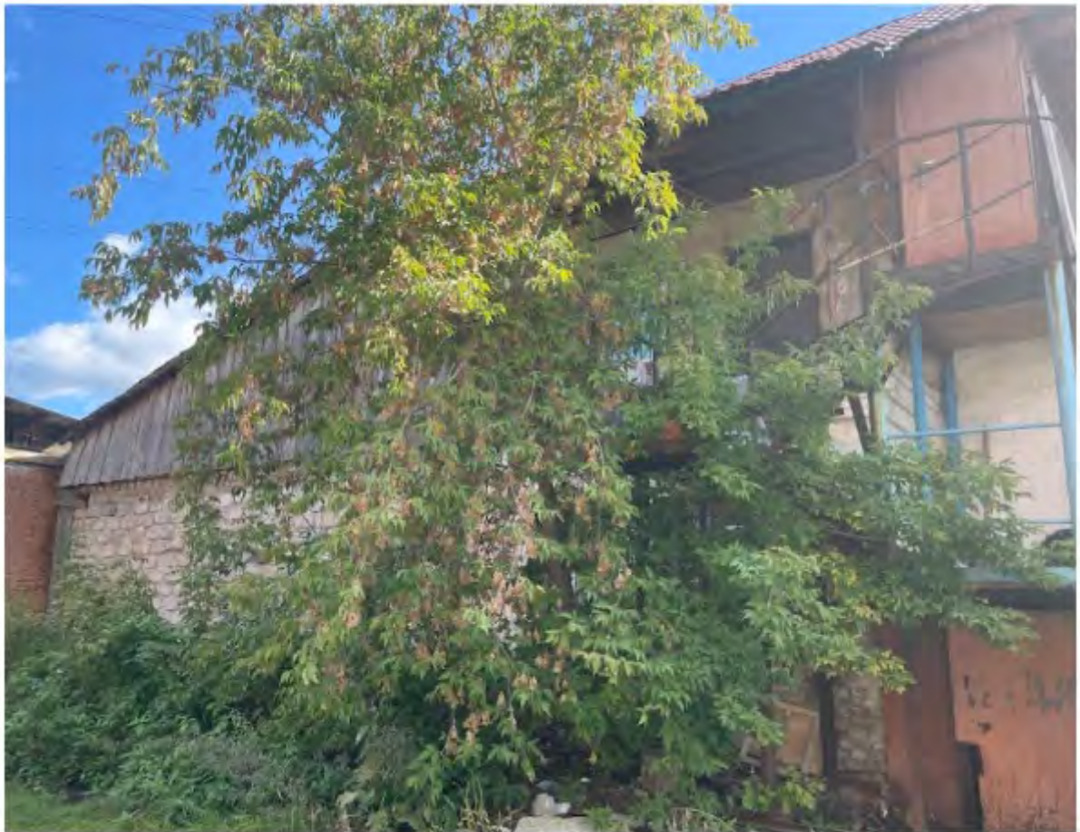
Фото 15. Выявленный объект культурного наследия «Дом купца Прохорова Н.Г.» по адресу: Челябинская обл., г. Верхний Уфалей, ул. Ленина, 157. Фрагмент северного фасада выявленного объекта культурного наследия.
