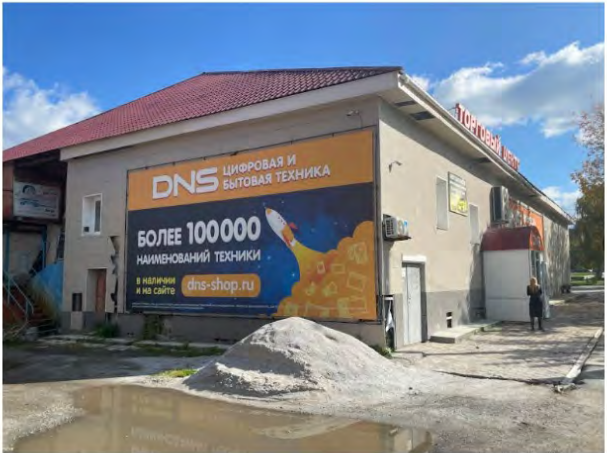
Фото 12. Выявленный объект культурного наследия «Дом купца Прохорова Н.Г.» по адресу: Челябинская обл., г. Верхний Уфалей, ул. Ленина, 157. Фрагмент северного фасада выявленного объекта культурного наследия.
