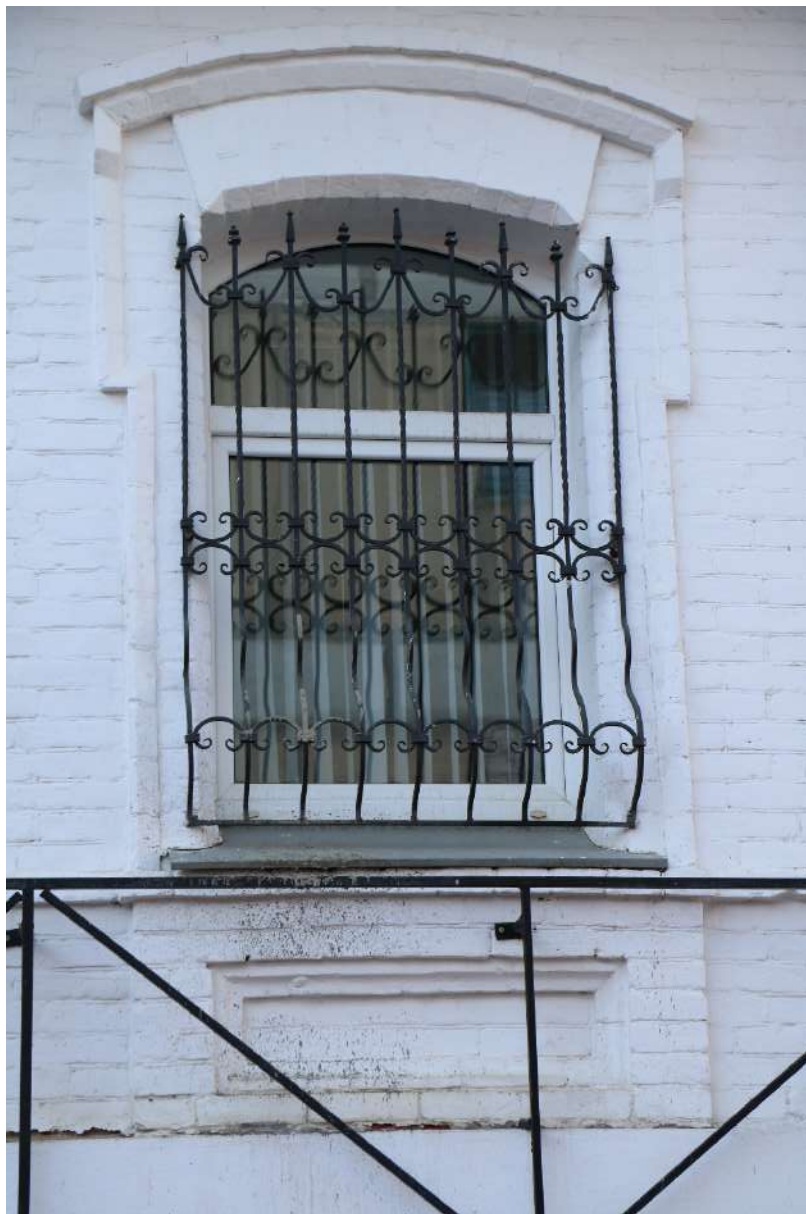
Фрагмент южного фасада
