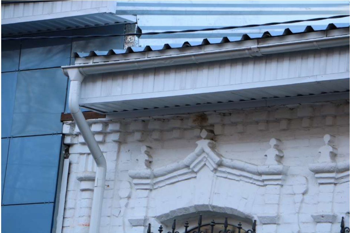
Фрагмент карниза западного фасада
