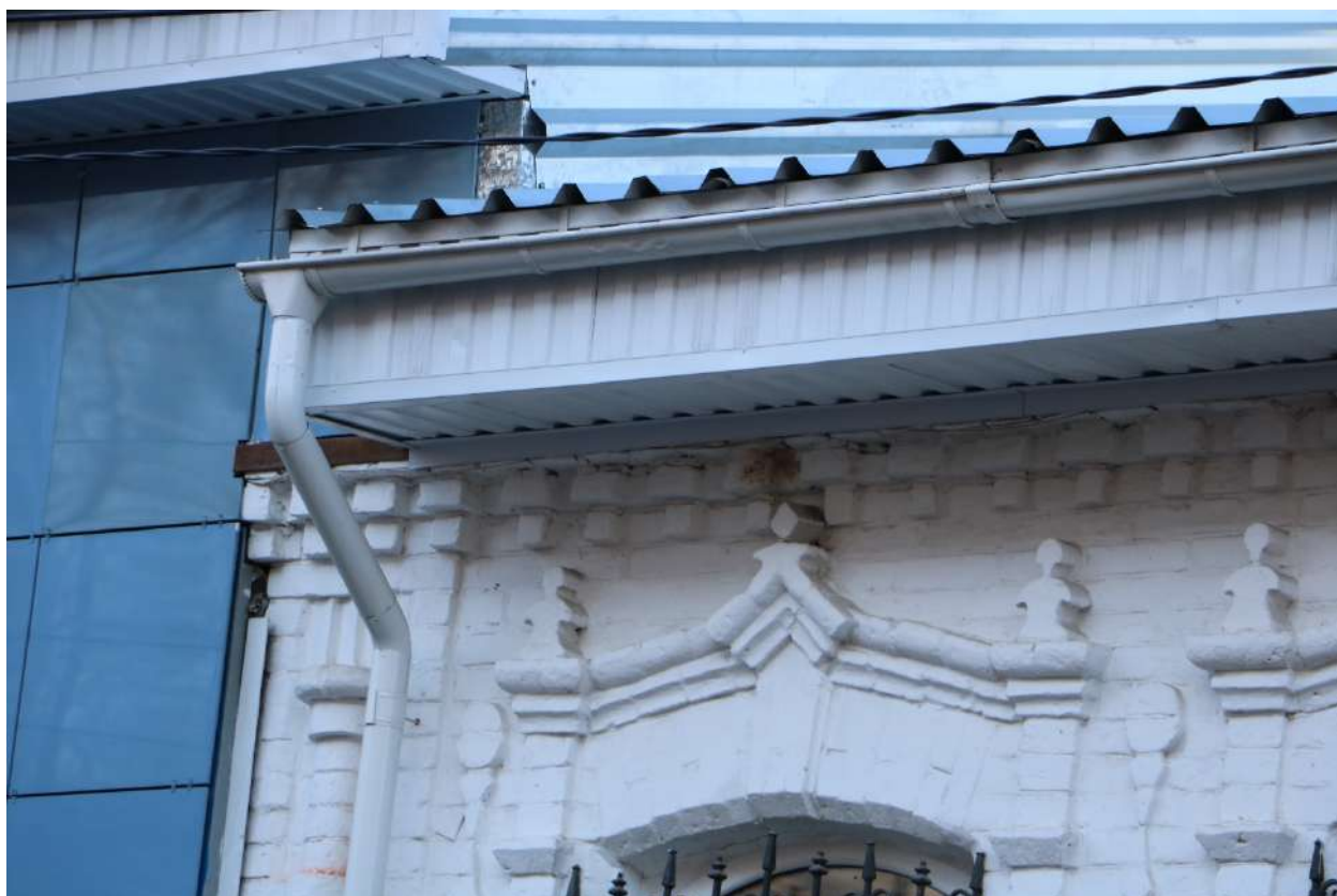
Фото 6. Выявленный объект культурного наследия. Фрагмент фасада. Вид с ЮЗ.
