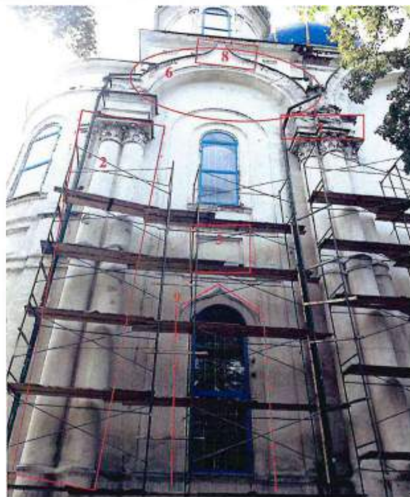
Печи на лепилі філані крайової частини фасада
