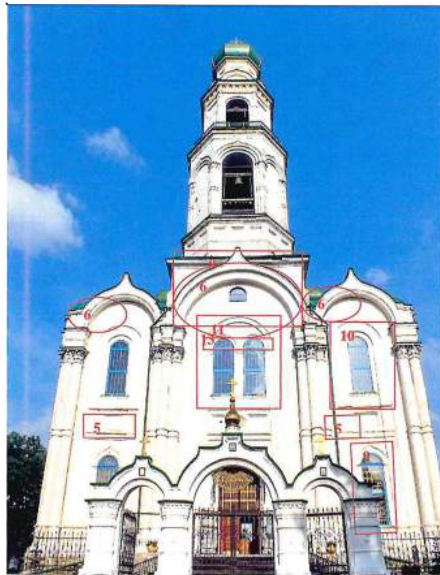
Вид на западный фасад
