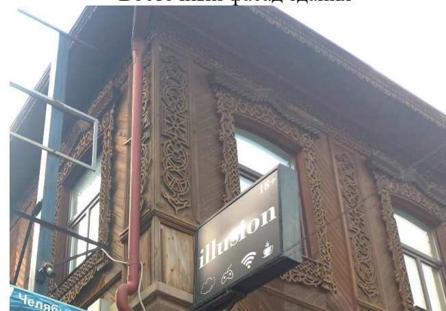
Фрагмент восточного фасада здания
