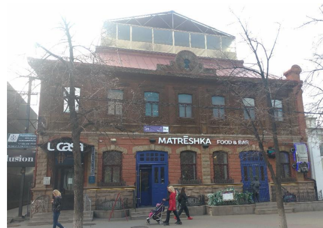
Восточный фасад здания
