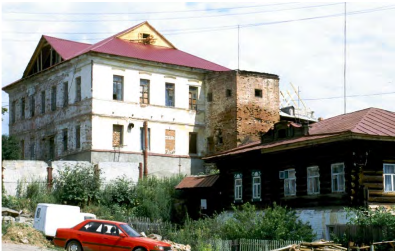
Рис.3. Фотография объекта, 2003 г., фото Уильям Брумфильд.
