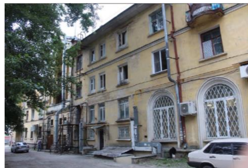
Вид на дворовый фасад правого крыла здания-памятника
