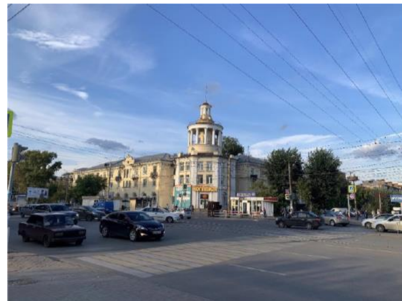
Общий вид на центральную часть здания с юго-западной стороны
