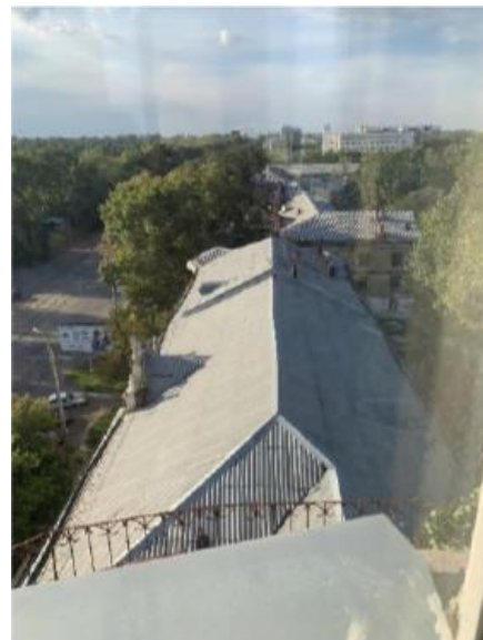
Фрагмент вальмовой кровли левого крыла здания-памятника
