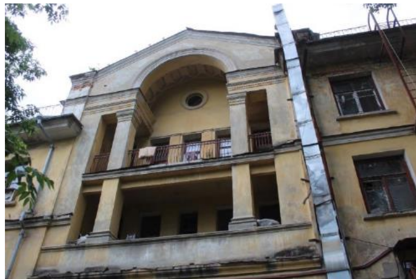
Фрагмент дворового фасада правого крыла здания-памятника
