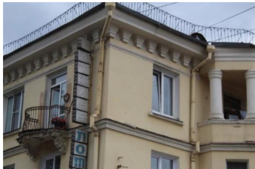
Фрагмент угла торцевого и дворового крыла. Карнизные пояса верхнего этажа. Французские балкончики, водостоки.
