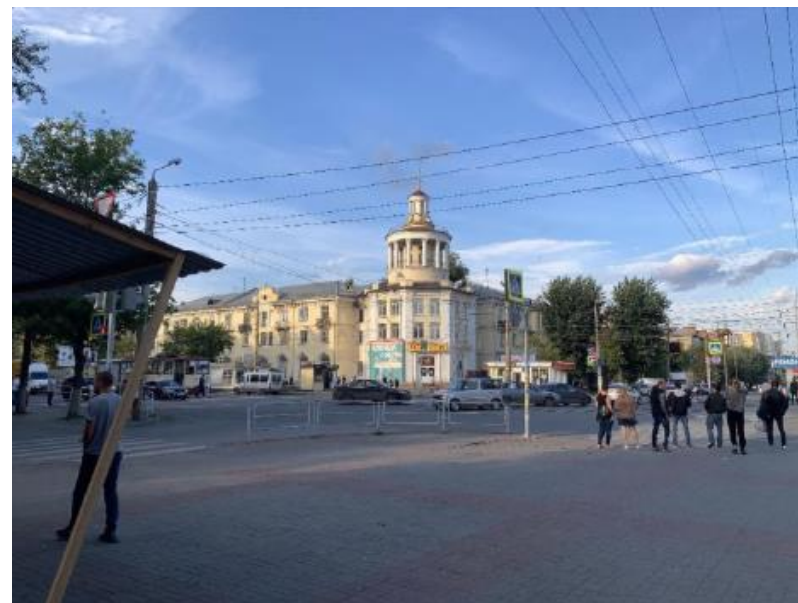
Общий вид на фасад здания со стороны дороги
