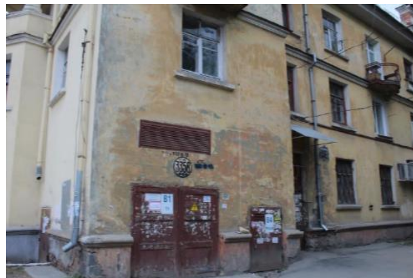
Фрагмент дворового фасада правого крыла здания-памятника. Вход в трансформаторную
