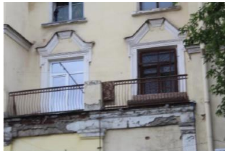
Фрагмент центральной главной части фасада по улице Салютная. Декоративное оформление окон второго этажа с рамочными наличниками и карнизными трапециевидными сандриками, прерывающимися во внешних углах
