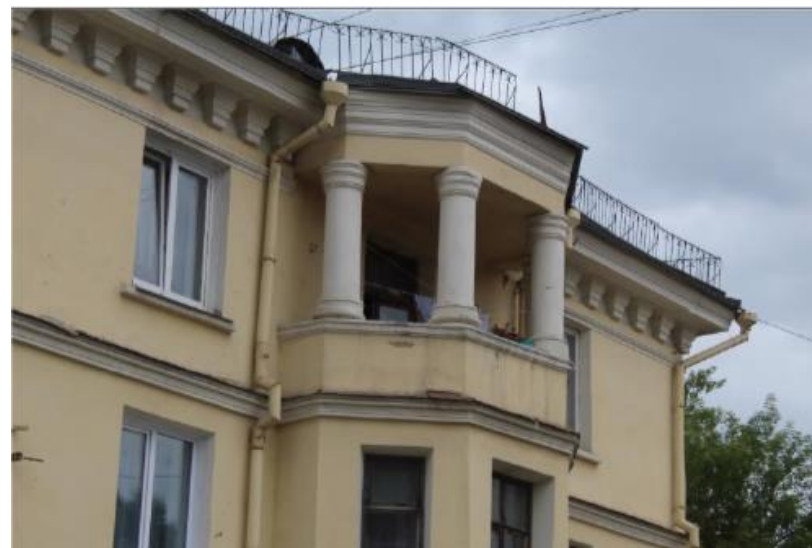
Фрагмент торцевого фасада правого крыла с центральным эркером. Открытый балкон третьего этажа в виде портика
