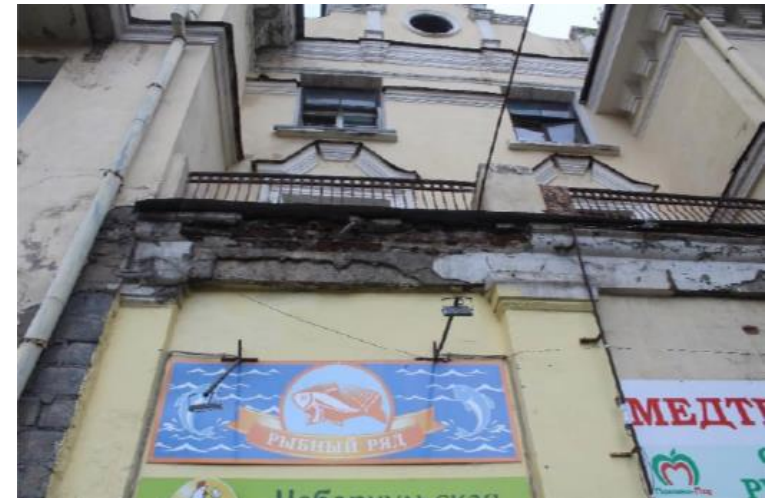
Фрагмент входной группы в западающей части правого крыла здания-памятника
