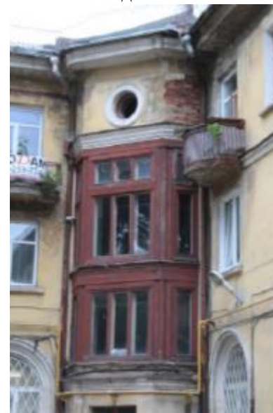
Фрагмент центральной угловой башни здания-памятника со стороны двора. Витраж, круглое окно и межэтажные карнизы в эркере
