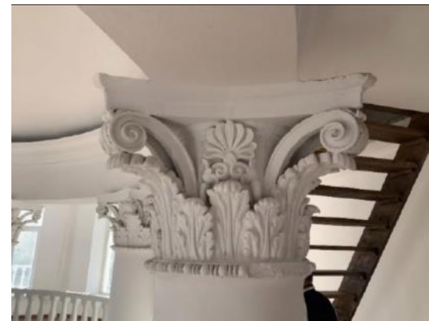
Фрагмент интерьера с лестницей на ротонду центрального углового объема здания-памятника (башни). Капитель коринфского ордера в интерьере третьего этажа башни
