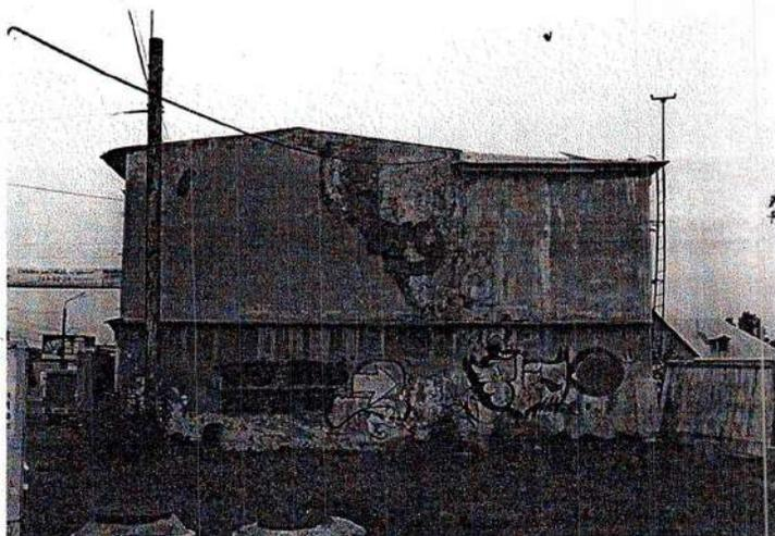
Фото 6. Общий вид здания с восточной стороны. Дефекты: отслоение штукатурного слоя, трещины
