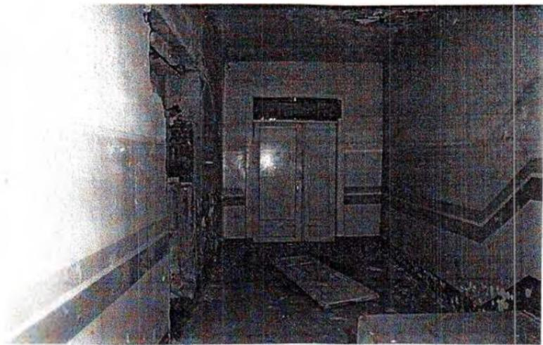
Фото 10. Фрагмент интерьера помещения № 2 на 1-м этаже здания. Вид на главный вход. Дефекты: отслоение окрасочного слоя, наличие разрушения кирпичной кладки стен
