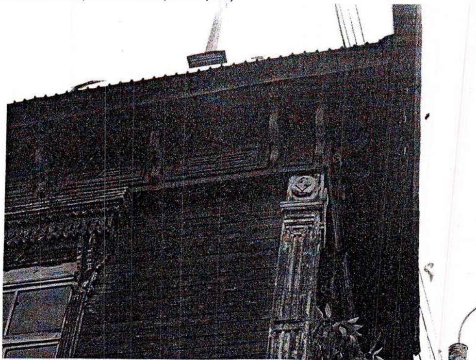
Фото 7. Фрагмент бокового фасада с западной стороны здания. Декоративное оформление оконных проемов и карнизной части
