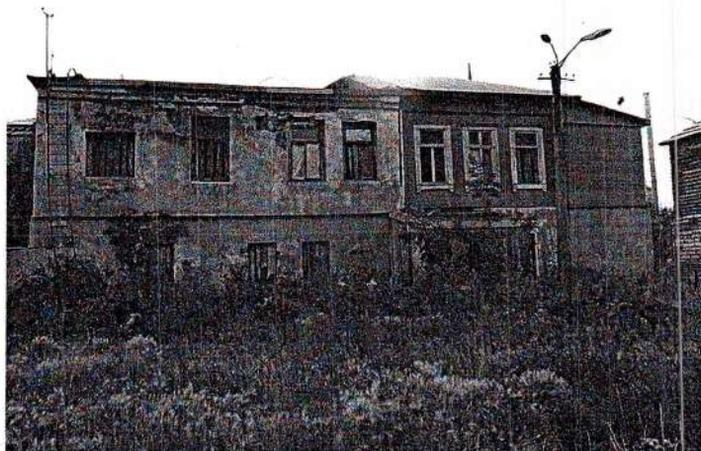
Фото 5. Общий вид здания с северной стороны. Дефекты: разрушение штукатурного, окрасочного слоя, следы намокания в карнизной части здания, отсутствие оконных заполнений
