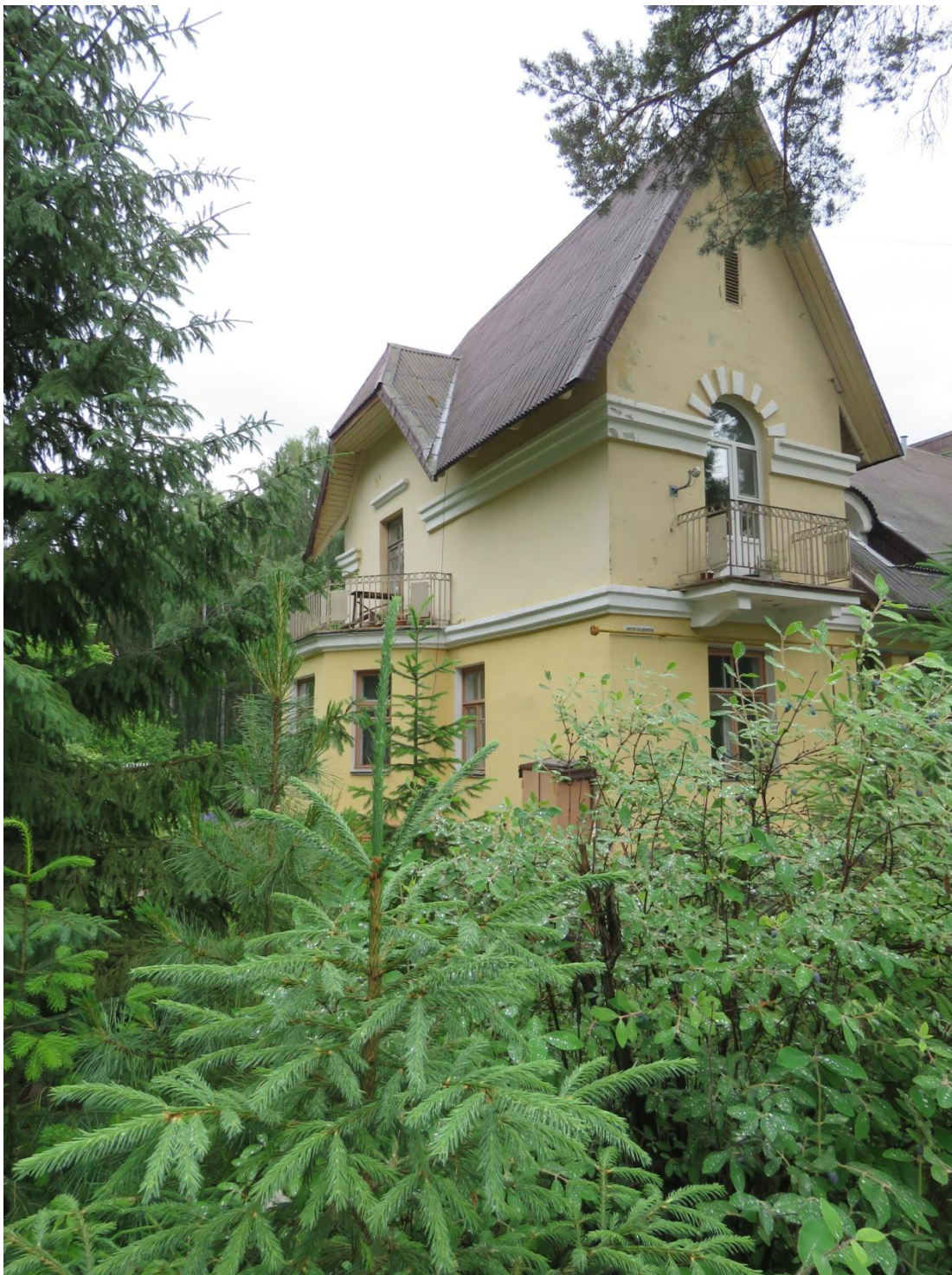
Рис. 5. лицевой и боковой (восточный) фасады левого (восточного) флангового объема
