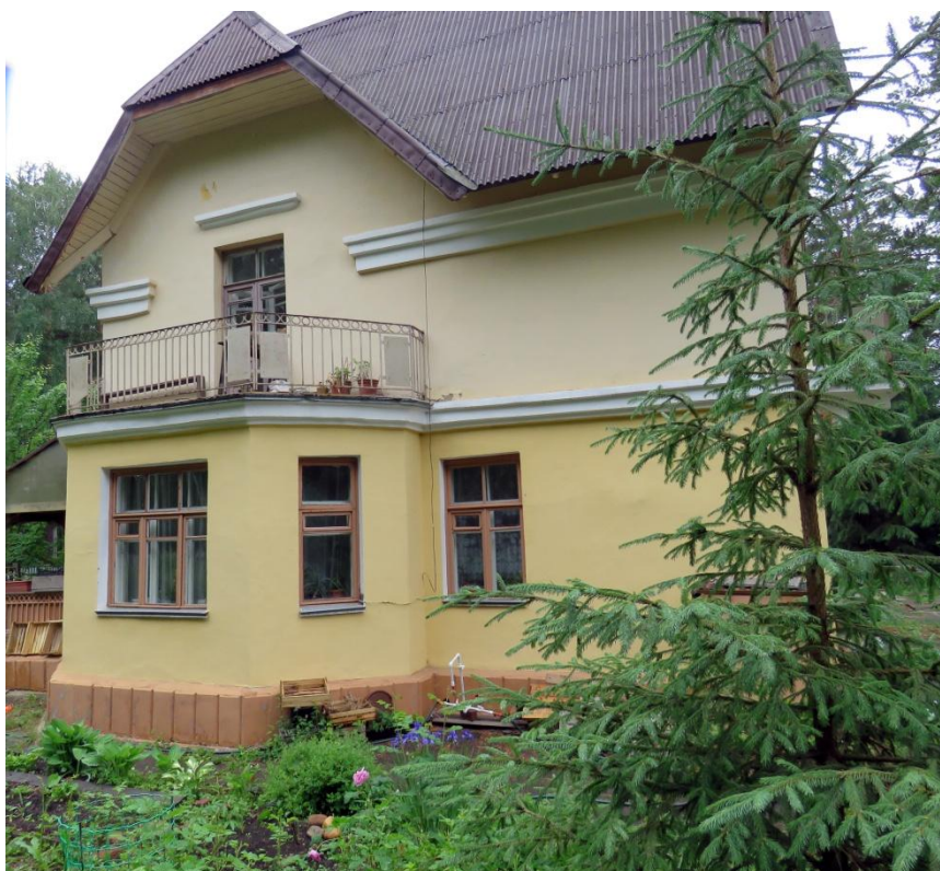
Рис. 6. Боковой, восточный фасад
