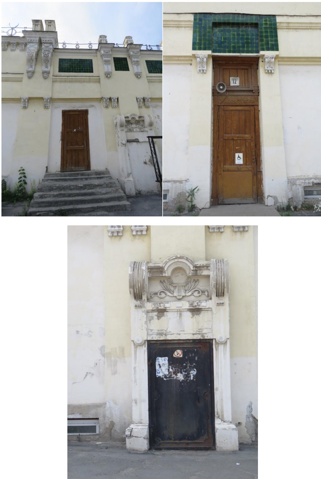
Рис. 5, 6, 7. Фрагменты главного, восточного, фасада. Дверные проемы
