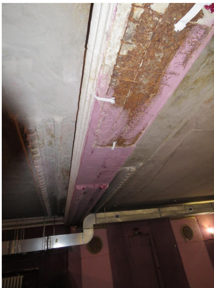
Рис. 33, 34. Балкон зрительного зала. Сохранившийся фрагмент снесенной капитальной стены и плафонных рамок
