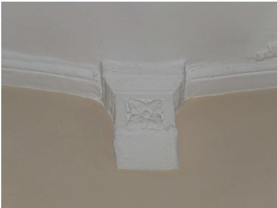
Рис. 23. Фрагмент интерьера. Лепной декор помещения фойе
