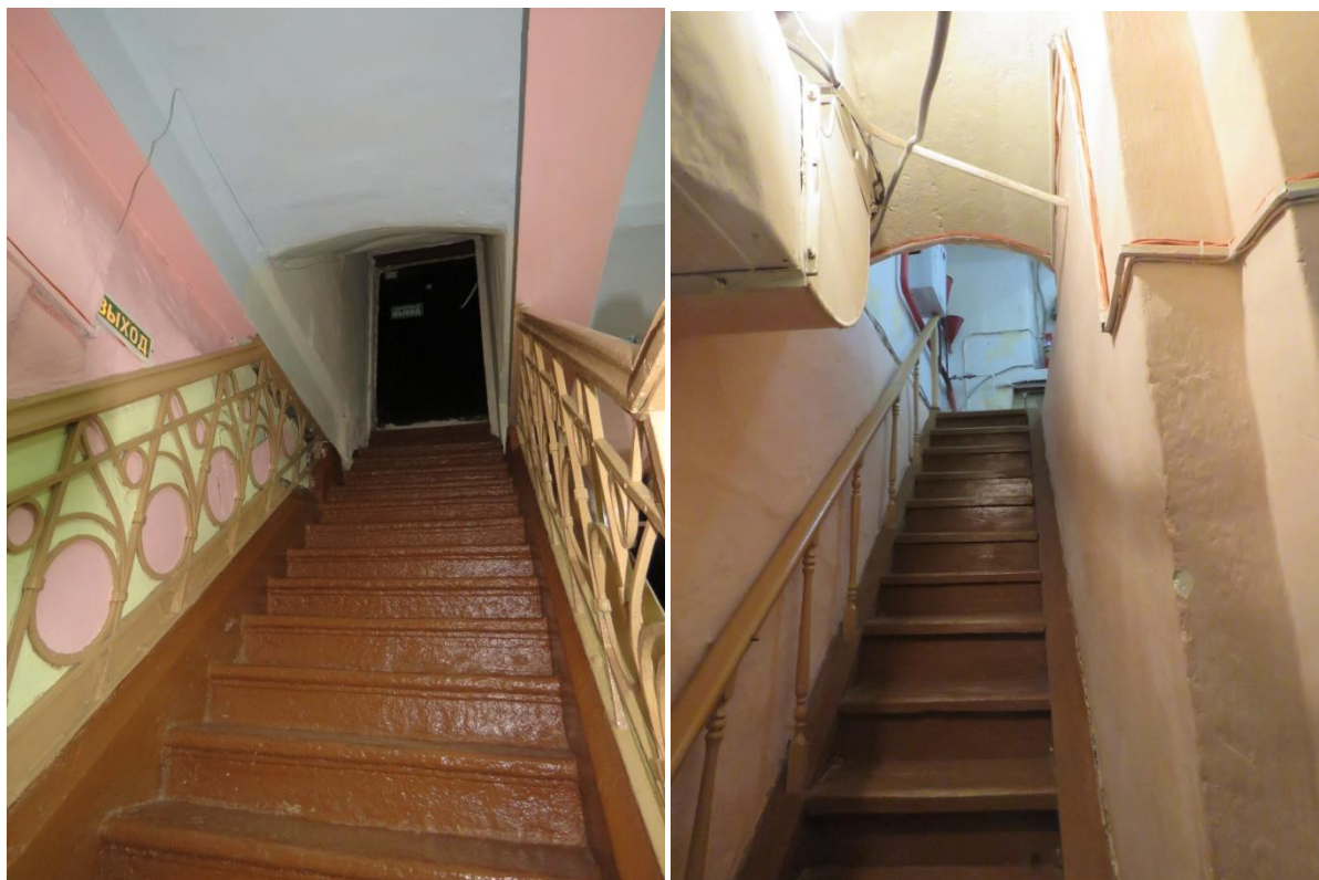
Рис. 38, 39. Фрагменты интерьера. Лестницы подвала
