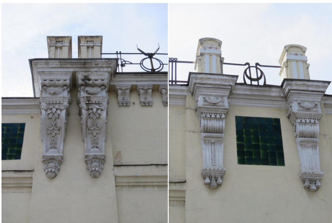
Рис. 12, 13. Фрагменты главного, восточного, фасада. Кронштейны карниза, парапетные столбики и парапетная решетка
