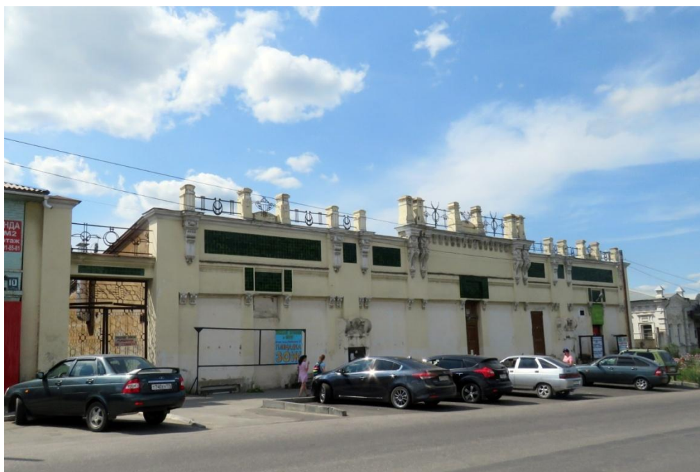
Рис. 1. Вид на главный (восточный) фасад с востока, со стороны ул. Пролетарской
