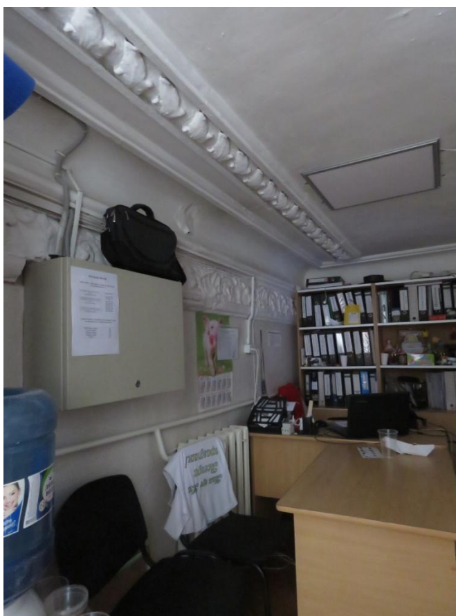
Рис. 27, 28. Фрагменты декора. Орнаментированный фриз, карниз, плафонная рамка
