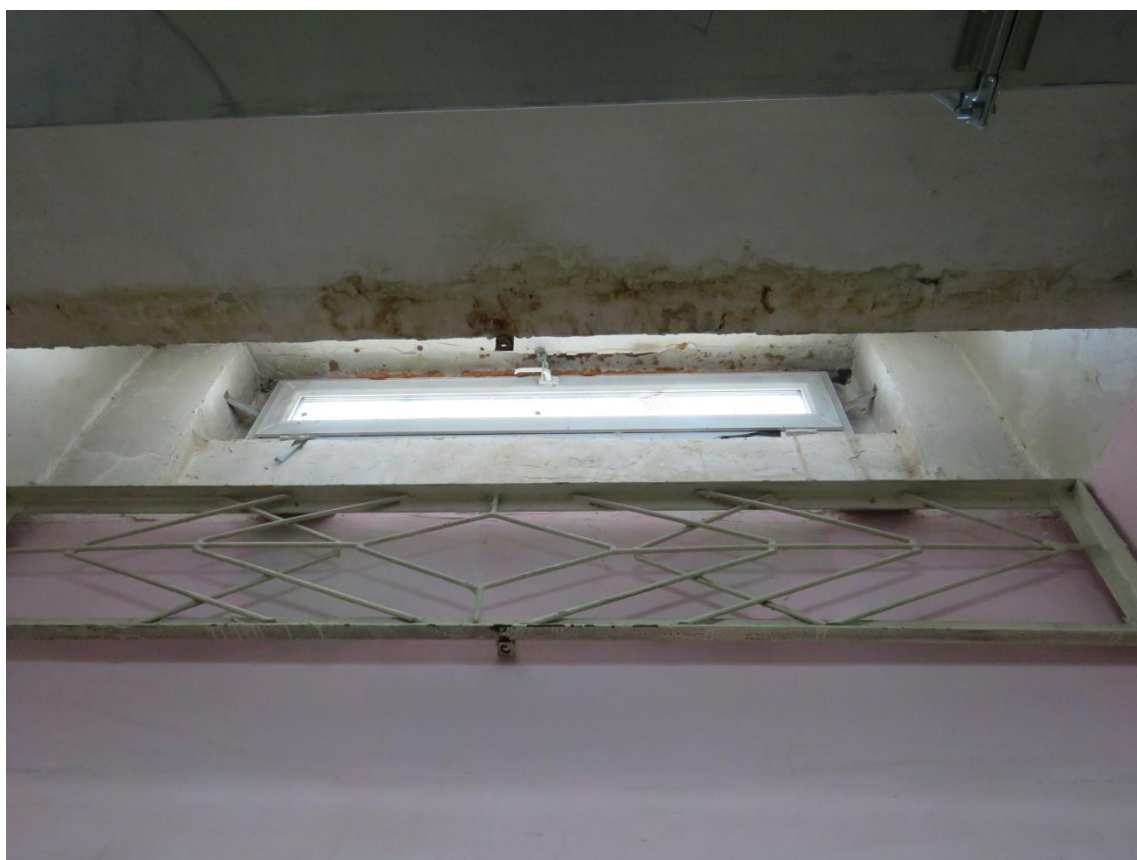
Рис. 10, 11. Фрагменты главного, восточного, фасада. Оконные проемы подвала
