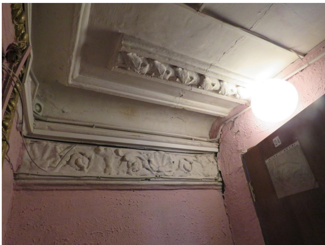
Рис. 29, 30. Фрагменты декора. Орнаментированный фриз, карниз, плафонная рамка
