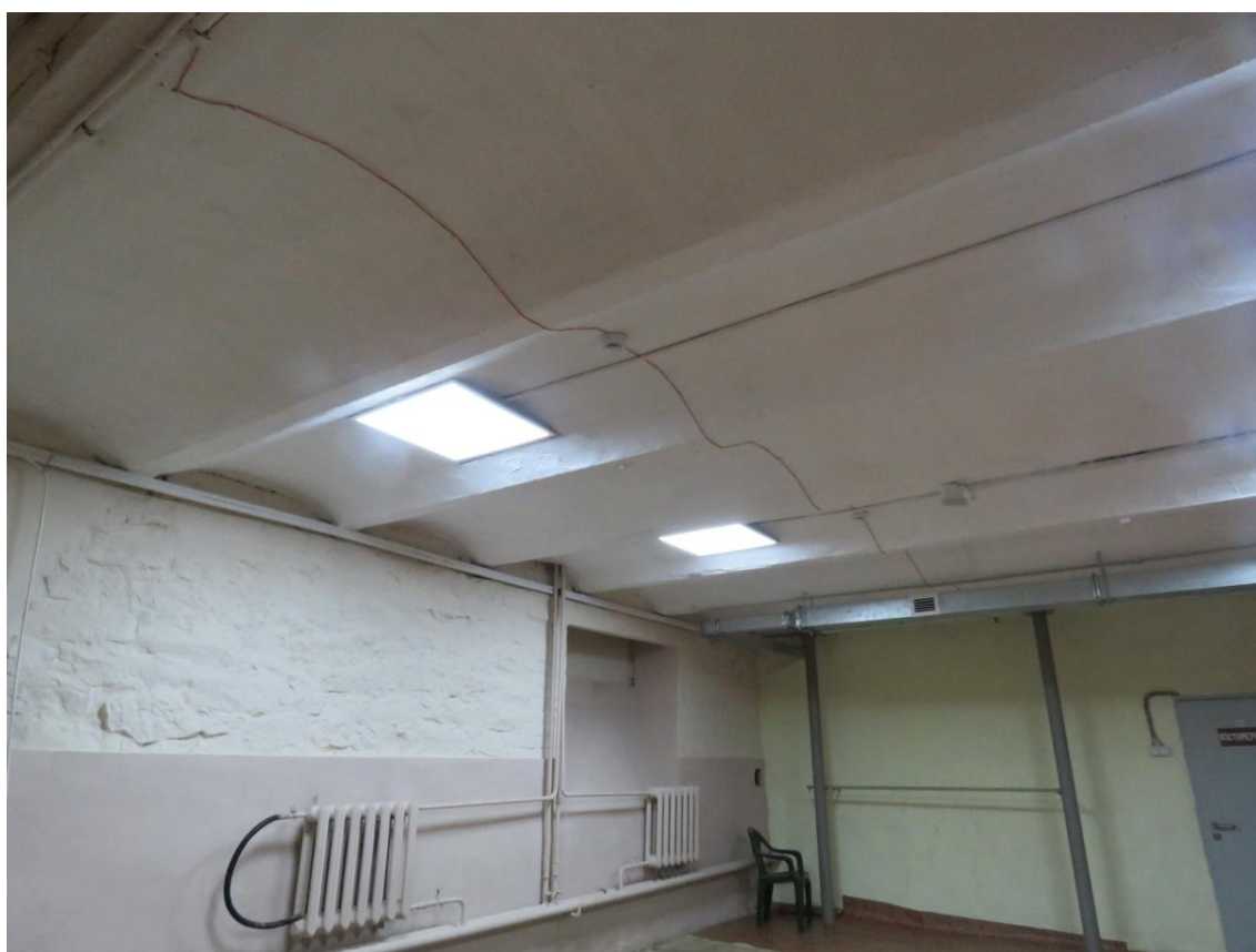
Рис. 35, 36. Фрагмент интерьера. Своды подвала.
