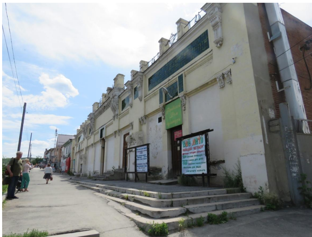
Рис. 2. Вид на главный (восточный) фасад с северо-востока, со стороны ул. Пролетарской
