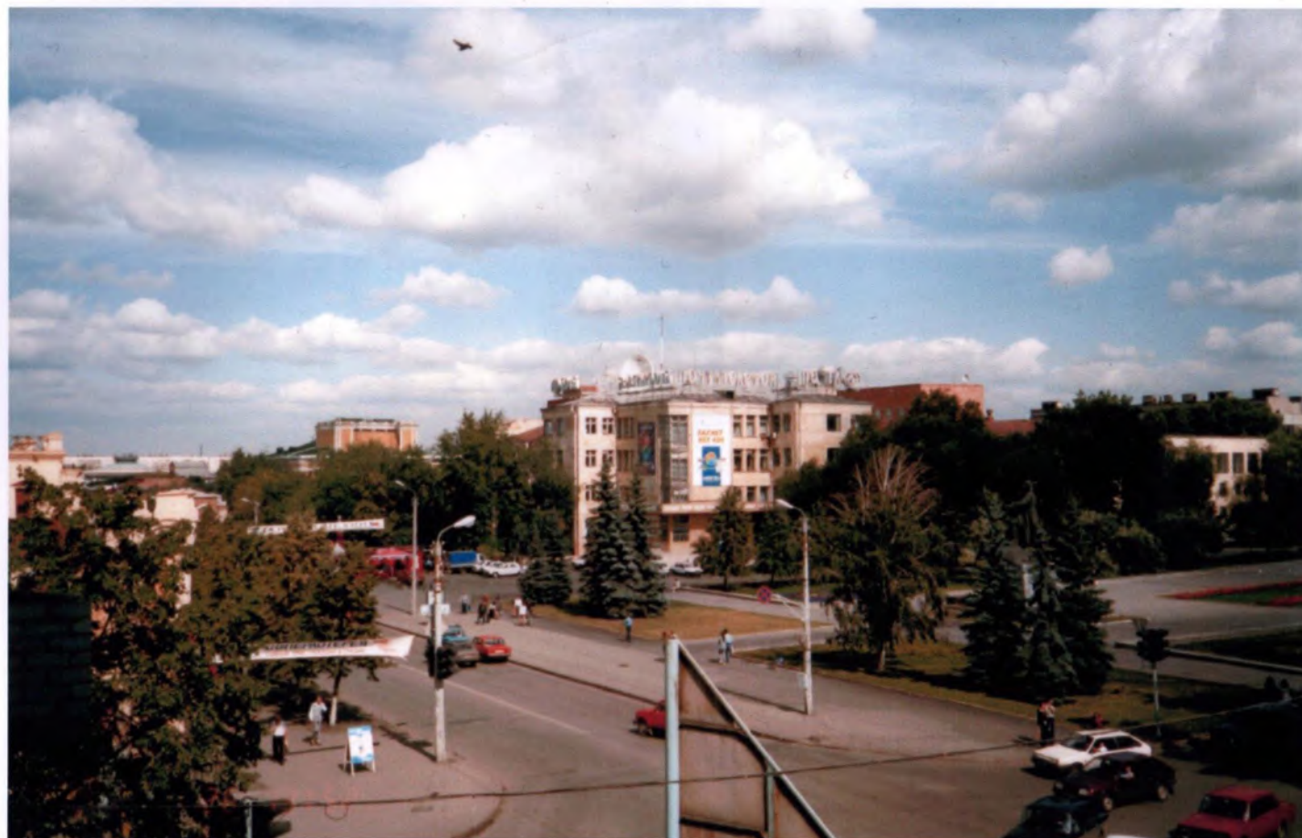
Состояние здания на начало проектных работ по реконструкции. Фотография 2001г.
