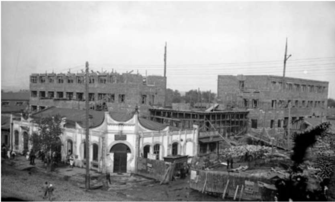
Илл. 3. Строительство здания главпочтамта в 1930-ых гг.; источник - https://arhistrzh.livejournal.com/204376.html .
