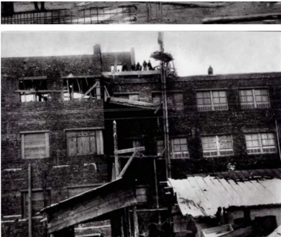
Илл. 6. Строительство здания главпочтамта в 1930-ых гг.; источник - https://arhistrzh.livejournal.com/204376.html .
