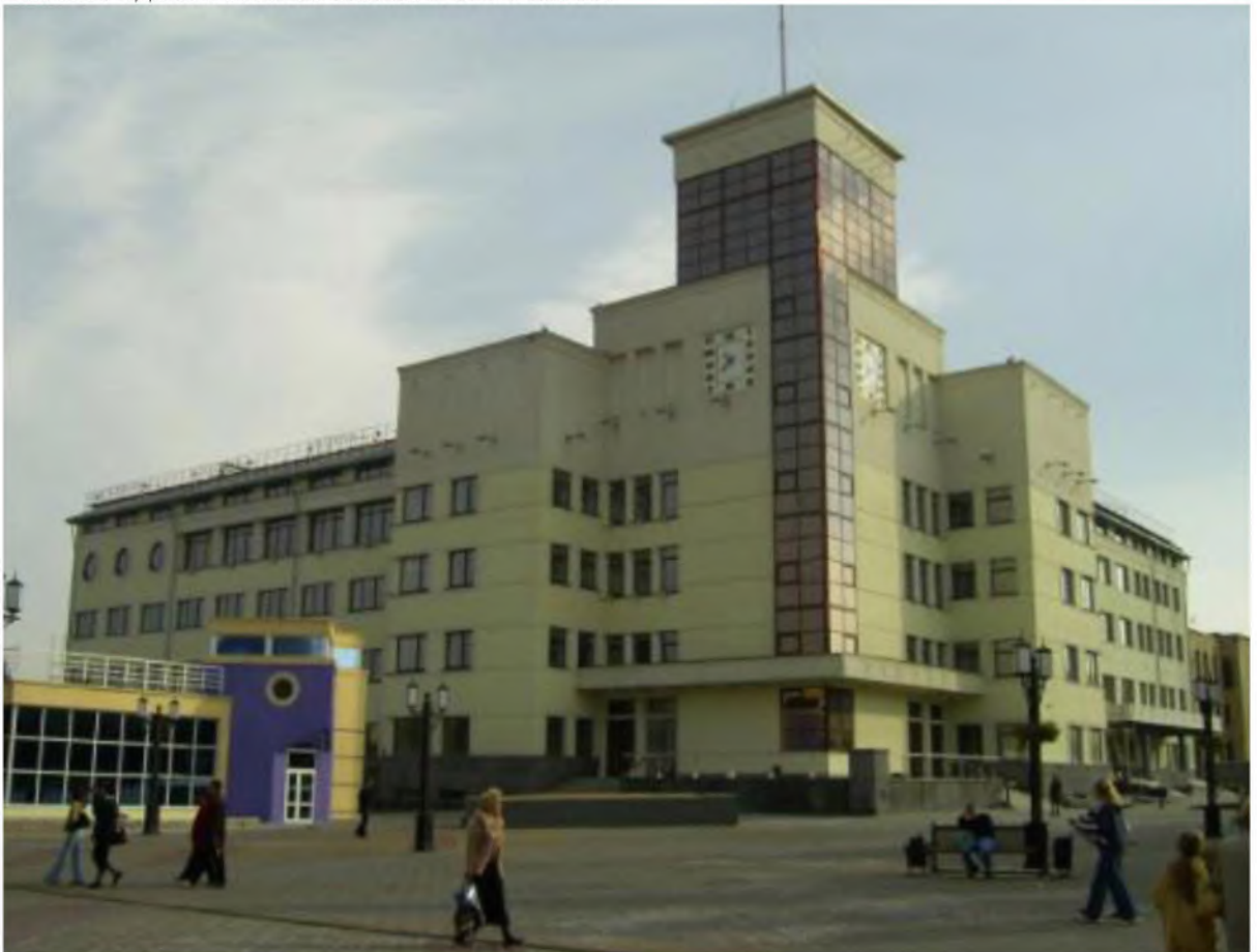
Илл. 22. Здание Главпочтамта в 2003г.
