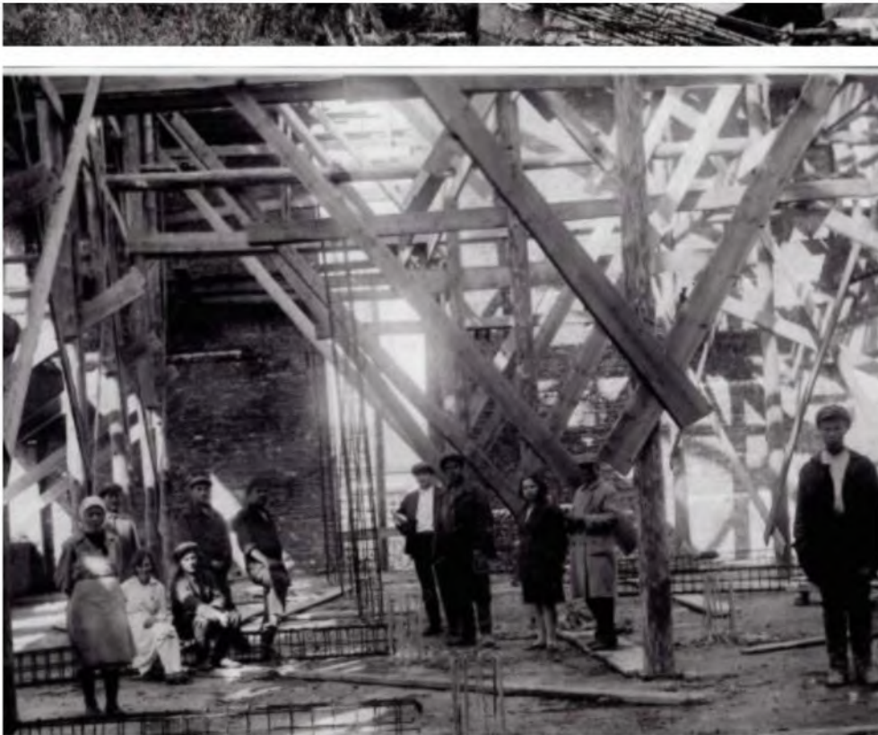
Илл. 5. Строительство здания главпочтамта в 1930-ых гг.; источник - https://arhistrzh.livejournal.com/204376.html .
