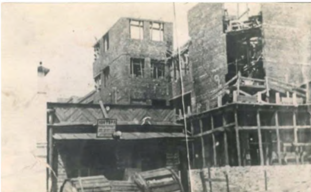
Илл. 10. Строительство здания главпочтамта в 1930-ых гг.; источник - https://arhistrzh.livejournal.com/204376.html .
