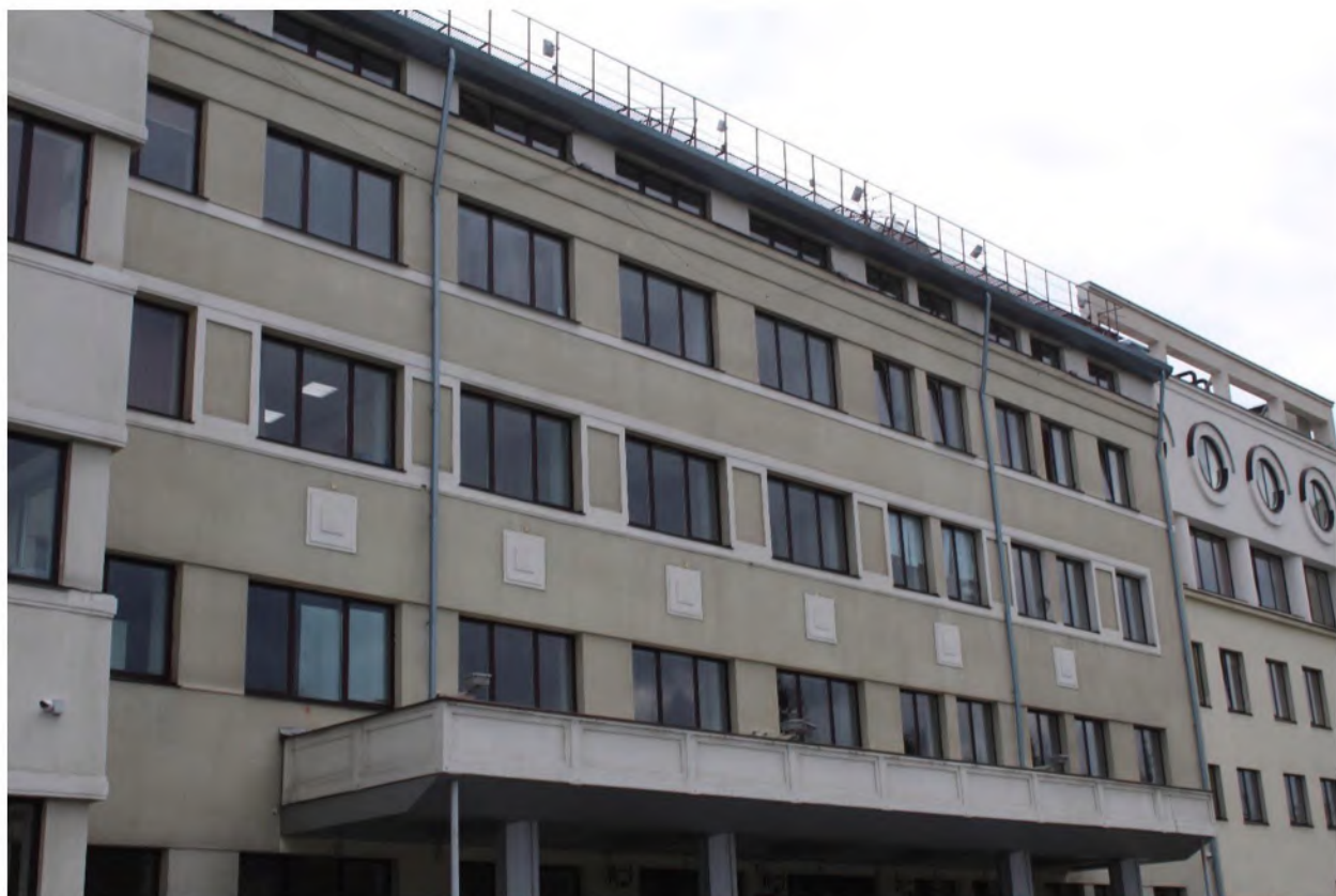
Фото 6. Фрагмент главного фасада восточного крыла.
