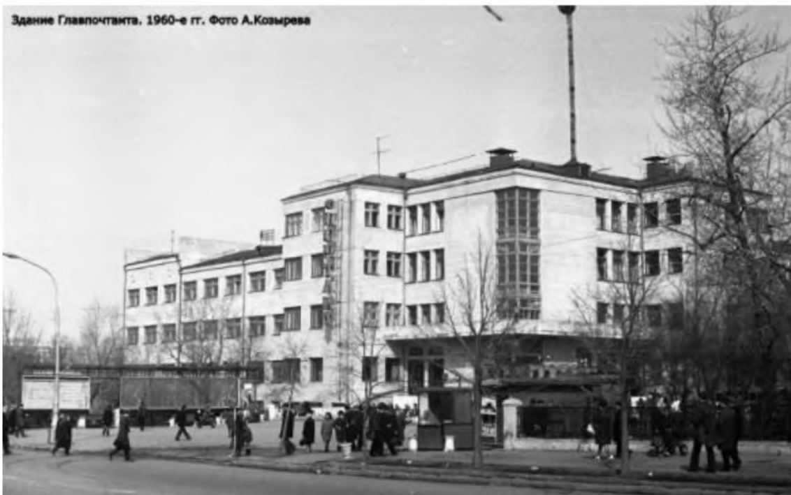
Илл.18. Здание почтамта в 1960-ы гг.
