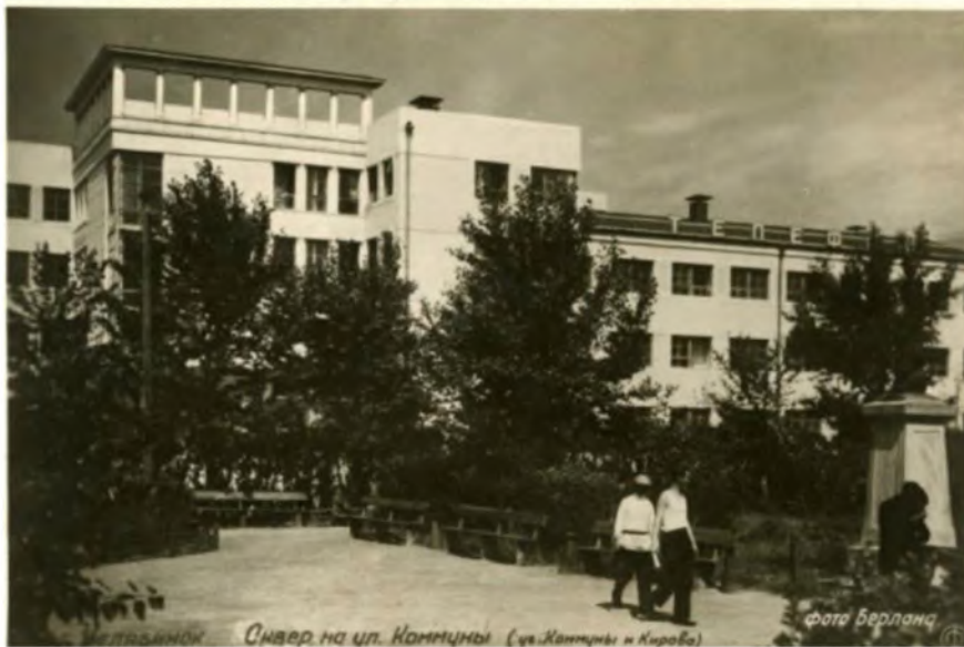
Илл.14. 1938г. Вид со стороны улицы Коммуны.
