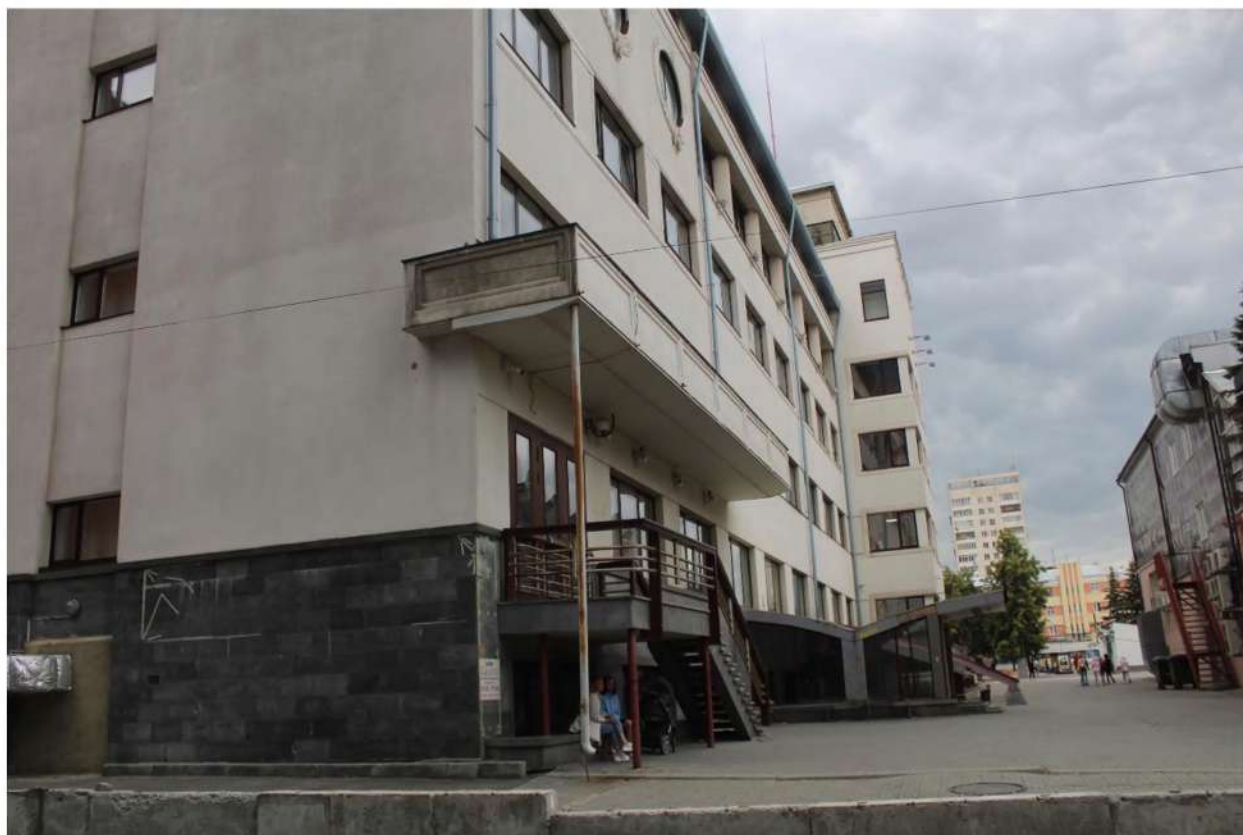
Фото 3. Торцевой фасад северного крыла.
