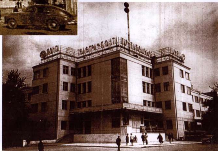
Вид на центральную часть здания главпочтамта. Фотография 1976г.
