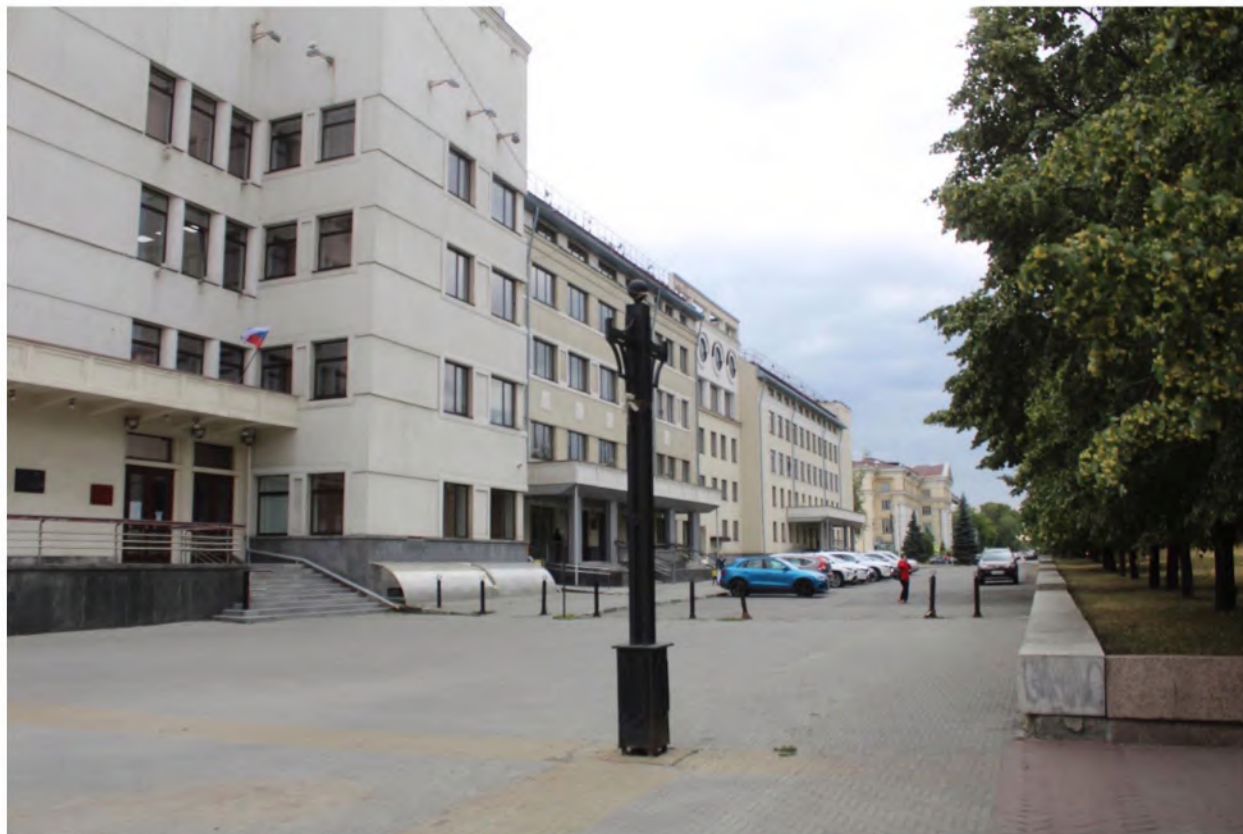
Фото 5. Общий вид восточного крыла здания (вид с ул. Коммуны).
