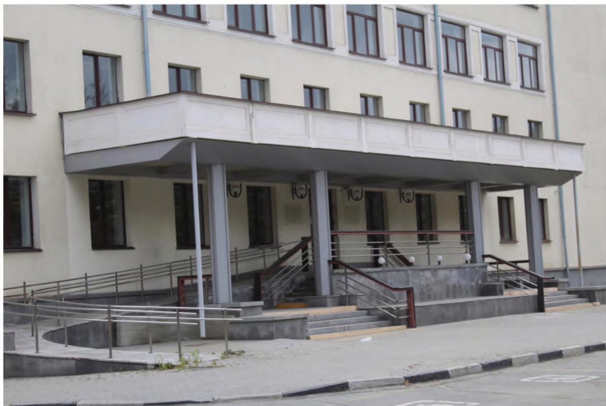
Фото 7. Входная группа восточного крыла здания.
