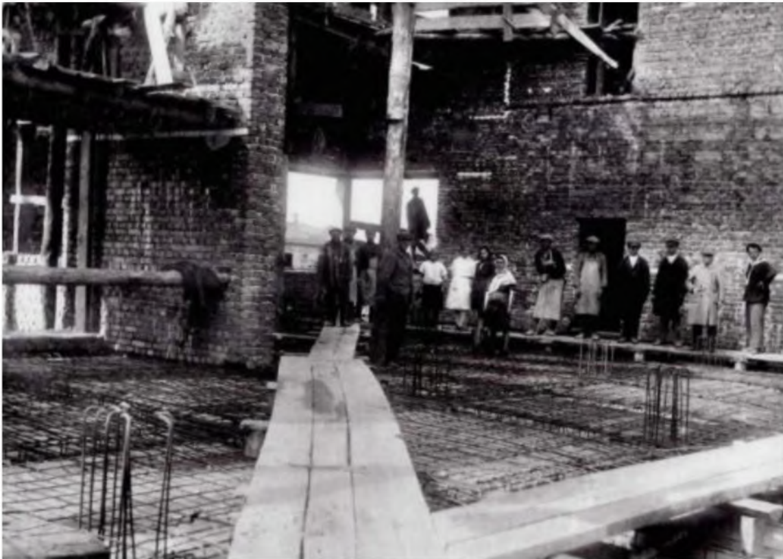
Илл. 9. Строительство здания главпочтамта в 1930-ых гг.; источник - https://arhistrzh.livejournal.com/204376.html .
