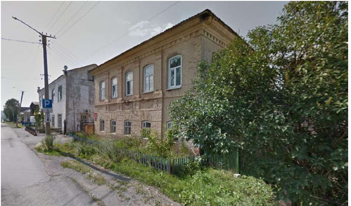
Фото 2. Вид на здание-памятник в застройке по ул.К.Маркса с востока. 06.07.2020г.
