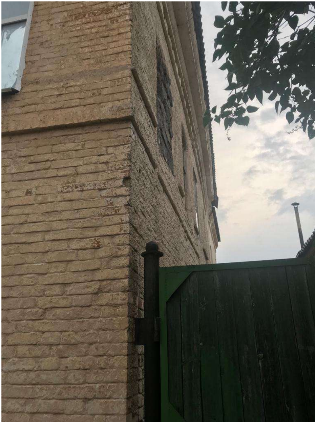
Фото 4. Дворовая территория. Северо-восточный фасад памятника. 06.07.2020г.
