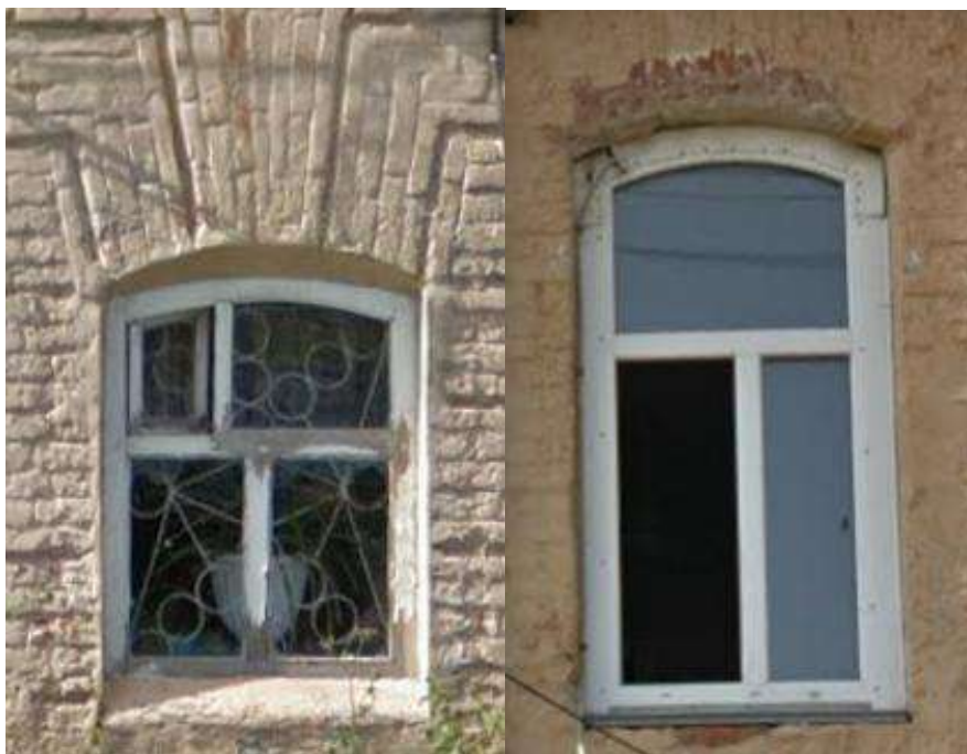
Фото 5. Оформление исторических оконных проемов и расстекловка новых оконных рам. 06.07.2020г.
