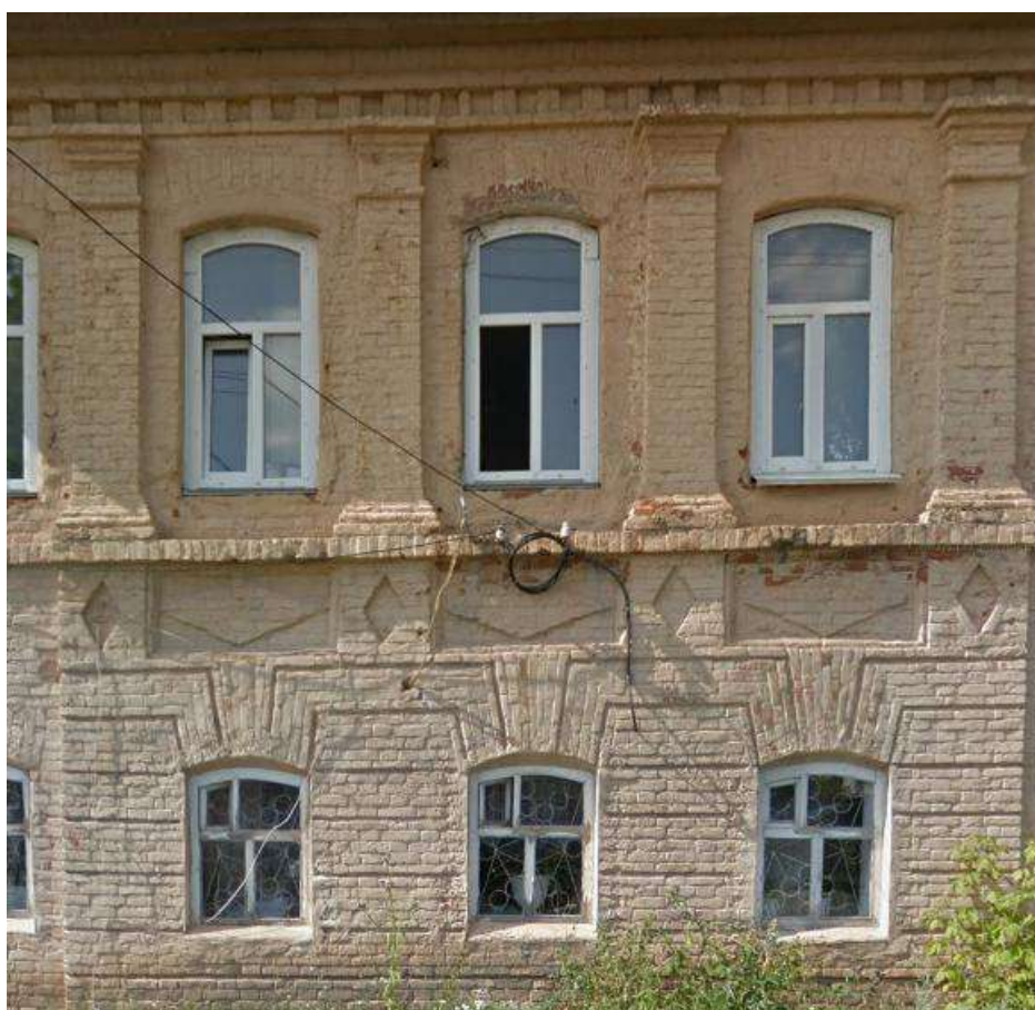
Фото 6. Фрагмент юго-восточного фасада, раскреповка центральной части. 06.07.2020г.
