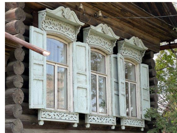
Оформление оконных проемов первого этажа восточного фасада
