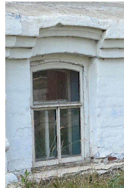
Оформление оконного проема цоколя восточного фасада
