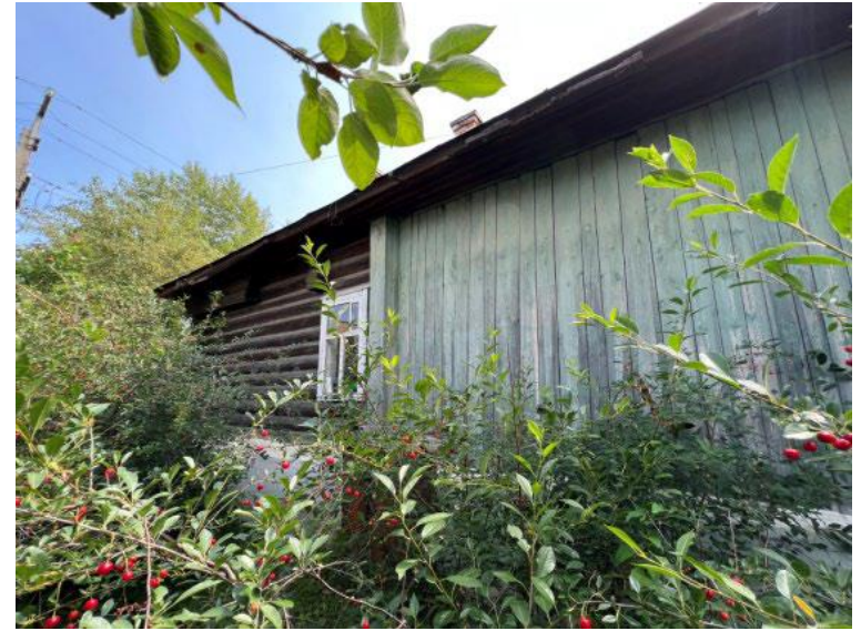
Северный фасад. Фрагмент
