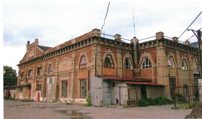
Главный и боковой, южный фасады. Вид с юго-запада
