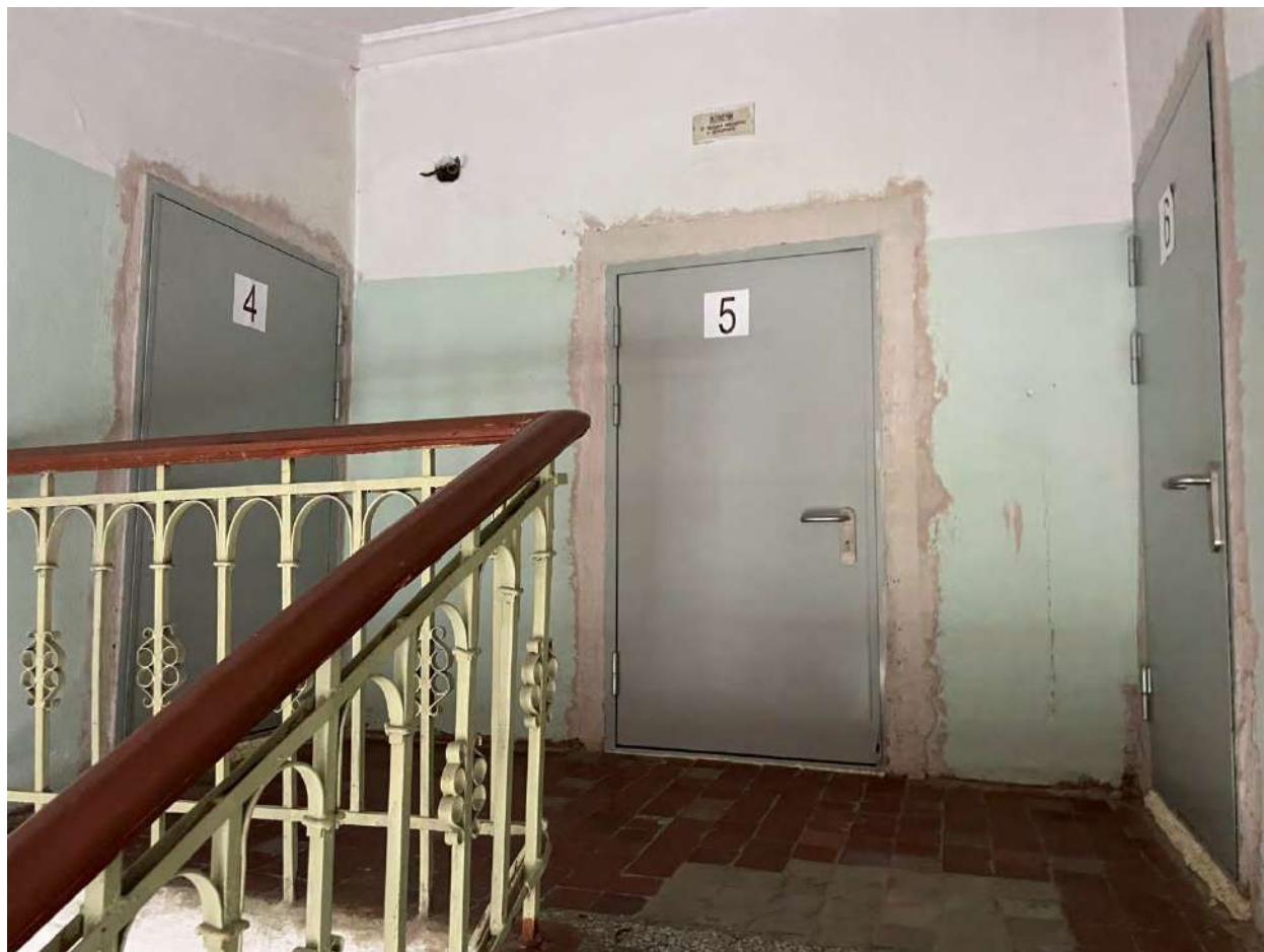
Фото 171. Выявленный объект культурного наследия «Дворец культуры «Энергетик», расположенный по адресу: Челябинская обл., г. Южноуральск, ул. Парковая, 2. Второй этаж. Помещение №48.
