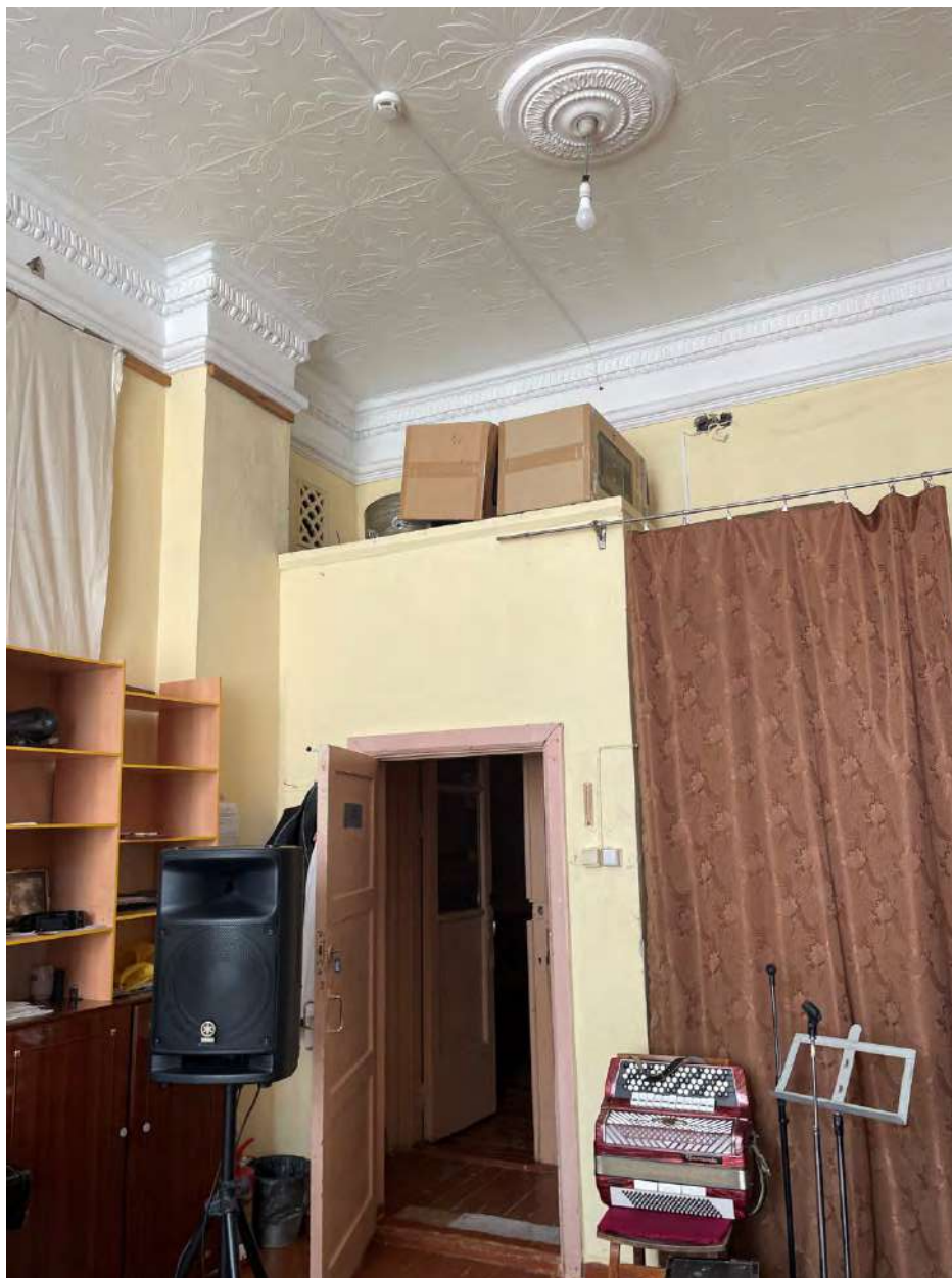
Фото 179. Выявленный объект культурного наследия «Дворец культуры «Энергетик», расположенный по адресу: Челябинская обл., г. Южноуральск, ул. Парковая, 2. Третий этаж. Помещение №50.
