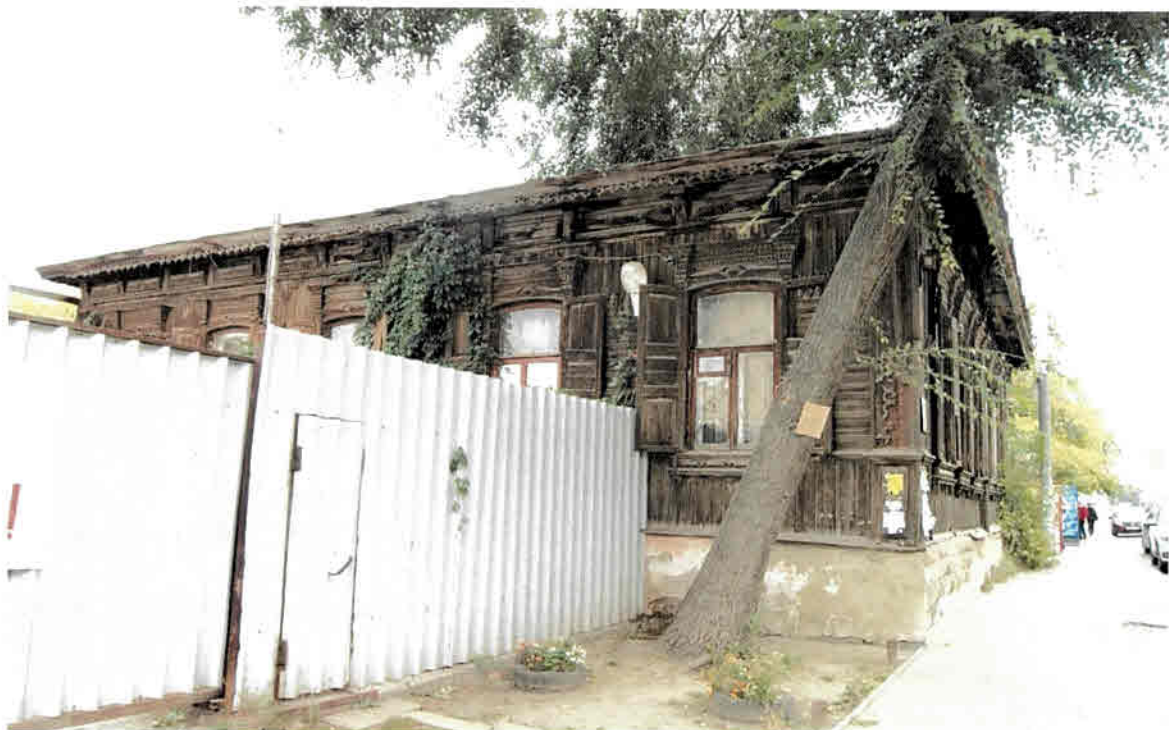
Фото 3. Вид на западный фасад с юго-западной стороны
