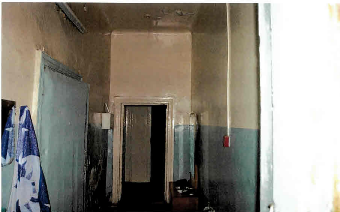
Фото 13. Фрагмент интерьера помещения № 1 (по техпаспорту БТИ)
