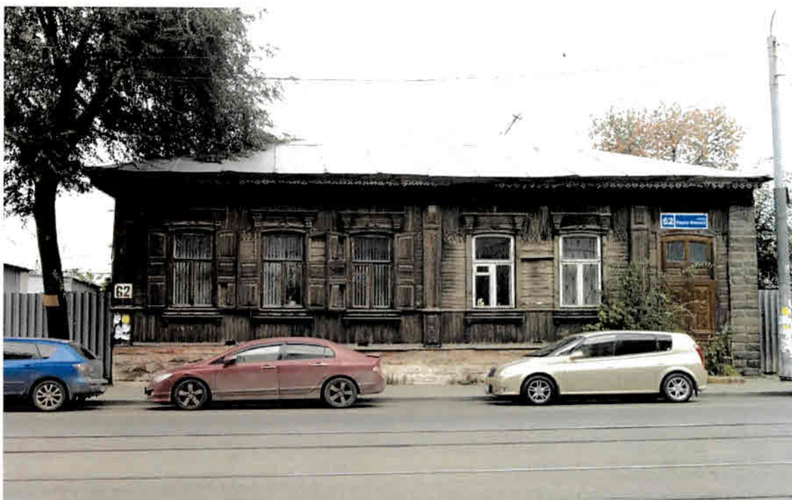
Фото 1. Вид на главный южный фасад здания
