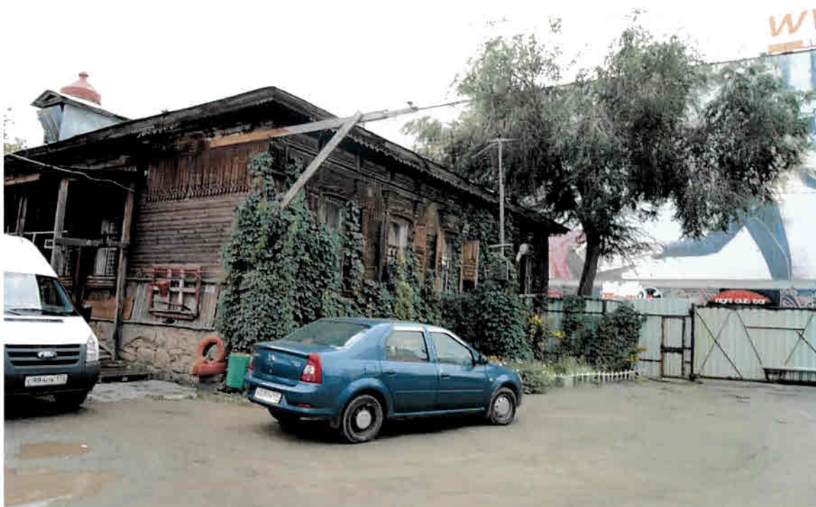
Фото 11. Вид на здание с северо-западной стороны
