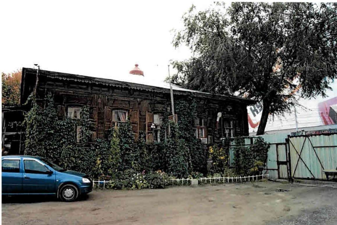
Фото 10. Вид на западный фасад
