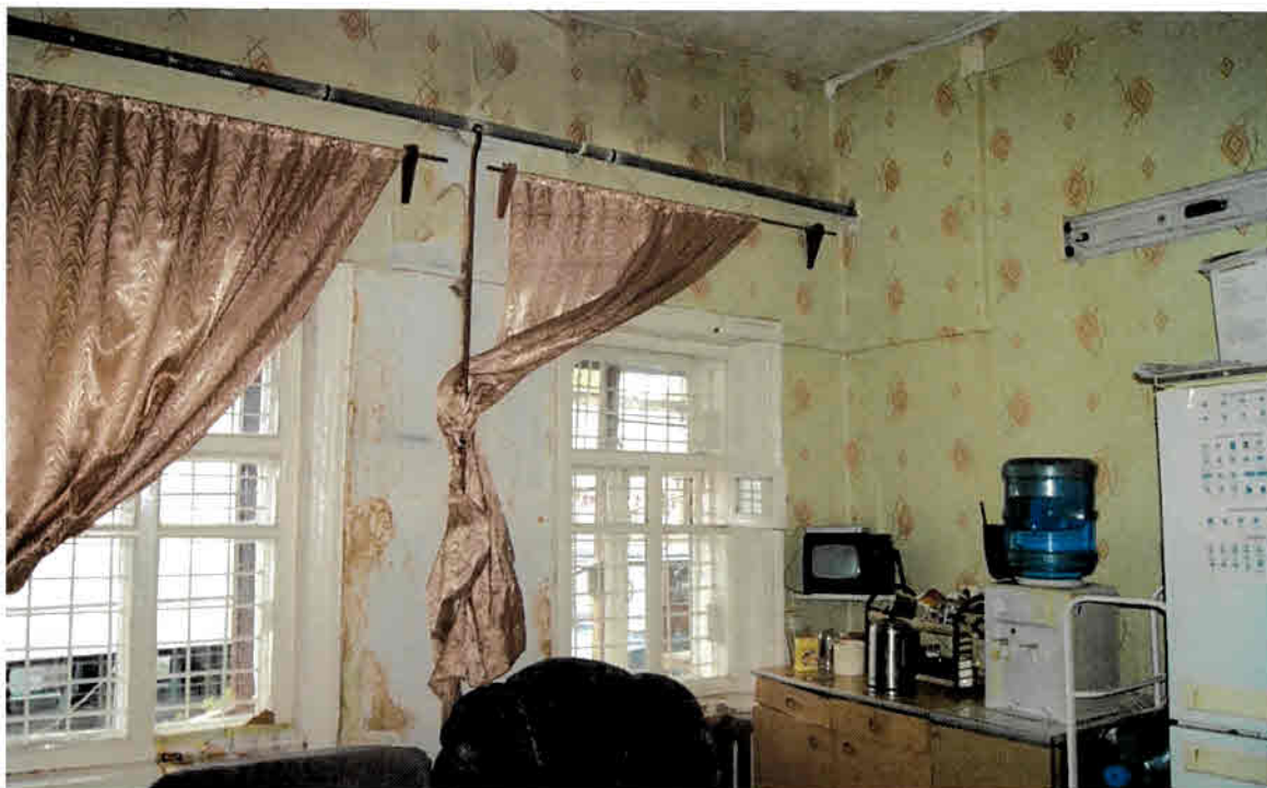
Фото 15. Фрагмент интерьера помещения № 2 (по техпаспорту БТИ)
