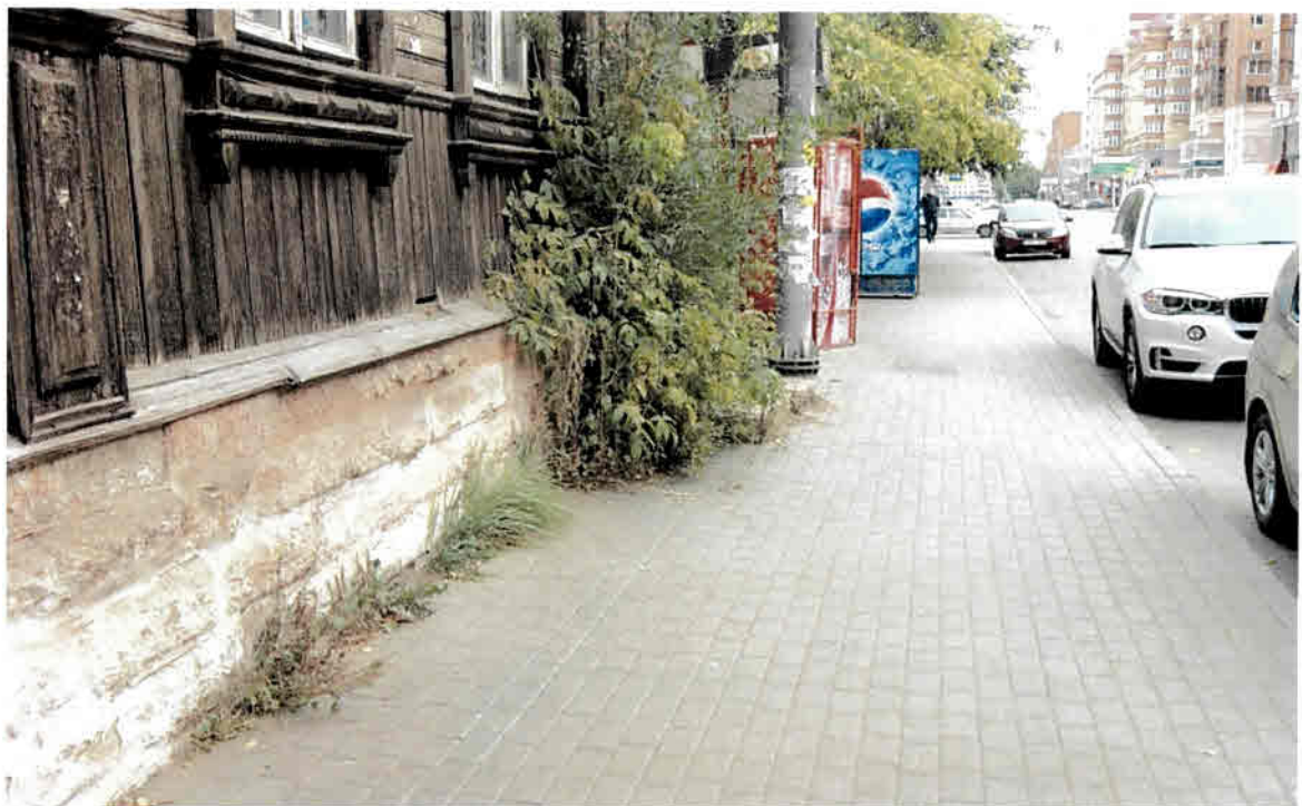
Фото 9. Фрагмент цокольной части главного фасада
