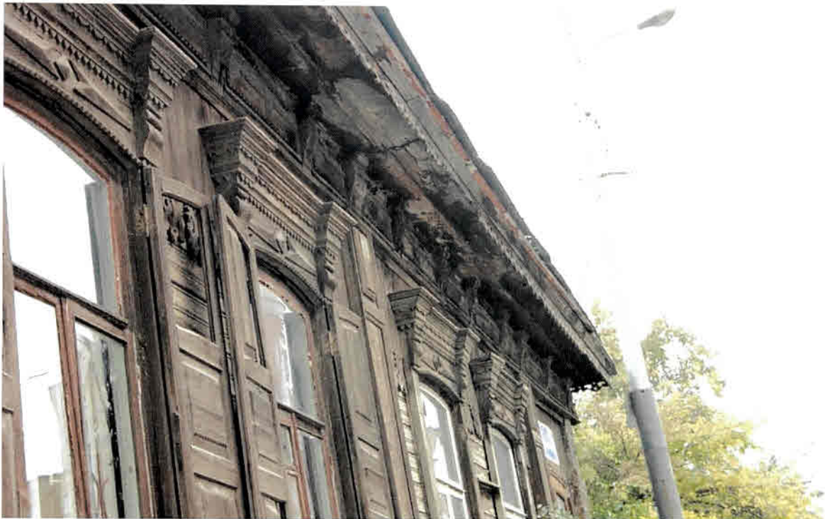
Фото 8. Фрагмент южного фасада
