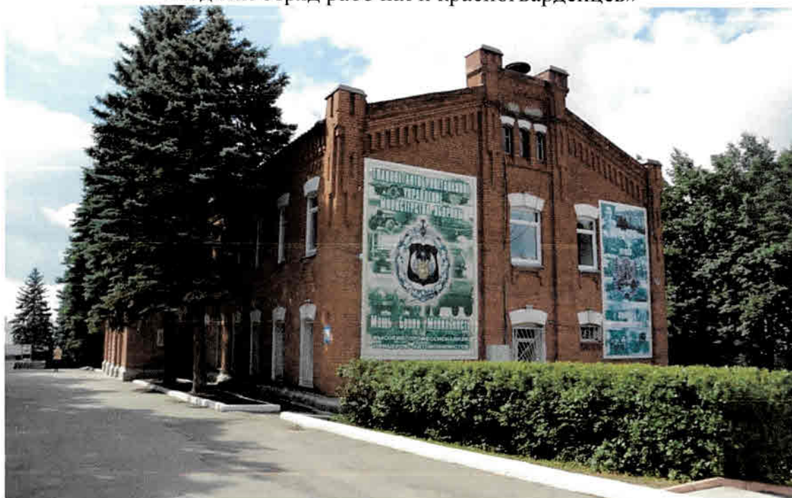
Фото 1. Вид на здание с северо-востока
