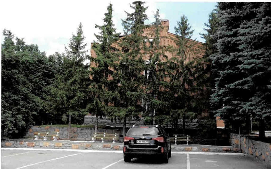
Фото 3. Вид на южный фасад здания
