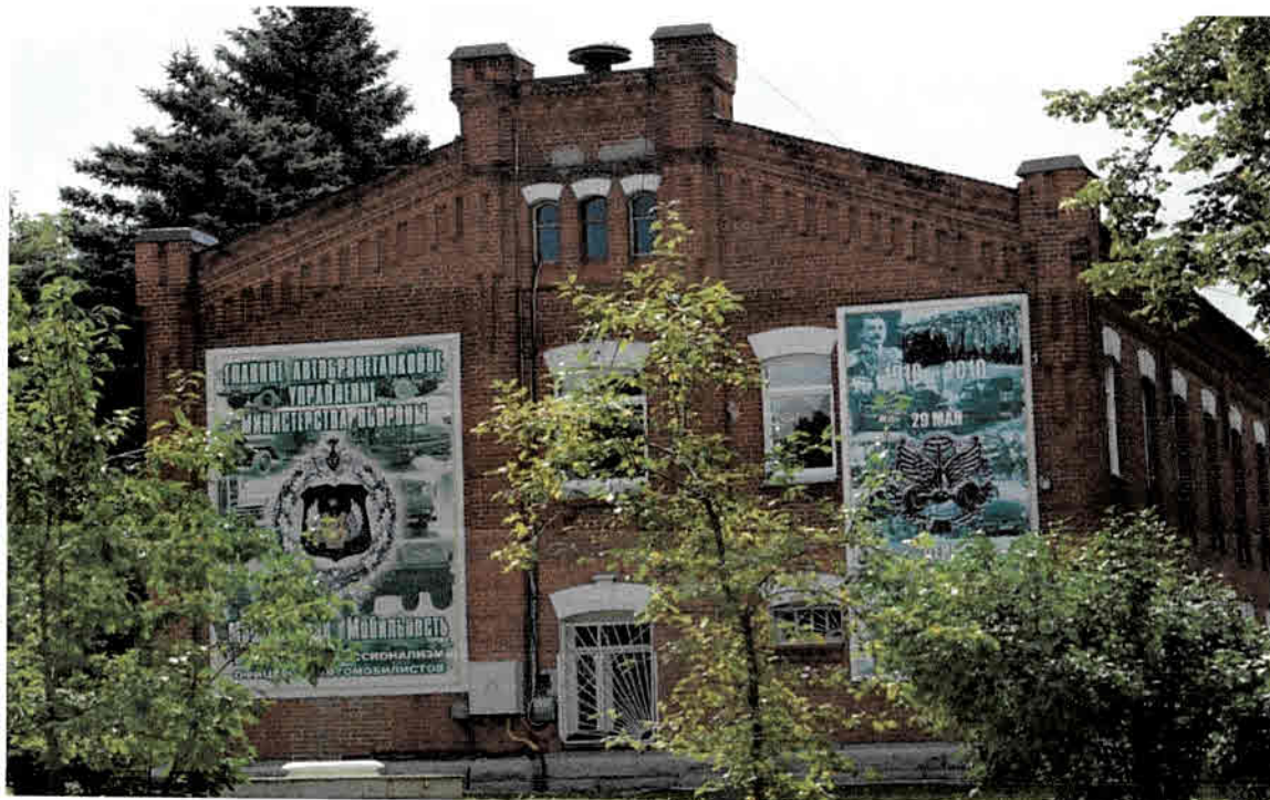
Фото 7. Вид на северный фасад здания
