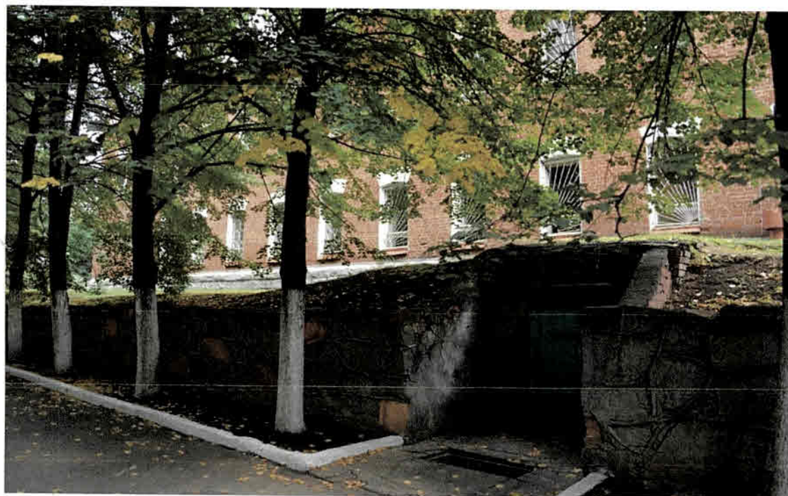
Фото 8. Фрагмент западного фасада здания.
