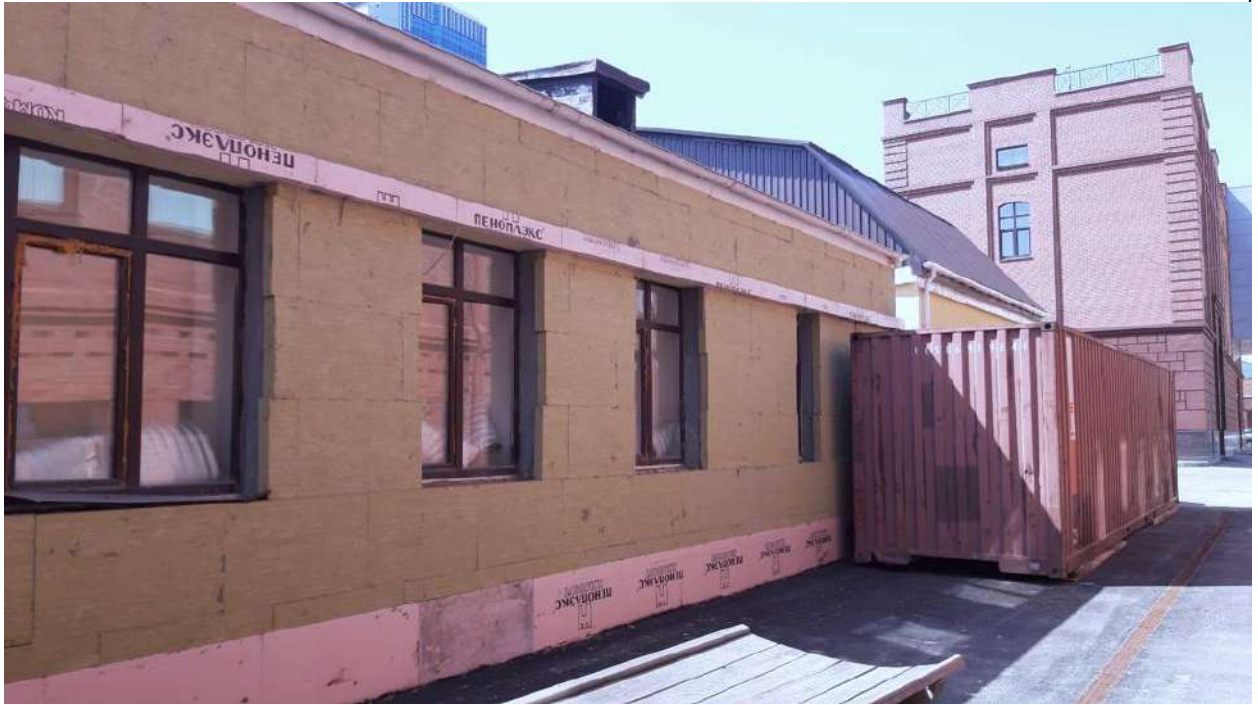
Илл 5. Вид на северный фасад со двора. Фото: июнь 2021 г.
