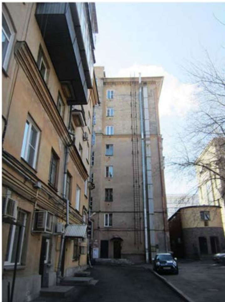
Рис. 12. Дворовой фасад, восьмиэтажная часть.
