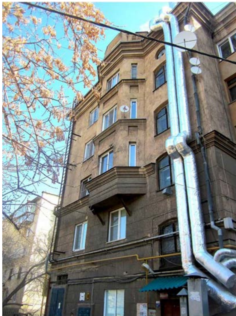
Рис. 11. Дворовой фасад пятиэтажная часть с эркером.
