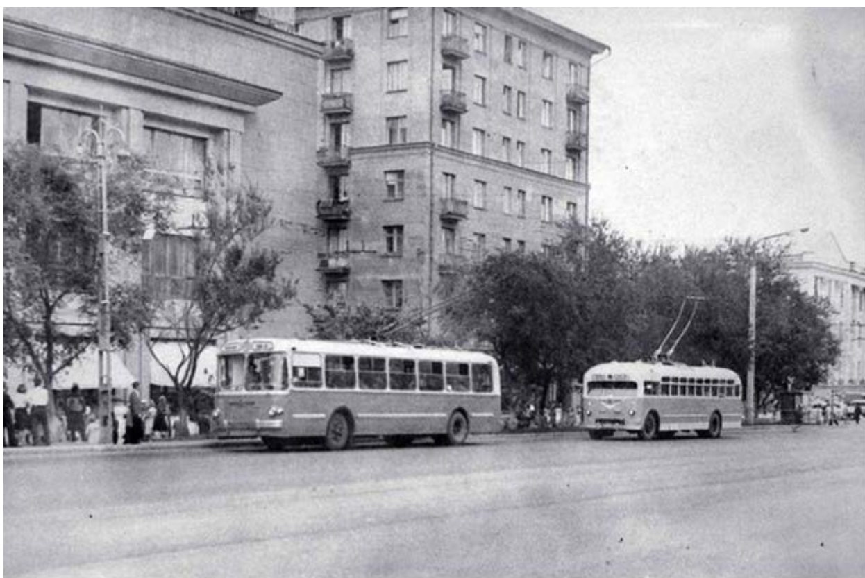
Рис. 3. Вид на дом по ул. Свободы 66, на заднем плане Трамвайные и троллейбусные сети.
