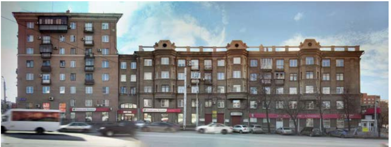
Рис. 8. Фасад здания по ул. Свободы (фотомонтаж).
