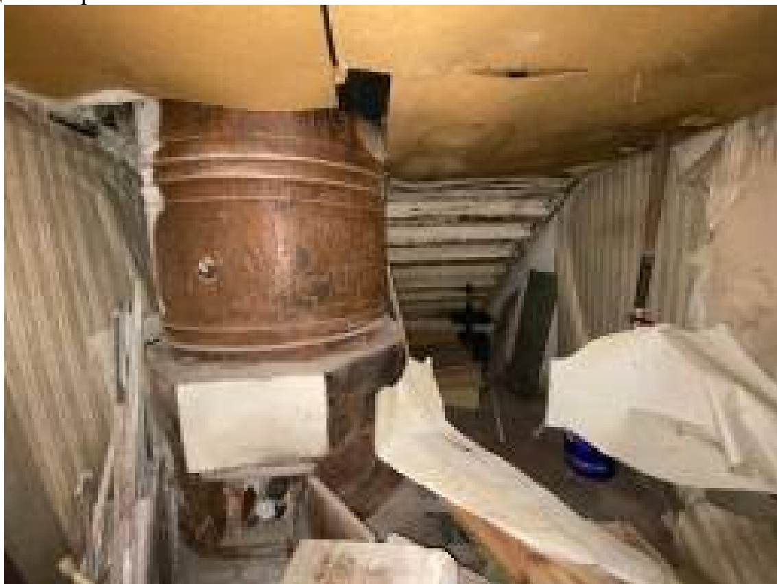
Приложение №8. «Дом купеческий Шарлова». Печь в подвале. Фото 2021 года. Автор неизвестен.
