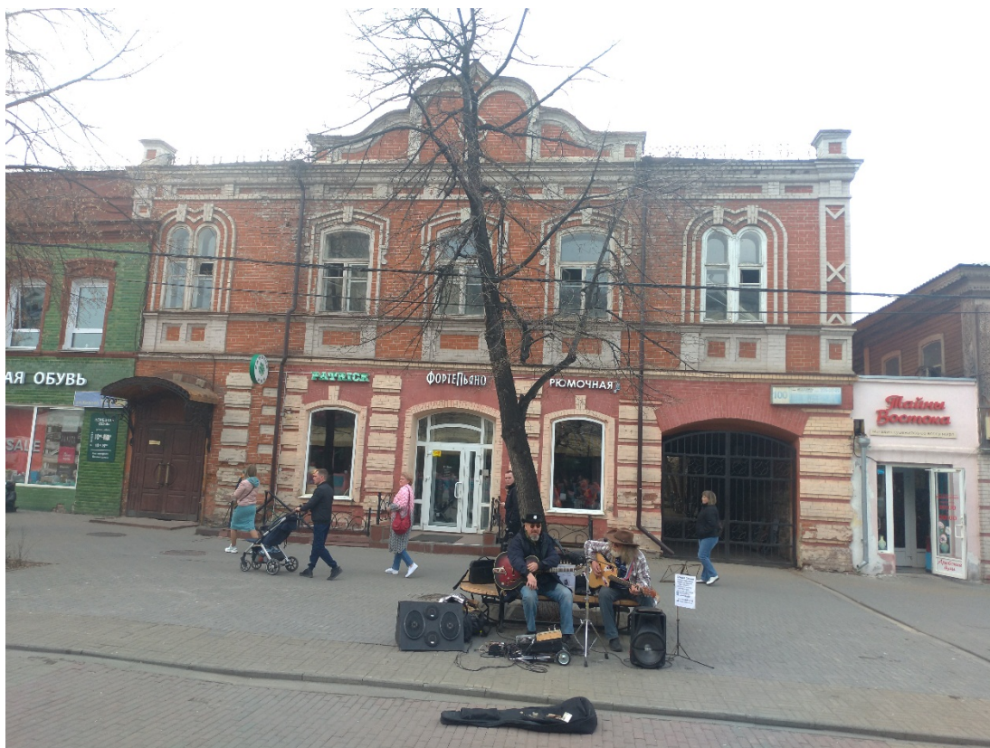
Приложение №9. «Дом купеческий Шарлова». Вид с северо-востока. Фото май 2022 года.
