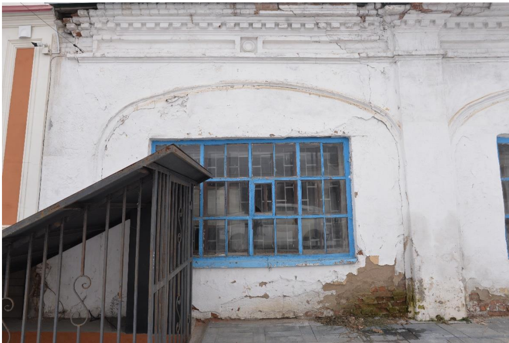
Фото 3. Вид на выявленный объект культурного наследия «Малые торговые ряды», расположенный по адресу: Троицкий городской округ, г. Троицк, ул. им. Степана Разина, 6
