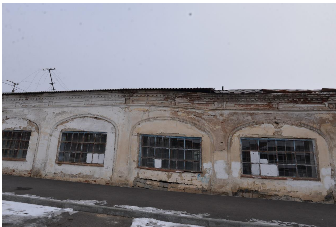
Фото 20. Вид на выявленный объект культурного наследия «Малые торговые ряды», расположенный по адресу: Троицкий городской округ, г. Троицк, ул. им. Степана Разина, 6
