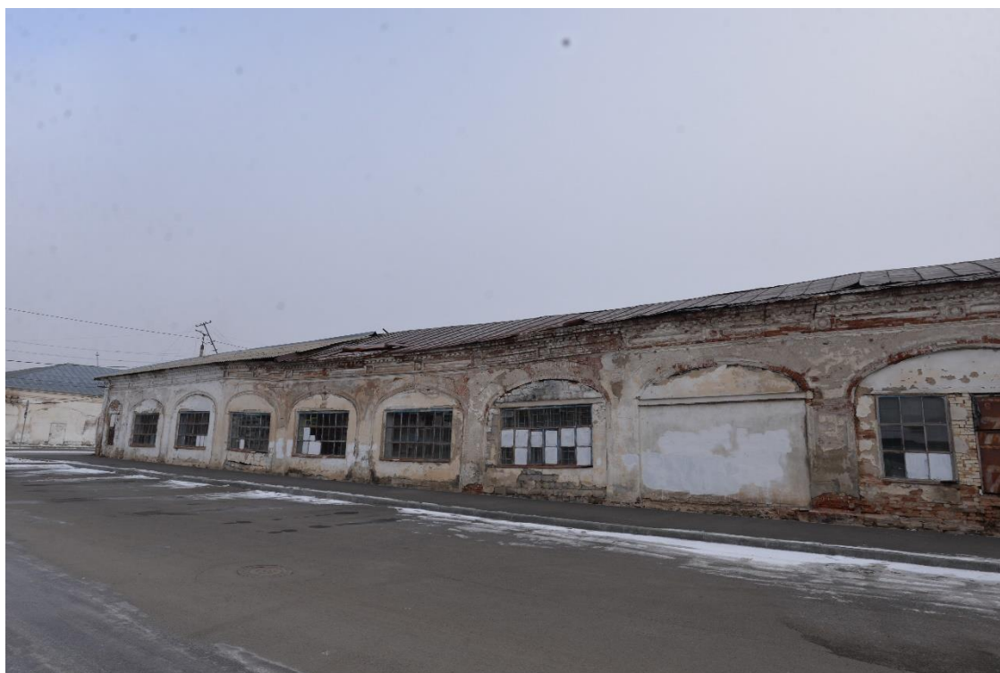
Фото 22. Вид на выявленный объект культурного наследия «Малые торговые ряды», расположенный по адресу: Троицкий городской округ, г. Троицк, ул. им. Степана Разина, 6
