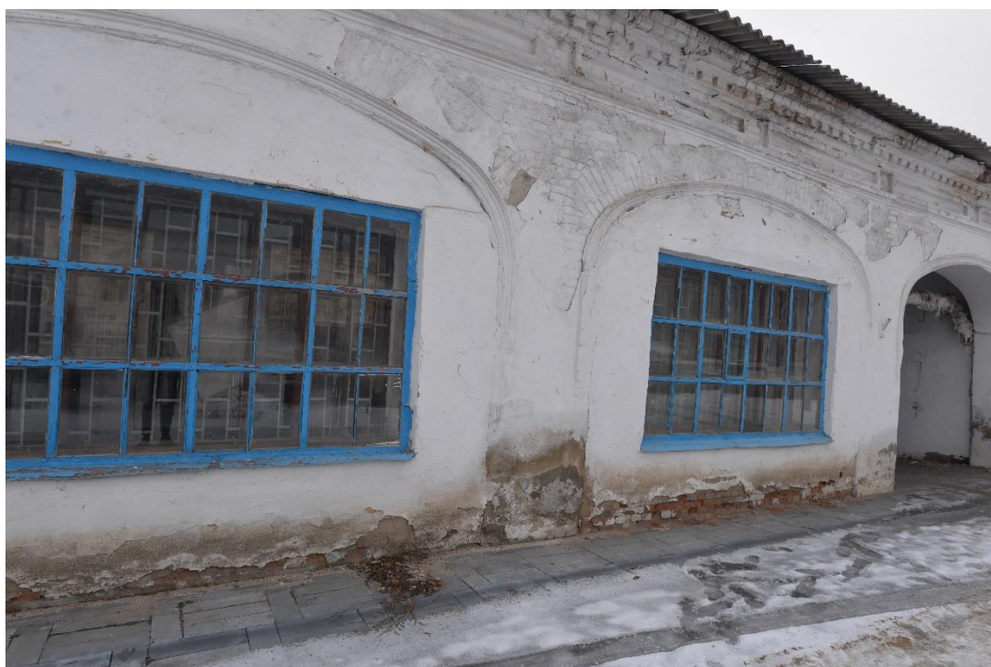
Фото 4. Вид на выявленный объект культурного наследия «Малые торговые ряды», расположенный по адресу: Троицкий городской округ, г. Троицк, ул. им. Степана Разина, 6
