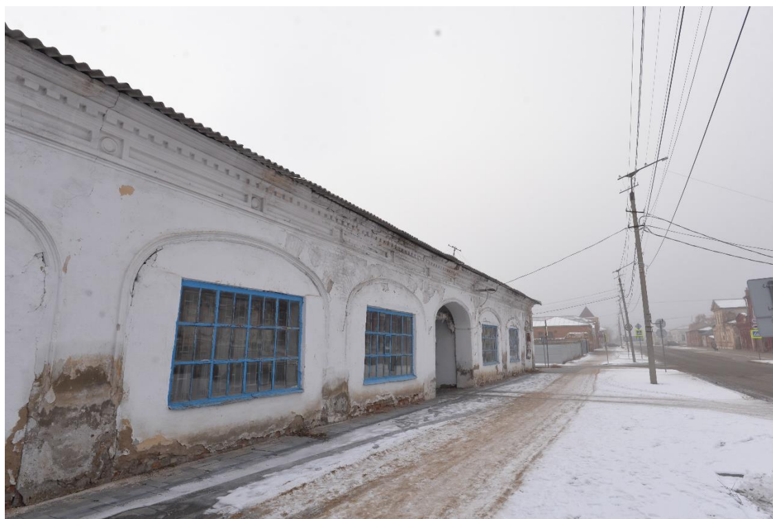
Фото 16. Вид на выявленный объект культурного наследия «Малые торговые ряды», расположенный по адресу: Троицкий городской округ, г. Троицк, ул. им. Степана Разина, 6
