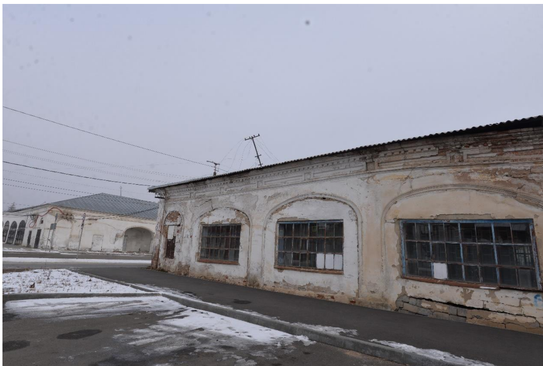
Фото 19. Вид на выявленный объект культурного наследия «Малые торговые ряды», расположенный по адресу: Троицкий городской округ, г. Троицк, ул. им. Степана Разина, 6
