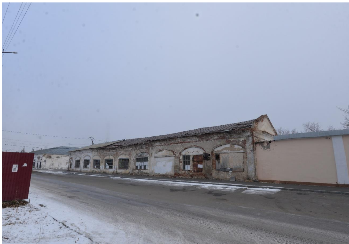
Фото 25. Вид на выявленный объект культурного наследия «Малые торговые ряды», расположенный по адресу: Троицкий городской округ, г. Троицк, ул. им. Степана Разина, 6
