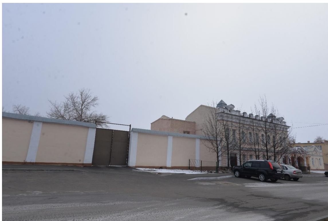
Фото 26. Вид на выявленный объект культурного наследия «Малые торговые ряды», расположенный по адресу: Троицкий городской округ, г. Троицк, ул. им. Степана Разина, 6
