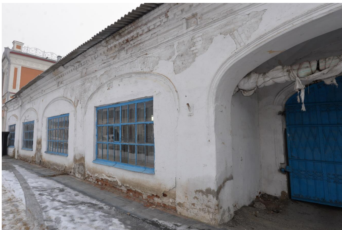
Фото 6. Вид на выявленный объект культурного наследия «Малые торговые ряды», расположенный по адресу: Троицкий городской округ, г. Троицк, ул. им. Степана Разина, 6
