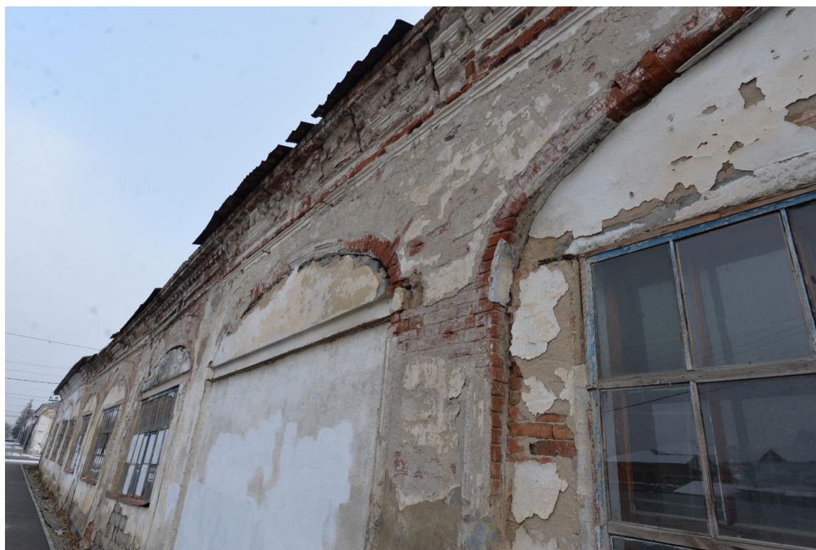
Фото 24. Вид на выявленный объект культурного наследия «Малые торговые ряды», расположенный по адресу: Троицкий городской округ, г. Троицк, ул. им. Степана Разина, 6
