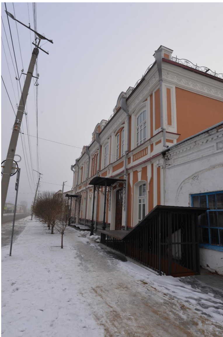
Фото 2. Вид на выявленный объект культурного наследия «Малые торговые ряды», расположенный по адресу: Троицкий городской округ, г. Троицк, ул. им. Степана Разина, 6
