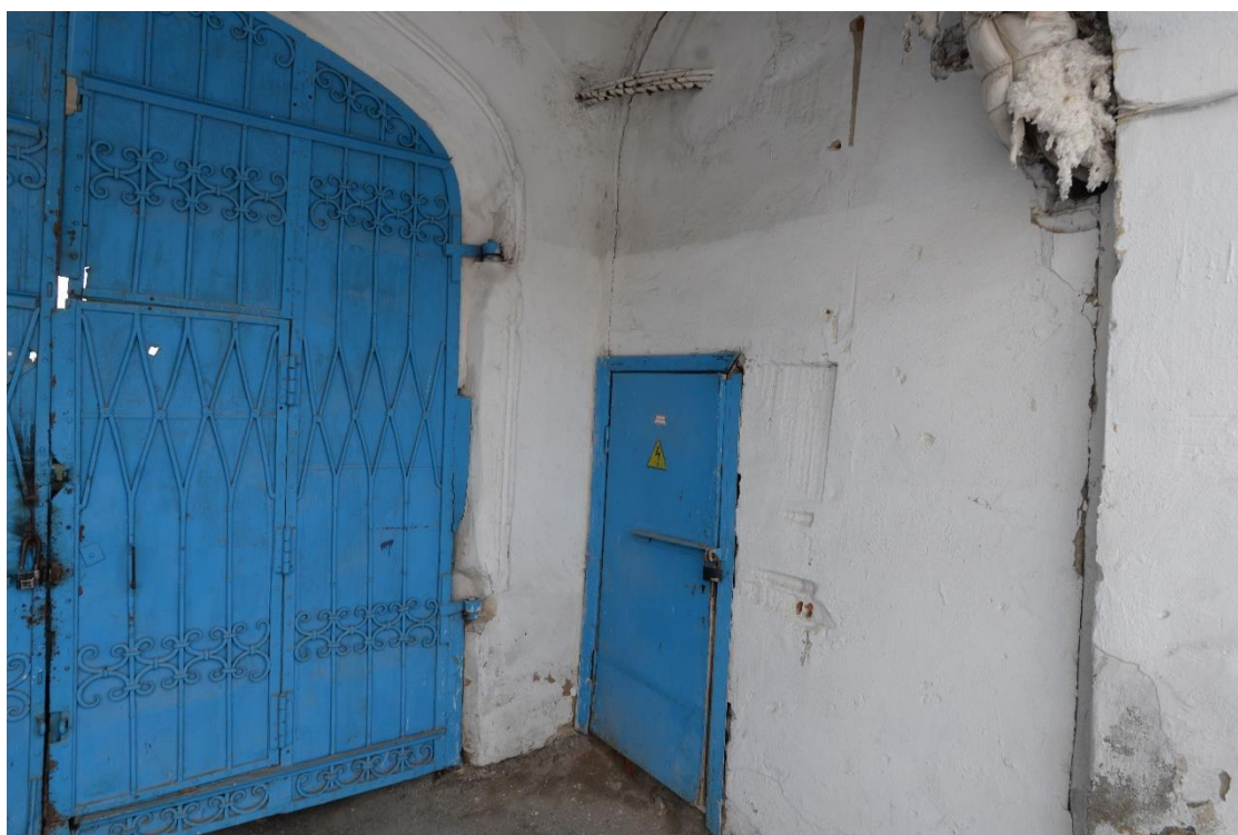
Фото 8. Вид на выявленный объект культурного наследия «Малые торговые ряды», расположенный по адресу: Троицкий городской округ, г. Троицк, ул. им. Степана Разина, 6
