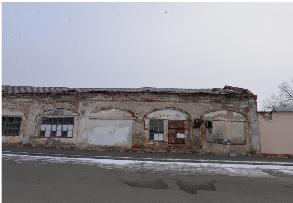
Фото 23. Вид на выявленный объект культурного наследия «Малые торговые ряды», расположенный по адресу: Троицкий городской округ, г. Троицк, ул. им. Степана Разина, 6
