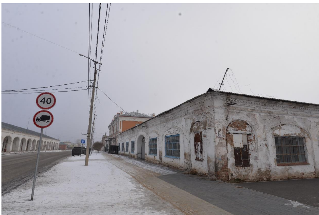
Фото 14. Вид на выявленный объект культурного наследия «Малые торговые ряды», расположенный по адресу: Троицкий городской округ, г. Троицк, ул. им. Степана Разина, 6
