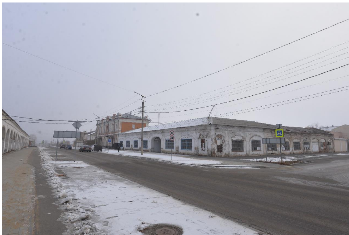
Фото 28. Вид на выявленный объект культурного наследия «Малые торговые ряды», расположенный по адресу: Троицкий городской округ, г. Троицк, ул. им. Степана Разина, 6
