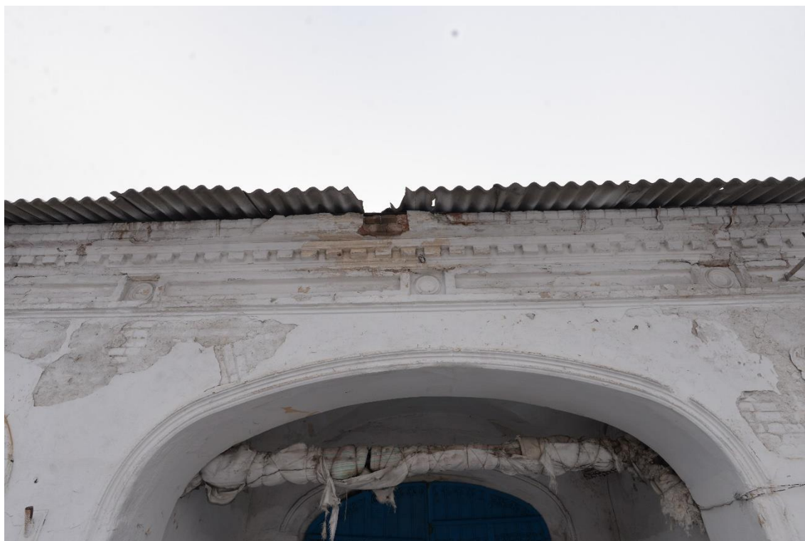
Фото 5. Вид на выявленный объект культурного наследия «Малые торговые ряды», расположенный по адресу: Троицкий городской округ, г. Троицк, ул. им. Степана Разина, 6
