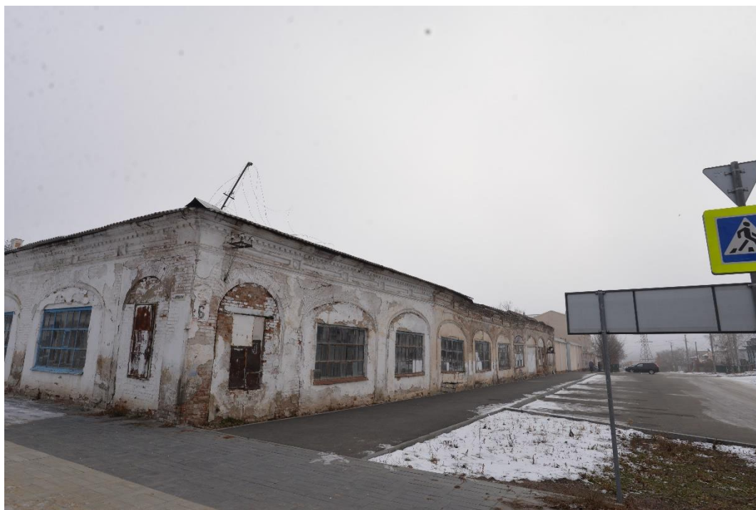
Фото 15. Вид на выявленный объект культурного наследия «Малые торговые ряды», расположенный по адресу: Троицкий городской округ, г. Троицк, ул. им. Степана Разина, 6
