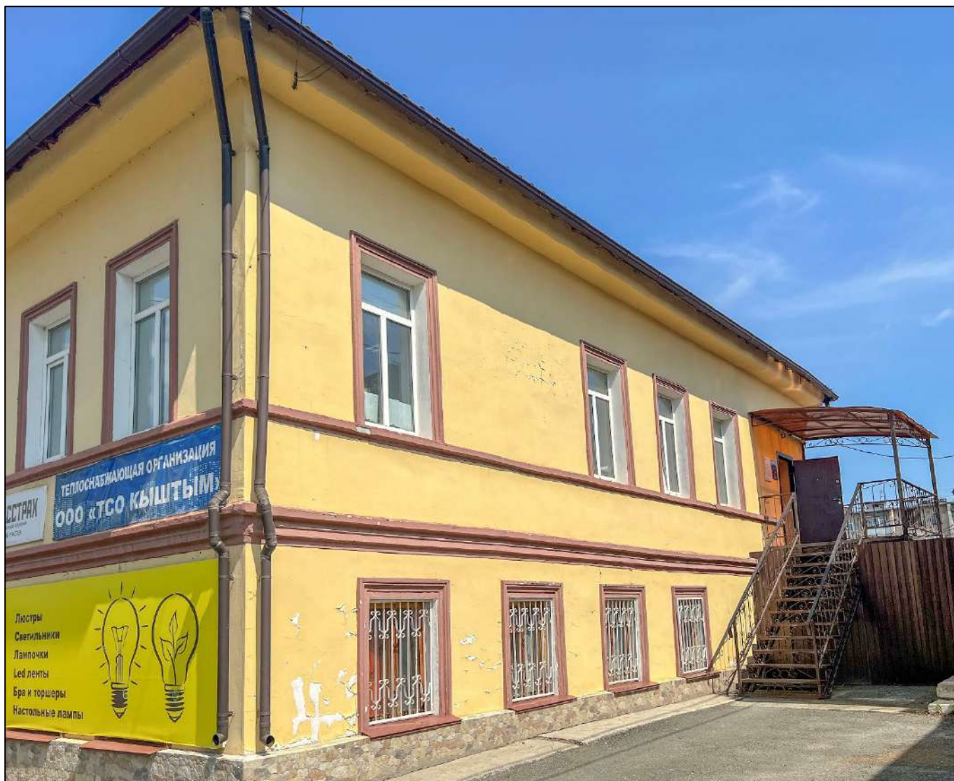
7. Фрагмент фасада Объекта.
