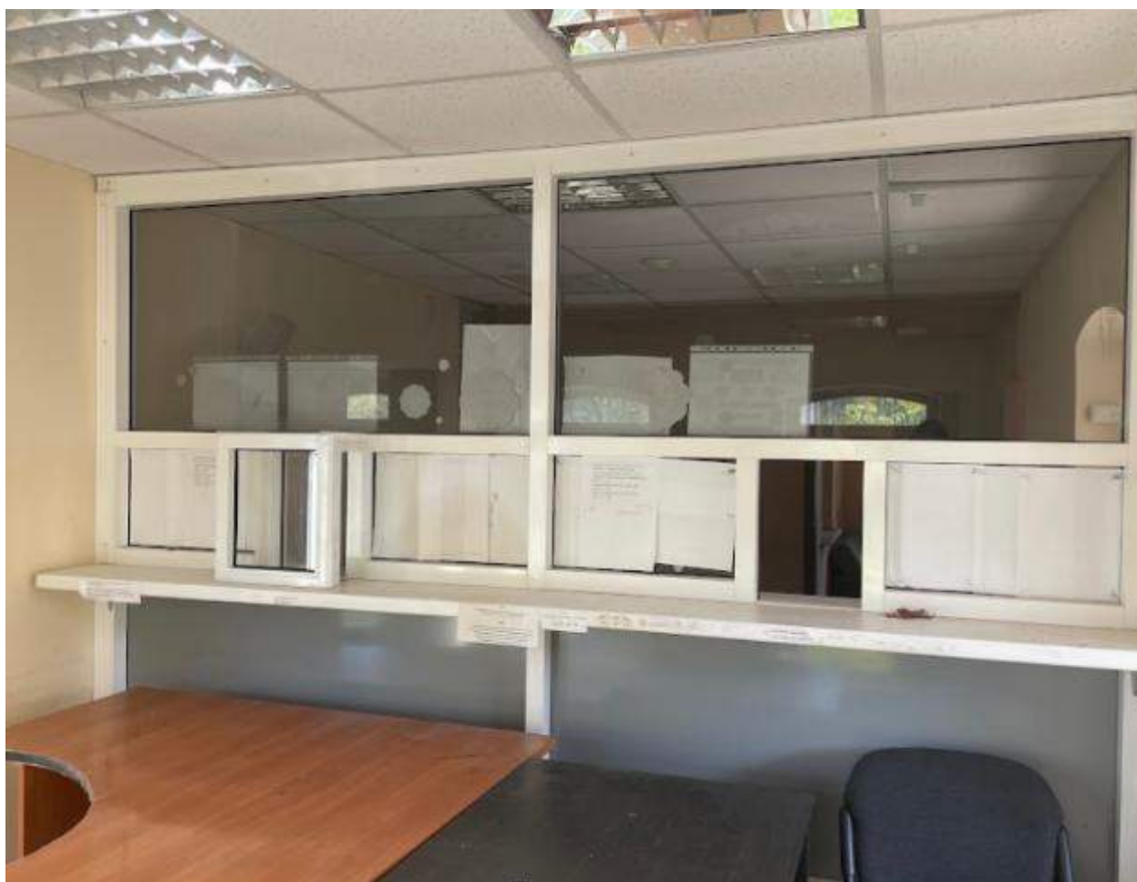
Фото 31. Выявленный объект культурного наследия «Дом купца А.Н. Якушева» по адресу: Челябинская обл., г. Верхний Уфалей, Каслинская ул., 1. Интерьер выявленного объекта культурного наследия. Помещение 3.
