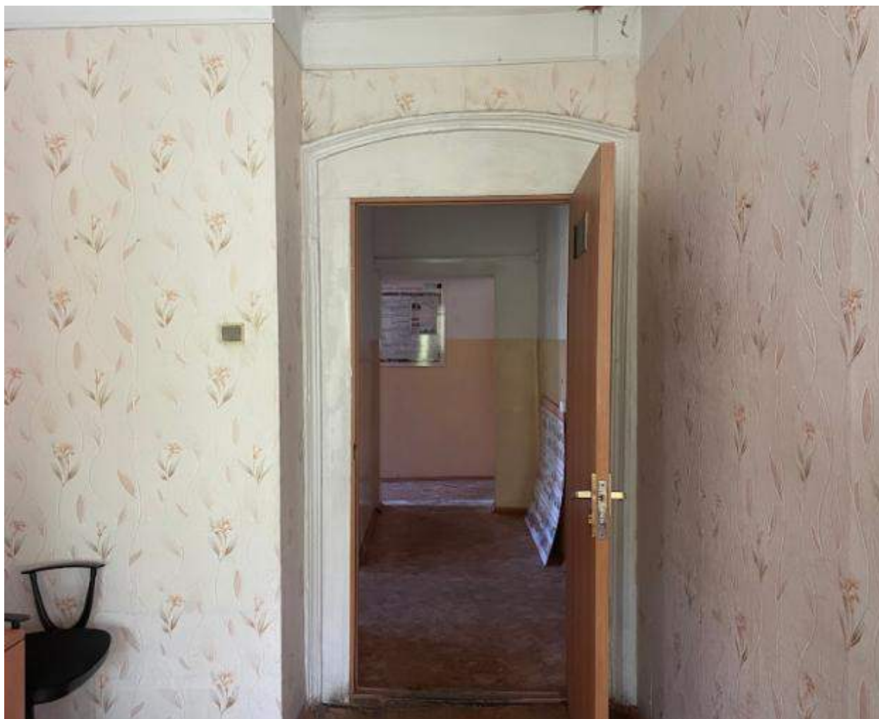
Фото 33. Выявленный объект культурного наследия «Дом купца А.Н. Якушева» по адресу: Челябинская обл., г. Верхний Уфалей, Каслинская ул., 1. Интерьер выявленного объекта культурного наследия. Помещение 3. Лучковые дверные проемы.
