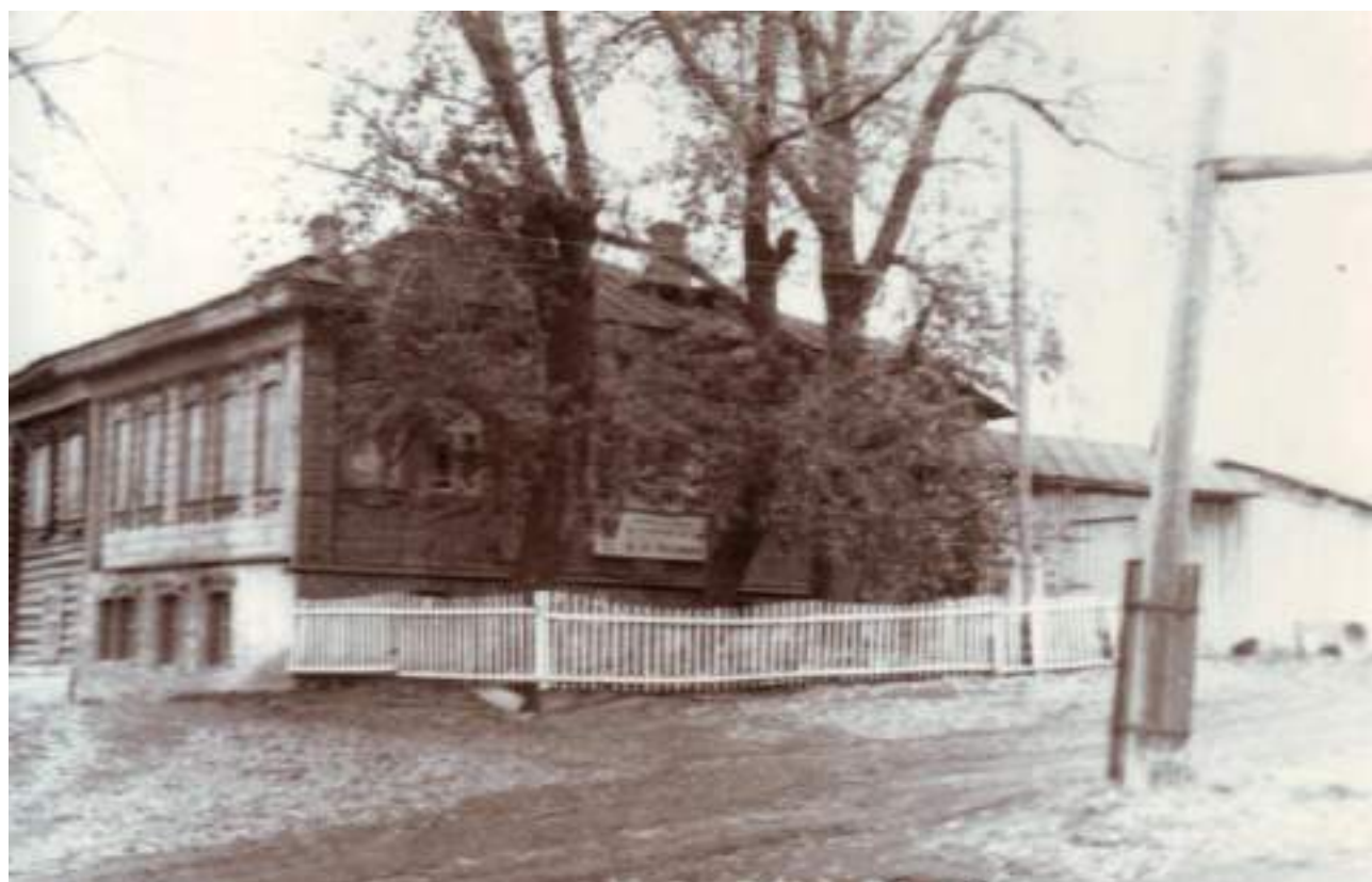
Рис.1. Историческая фотография объекта, 1975 г.
