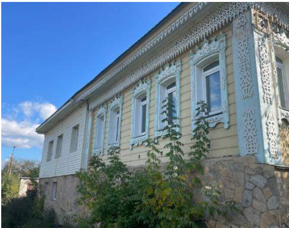
Фото 13. Выявленный объект культурного наследия «Дом купца А.Н. Якушева» по адресу: Челябинская обл., г. Верхний Уфалей, Каслинская ул., 1. Северный фасад выявленного объекта культурного наследия.
