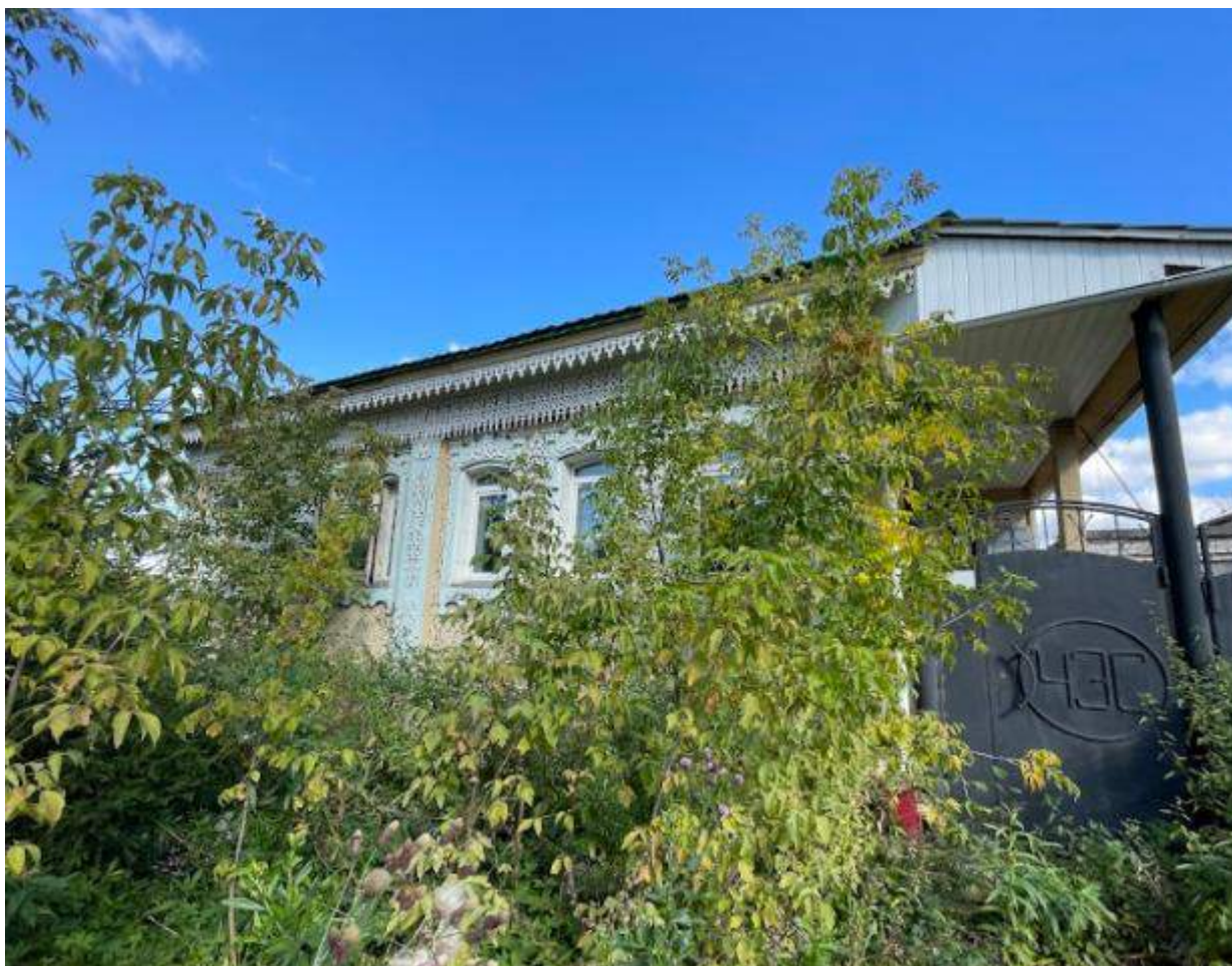
Фото 4. Выявленный объект культурного наследия «Дом купца А.Н. Якушева» по адресу: Челябинская обл., г. Верхний Уфалей, Каслинская ул., 1. Фрагмент западного фасада выявленного объекта культурного наследия.
