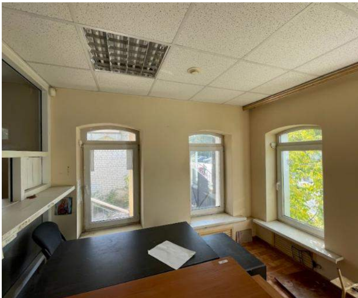
Фото 32. Выявленный объект культурного наследия «Дом купца А.Н. Якушева» по адресу: Челябинская обл., г. Верхний Уфалей, Каслинская ул., 1. Интерьер выявленного объекта культурного наследия. Помещение 3.
