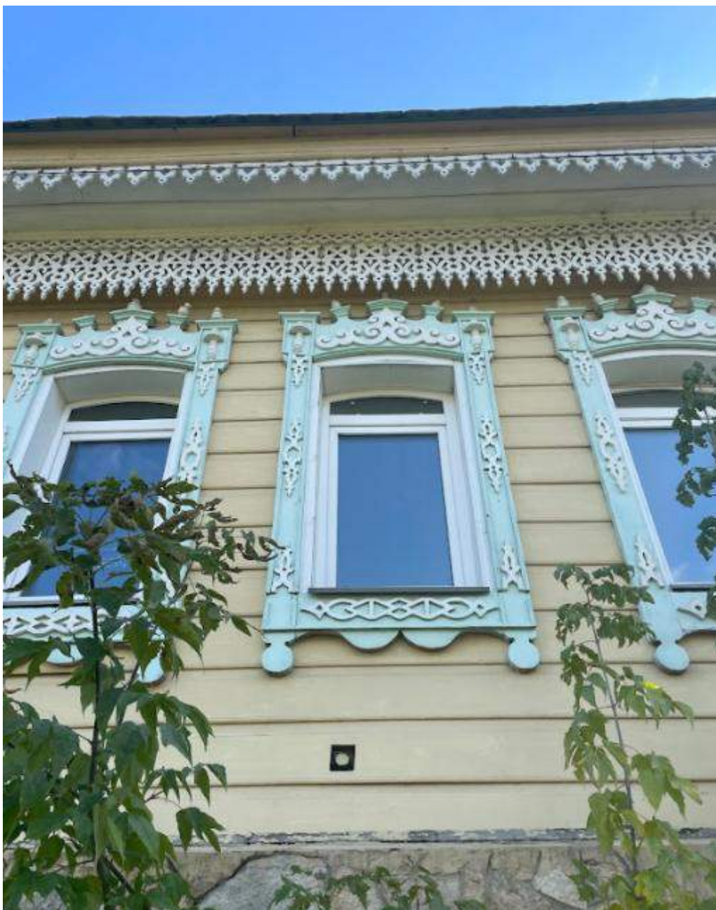
Фото 14. Выявленный объект культурного наследия «Дом купца А.Н. Якушева» по адресу: Челябинская обл., г. Верхний Уфалей, Каслинская ул., 1. Фрагмент северного фасада выявленного объекта культурного наследия.
