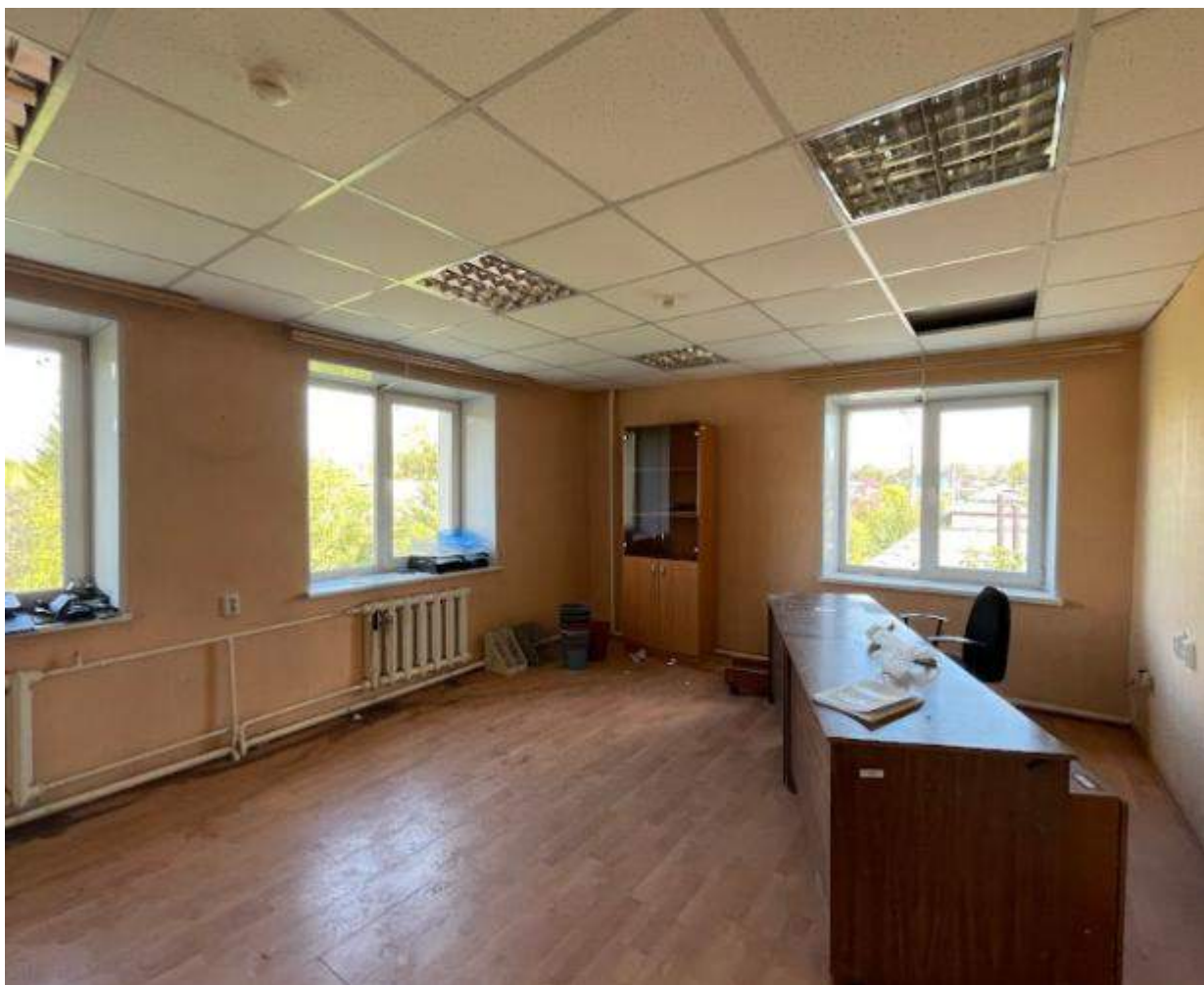
Фото 38. Выявленный объект культурного наследия «Дом купца А.Н. Якушева» по адресу: Челябинская обл., г. Верхний Уфалей, Каслинская ул., 1. Интерьер выявленного объекта культурного наследия. Помещение 6.
