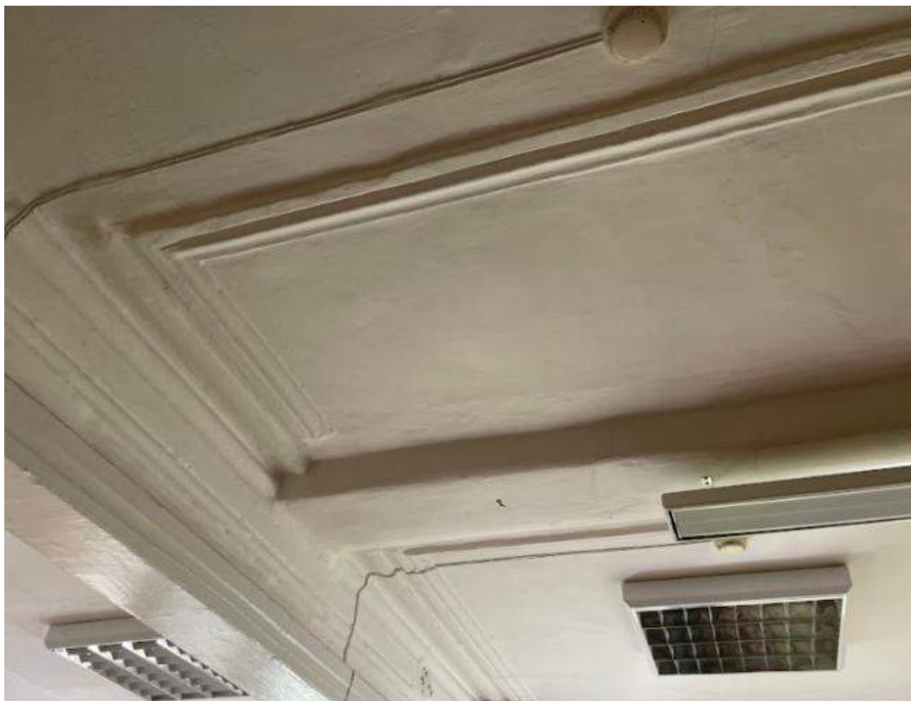
Фото 26. Выявленный объект культурного наследия «Дом купца А.Н. Якушева» по адресу: Челябинская обл., г. Верхний Уфалей, Каслинская ул., 1. Интерьер выявленного объекта культурного наследия. Помещение 3. Лепной тянутый декор.
