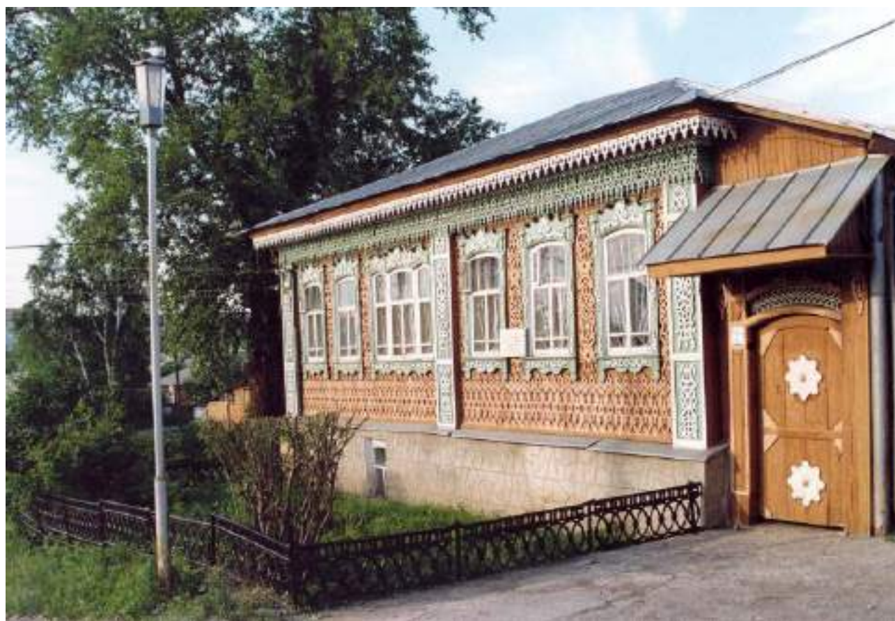
Рис.5. Историческая фотография объекта, 1993 г.
