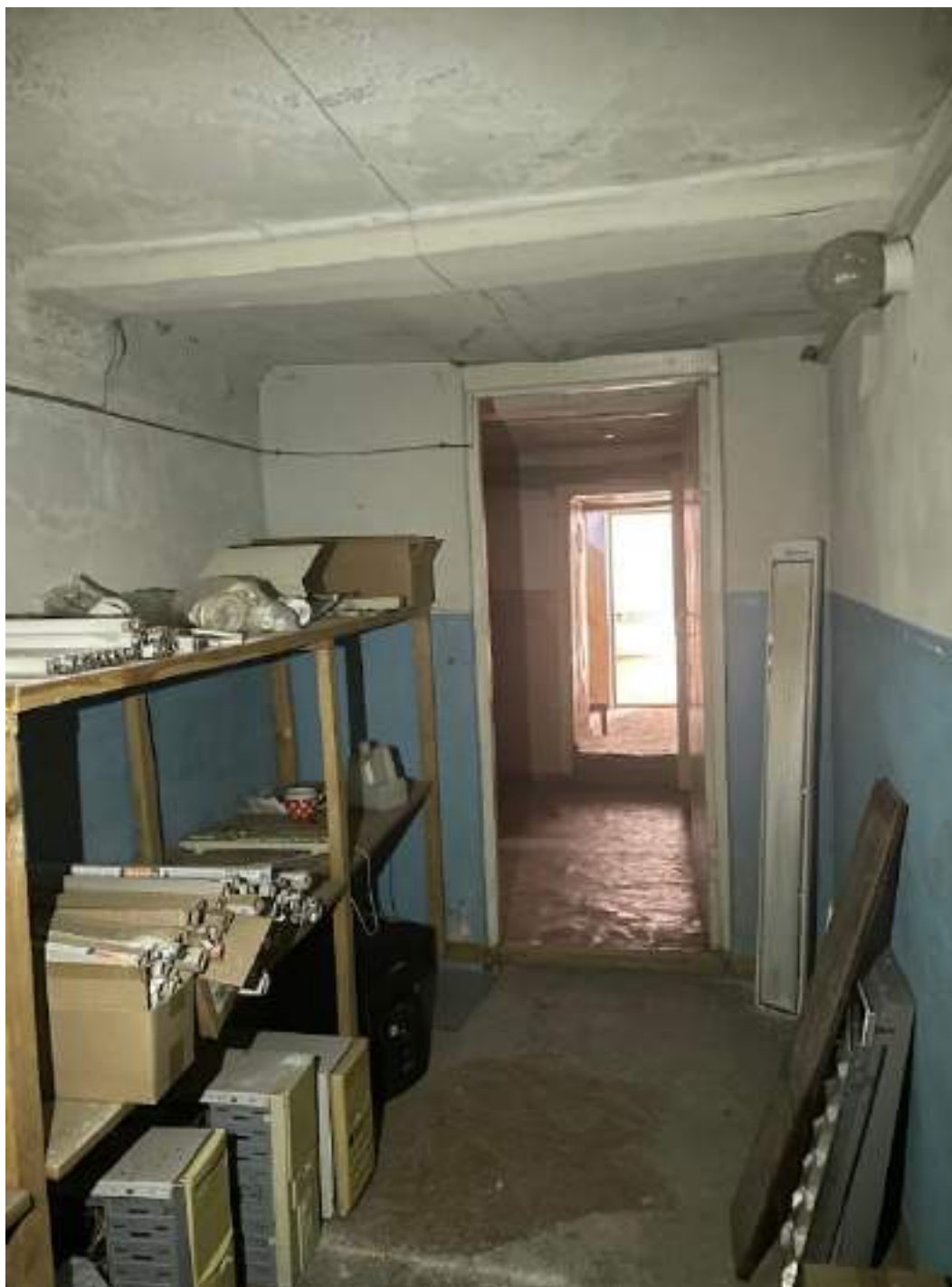
Фото 44. Выявленный объект культурного наследия «Дом купца А.Н. Якушева» по адресу: Челябинская обл., г. Верхний Уфалей, Каслинская ул., 1. Интерьер выявленного объекта культурного наследия. Помещение 8. Цокольный этаж.
