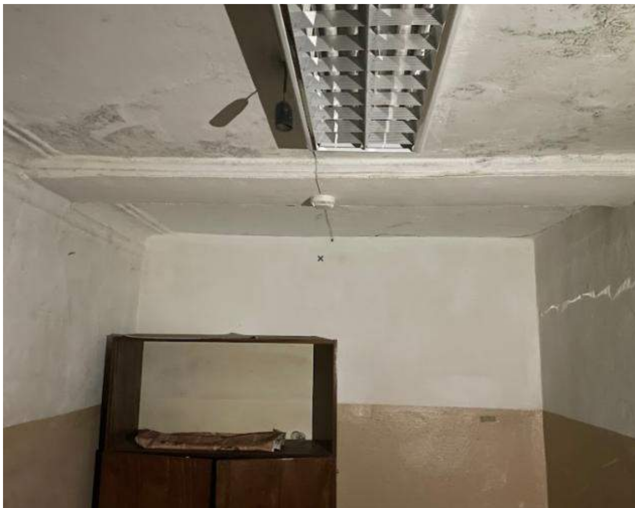
Фото 43. Выявленный объект культурного наследия «Дом купца А.Н. Якушева» по адресу: Челябинская обл., г. Верхний Уфалей, Каслинская ул., 1. Интерьер выявленного объекта культурного наследия. Помещение 8. Цокольный этаж. Лепной тянутый декор.
