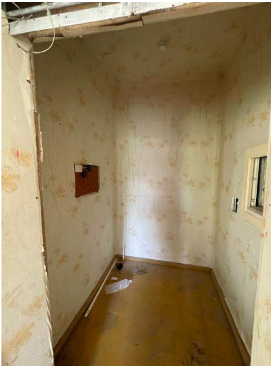
Фото 30. Выявленный объект культурного наследия «Дом купца А.Н. Якушева» по адресу: Челябинская обл., г. Верхний Уфалей, Каслинская ул., 1. Интерьер выявленного объекта культурного наследия. Помещение 3.
