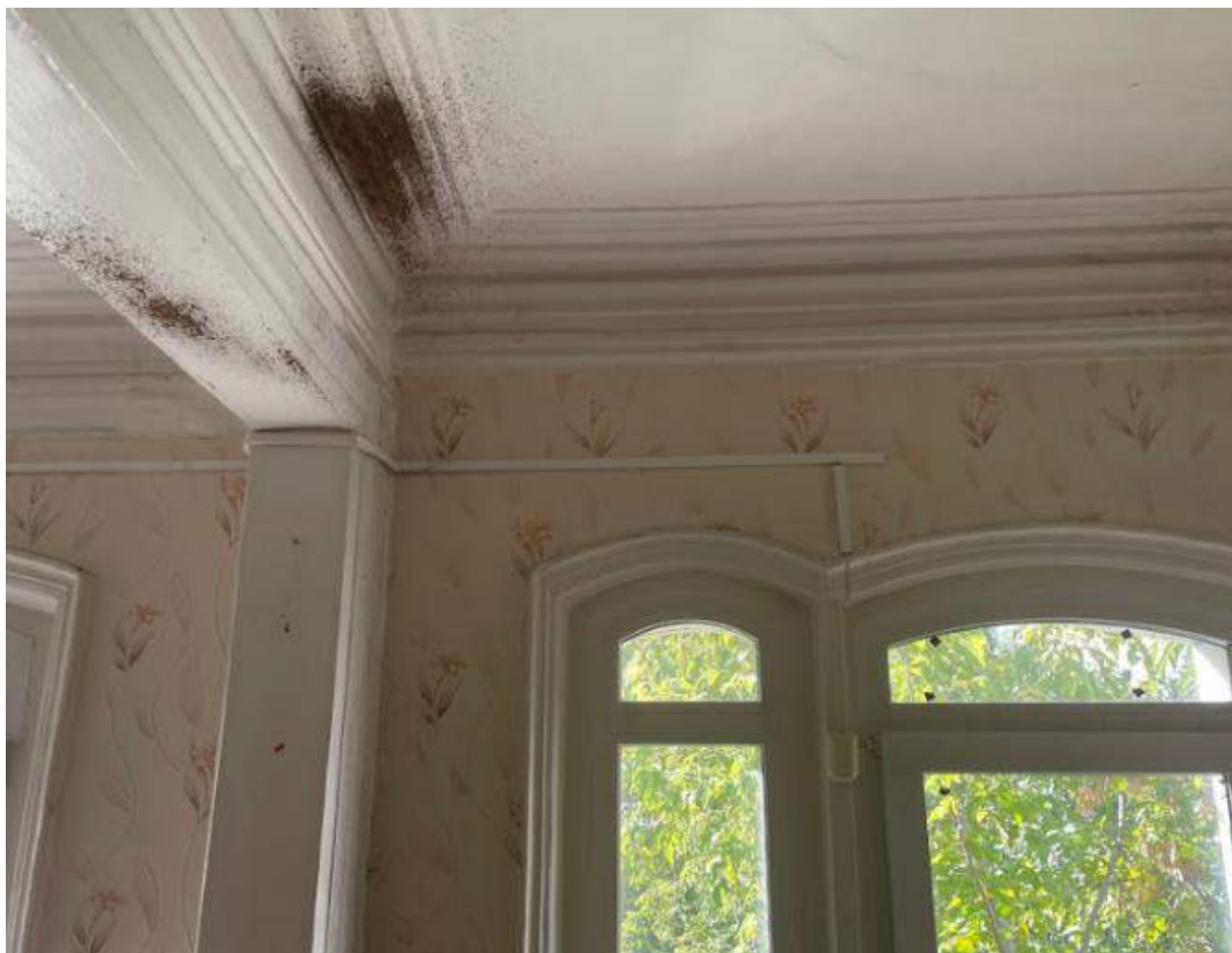
Фото 28. Выявленный объект культурного наследия «Дом купца А.Н. Якушева» по адресу: Челябинская обл., г. Верхний Уфалей, Каслинская ул., 1. Интерьер выявленного объекта культурного наследия. Помещение 3. Лепной тянутый декор.
