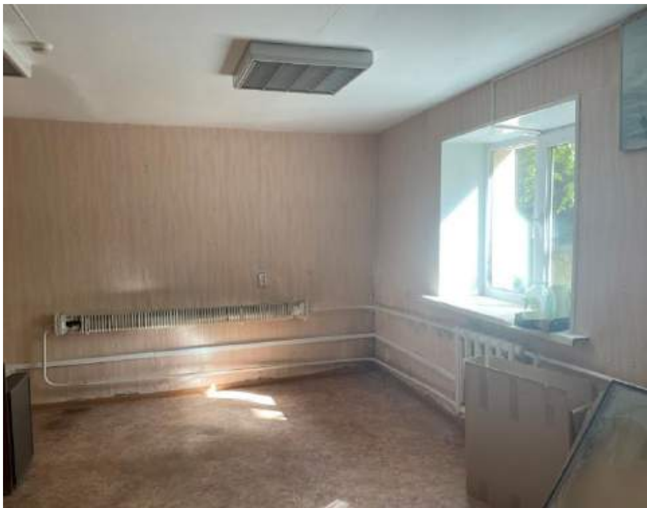
Фото 41. Выявленный объект культурного наследия «Дом купца А.Н. Якушева» по адресу: Челябинская обл., г. Верхний Уфалей, Каслинская ул., 1. Интерьер выявленного объекта культурного наследия. Помещение 8. Цокольный этаж.
