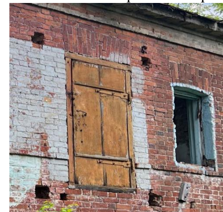
Оформление дверного и оконного проема северного фасада
