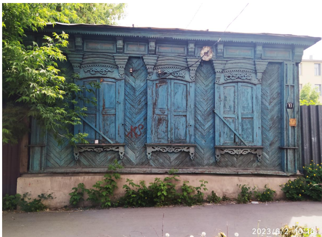
Выявленный Объект: г. Челябинск, ул. Красноармейская, 73. Фото июнь 2023г.
